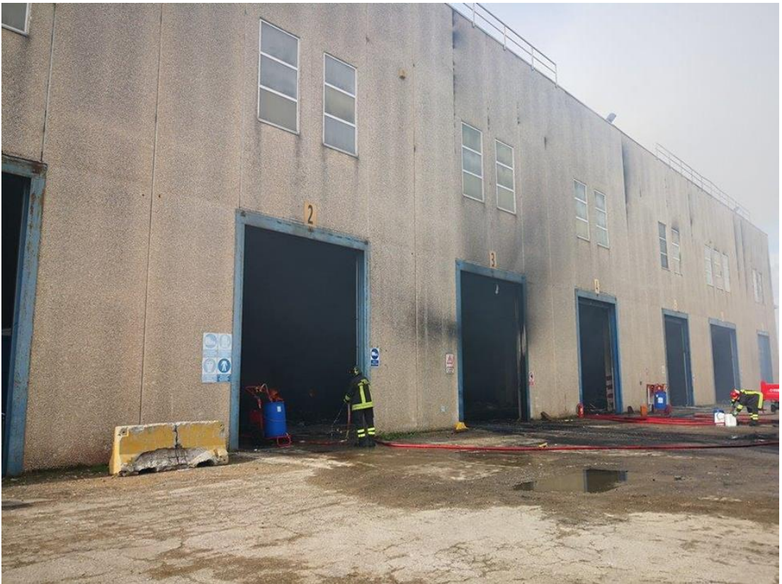
Figura 14: Incendio in un magazzino contenente materiale radioattivo (ARPA Toscana)
