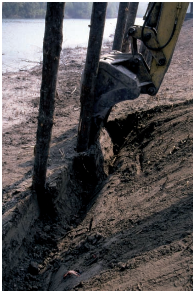
Rullo spondale in fibra di cocco, Tipologia A. Predisposizione della sede di posa (in opera) (Foto R.Ferrari).
