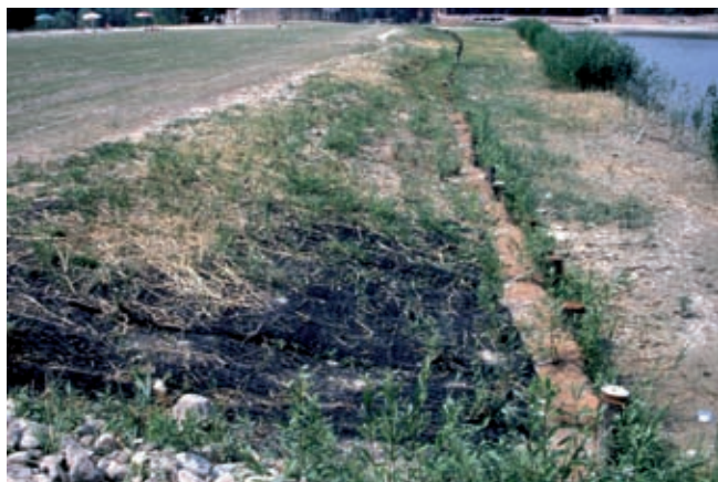
Rullo spondale in fibra di cocco, Tipologia A. Evoluzione all'inizio della prima stagione vegetativa (post operam) (Foto R.Ferrari).
