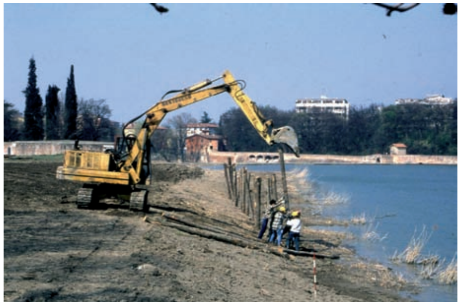
Rullo spondale in fibra di cocco, Tipologia A. Infissione verticale di tronchi (in opera) (Foto R.Ferrari).
