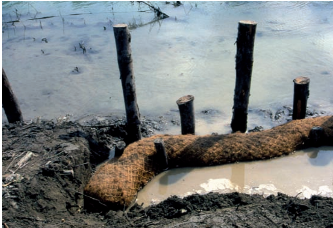
Rullo spondale in fibra di cocco, Tipologia A. Compenetrazione di elemento ("rullo") nella sponda (in opera) (Foto R.Ferrari).
