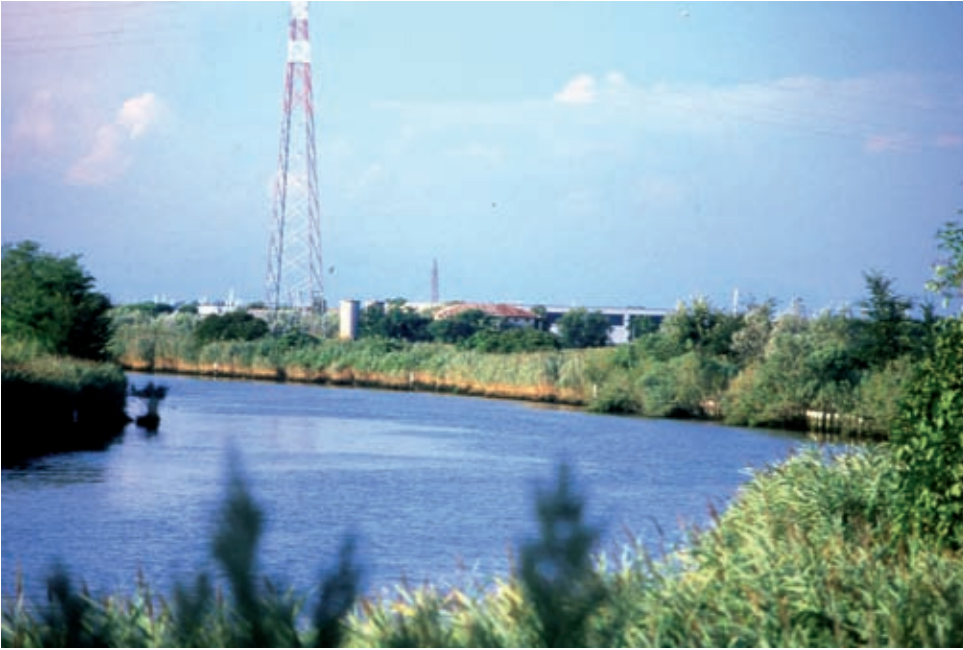
Rullo spondale in fibra di cocco. Tipica situazione di dissesto risolvibile mediante questa tipologia (Tipologia B) di intervento (post operam) (Foto R.Ferrari).
