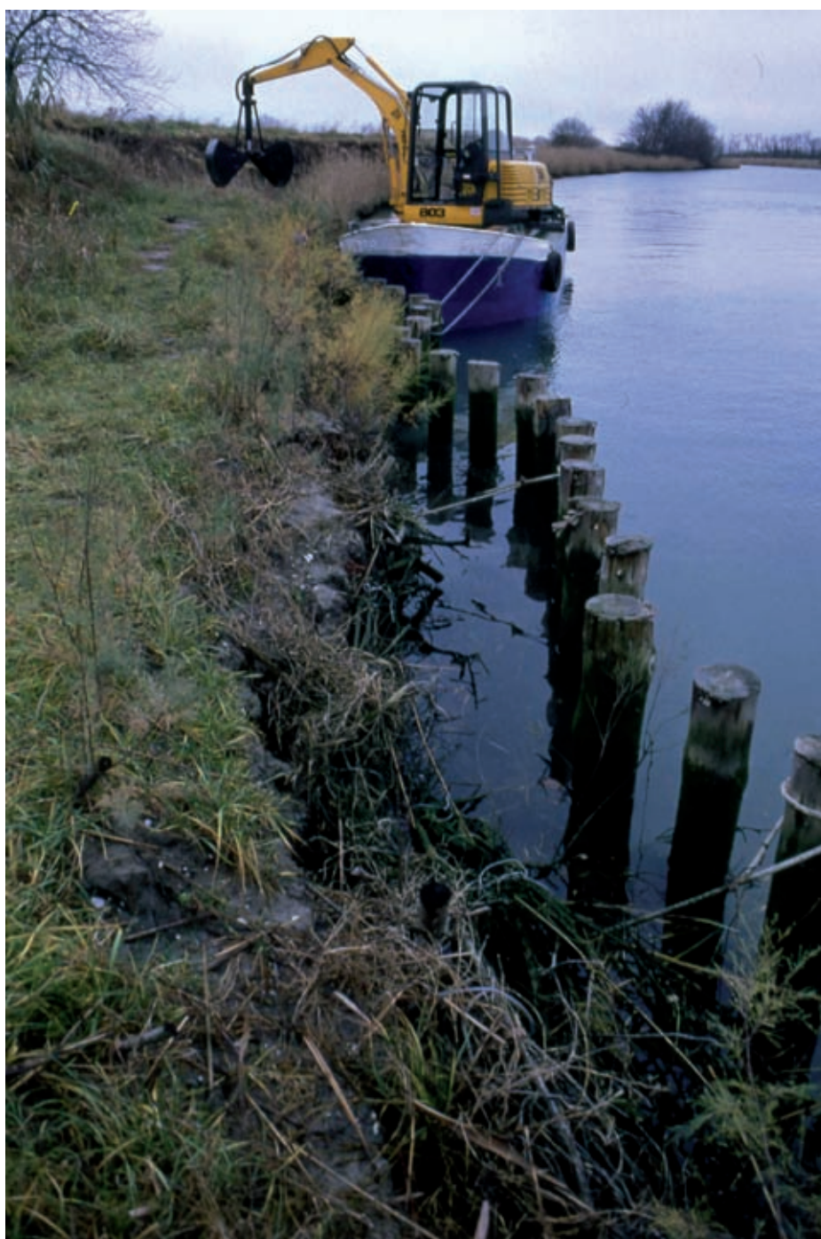
Rullo spondale in fibra di cocco, Tipologia B. Infissione verticale di tronchi (in opera) (Foto R.Ferrari).
