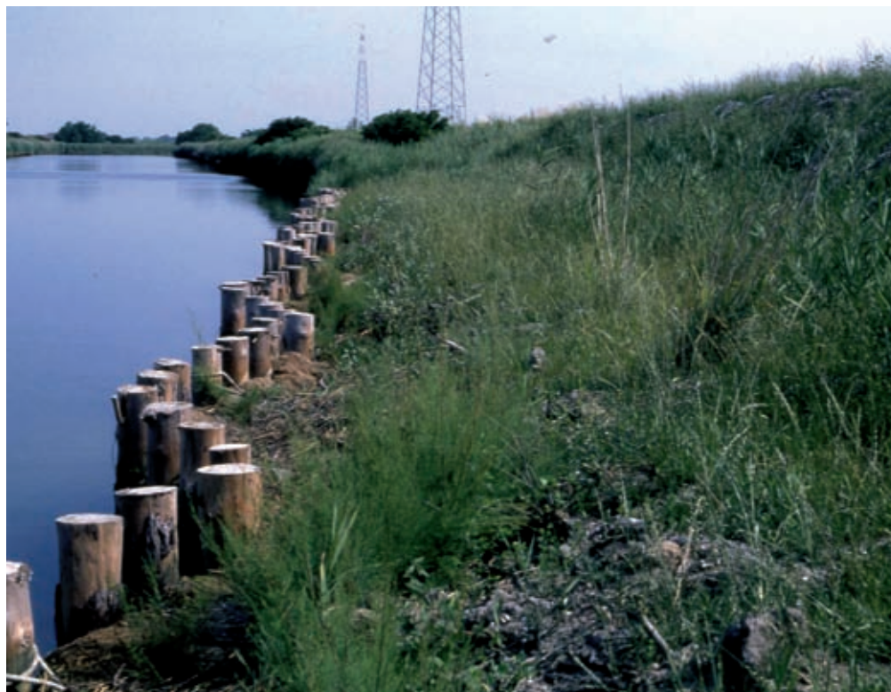
Rullo spondale in fibra di cocco, Tipologia B. Realizzazione della Tipologia B (post operam) (Foto R.Ferrari).
