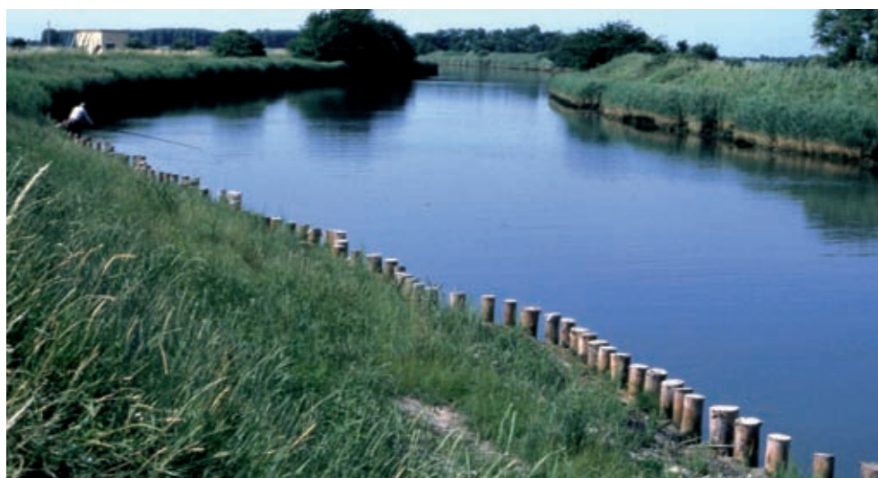
Rullo spondale in fibra di cocco, Tipologia B. Evoluzione all'inizio della prima stagione vegetativa (post operam) (Foto R.Ferrari).
