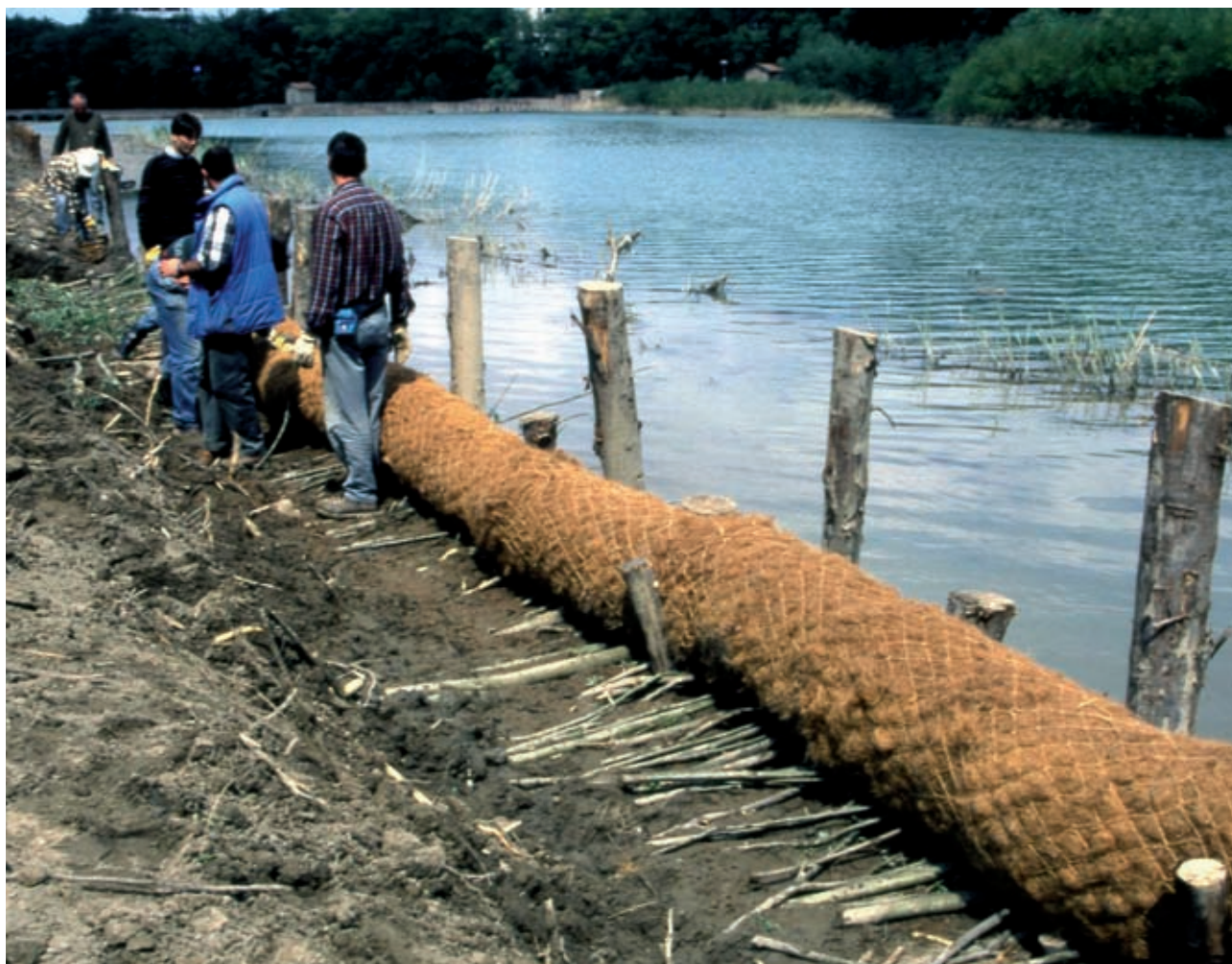
Rullo spondale in fibra di cocco, Tipologia A. Posa e fissaggio del secondo ordine di elementi ("rulli") (in opera) (Foto R.Ferrari).
