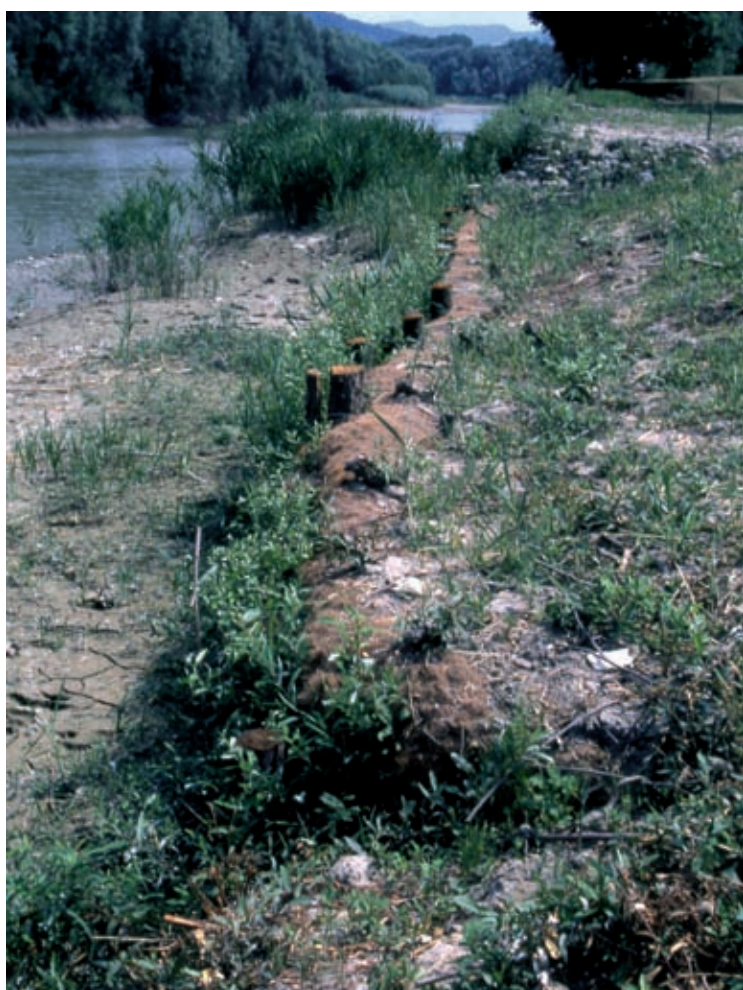
Rullo spondale in fibra di cocco, Tipologia A. Realizzazione della Tipologia A (post operam) (Foto R.Ferrari).
