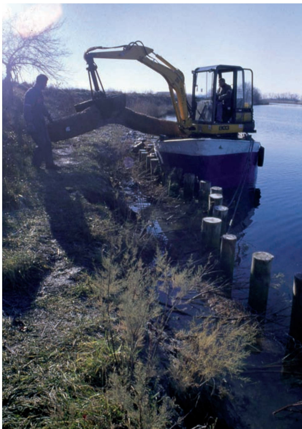
Rullo spondale in fibra di cocco, Tipologia B. Posa e fissaggio del primo ordine di elementi ("rulli") (in opera) (Foto R.Ferrari).
