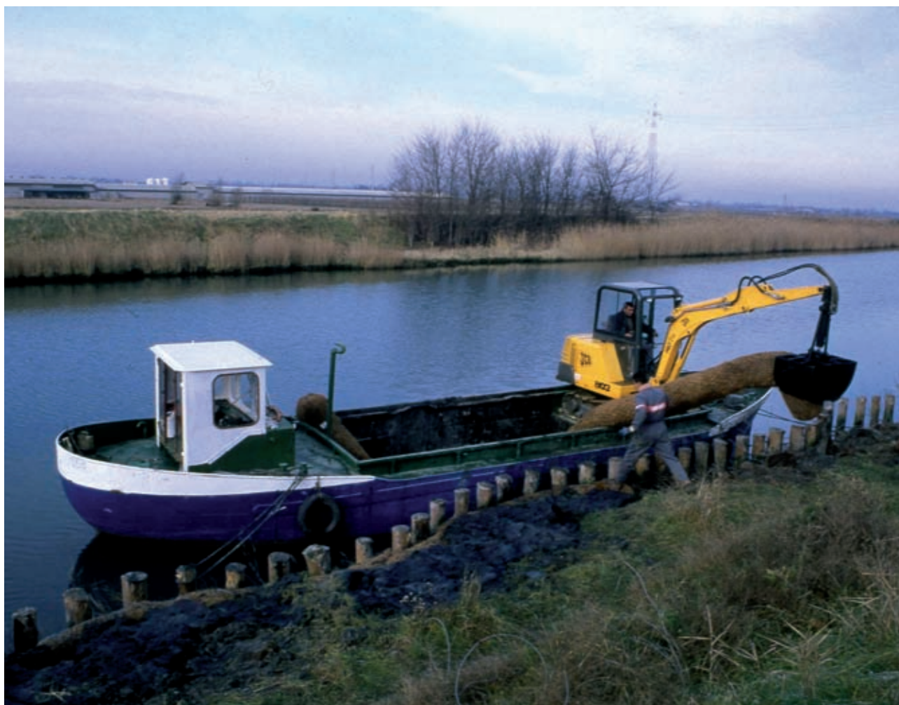
Rullo spondale in fibra di cocco, Tipologia B. Posa e fissaggio del secondo ordine di elementi ("rulli") (in opera) (Foto R.Ferrari).
