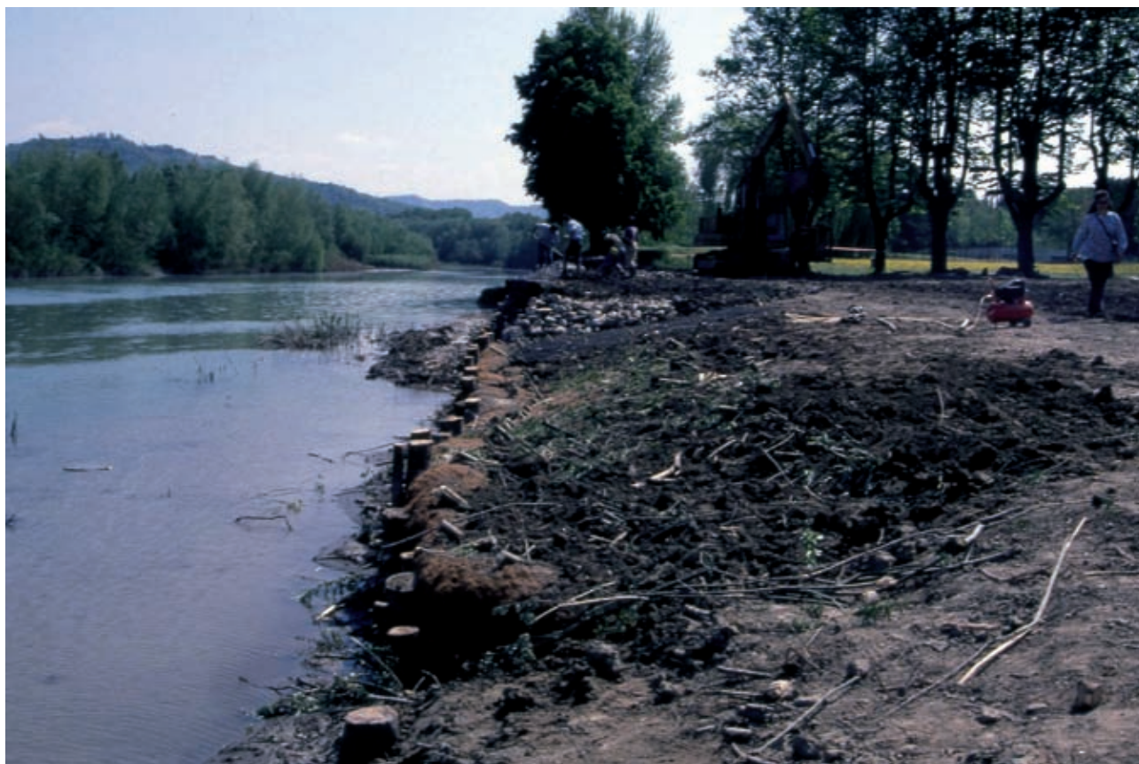
Rullo spondale in fibra di cocco, Tipologia A. Sistemazione finale dell'area di cantiere (in opera) (Foto R.Ferrari).
