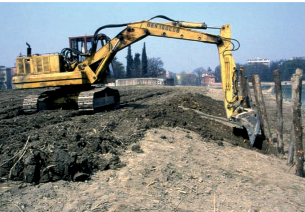
Rullo spondale in fibra di cocco, Tipologia A. Predisposizione della sede di posa (in opera) (Foto R.Ferrari).
