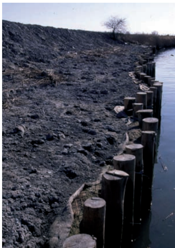
Rullo spondale in fibra di cocco, Tipologia B. Riempimento con materiale derivato da dragaggio (in opera) (Foto R.Ferrari).
