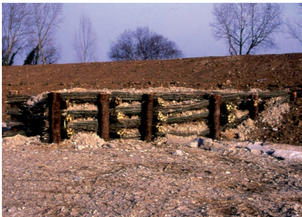
Repellente vivo di ramaglia a strati. Come si presenta la tipologia appena terminata la fase realizzativa di cantiere (post operam) (Foto R.Ferrari).
