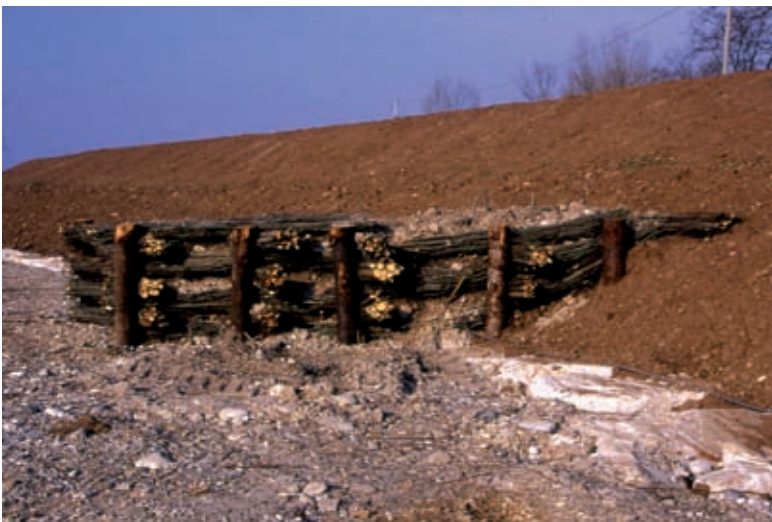
Repellente vivo di ramaglia a strati. Sistemazione finale dell'area di cantiere (in opera) (Foto R.Ferrari).
