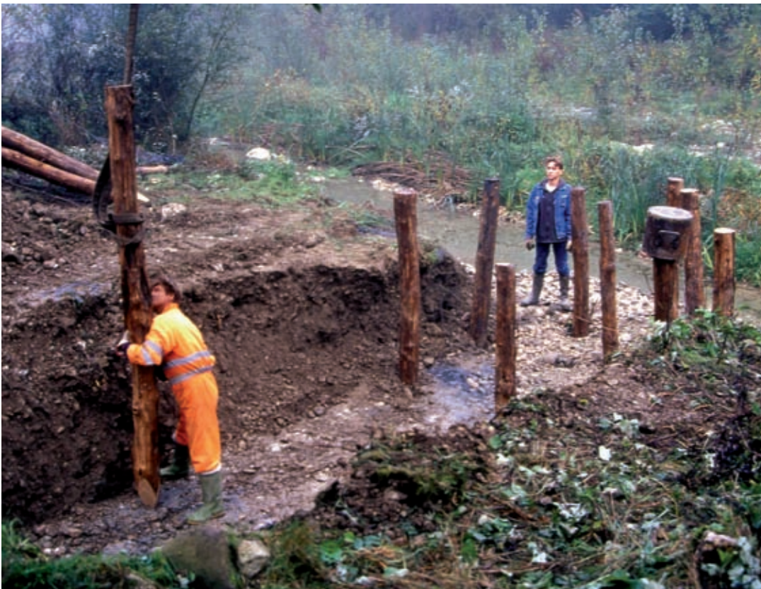
Repellente vivo di ramaglia a strati. Infissione verticale di tronchi (in opera) (Foto R.Ferrari).
