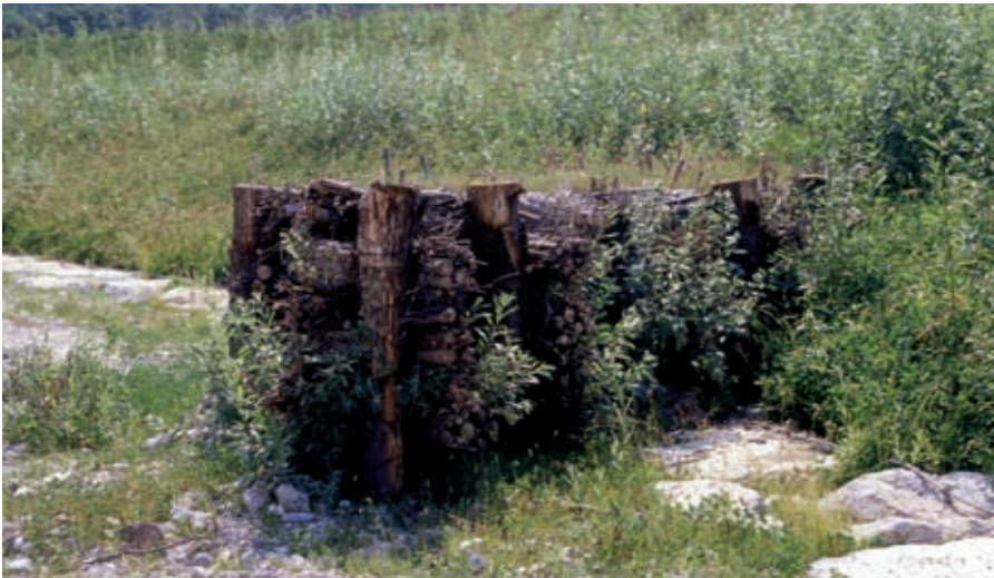
Repellente vivo di ramaglia a strati. Evoluzione all'inizio della prima stagione vegetativa (post operam) (Foto R. Ferrari).
