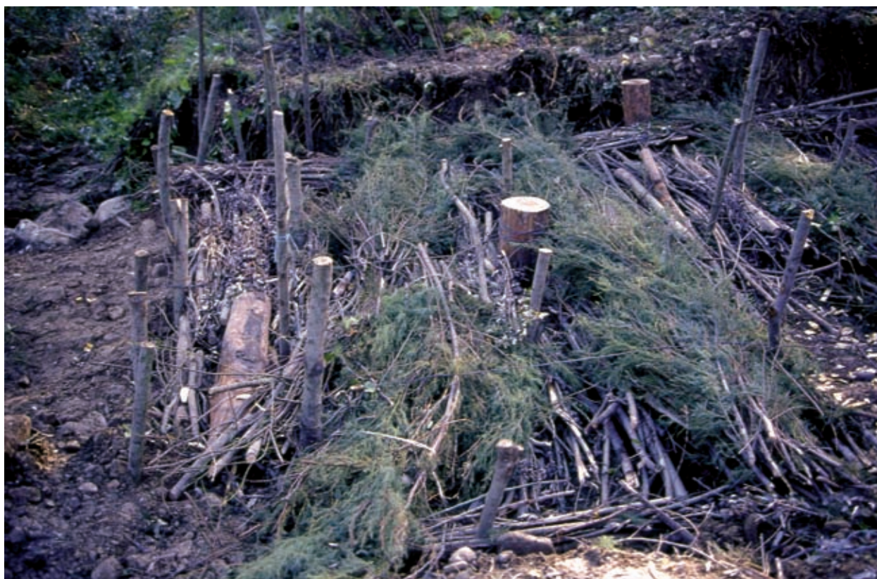
Repellente vivo di ramaglia a strati. Completamento della struttura (in opera) (Foto R.Ferrari).
