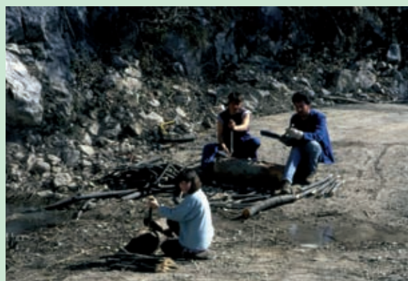
Preparazione di materiale vegetale vivo (talee) sul sito di intervento (Foto R.Ferrari).
