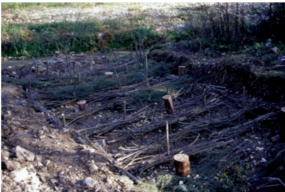
Repellente vivo di ramaglia a strati. Posa di fascine ortogonalmente alla direzione dell'opera (in opera) (Foto R.Ferrari).
