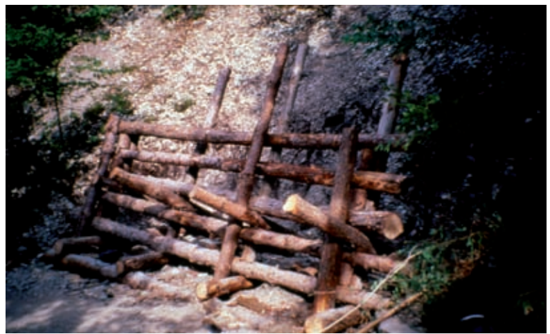
Palificata viva Roma (di versante). Parte interna della struttura lignea portante completata (in opera) (Foto R.Ferrari).
