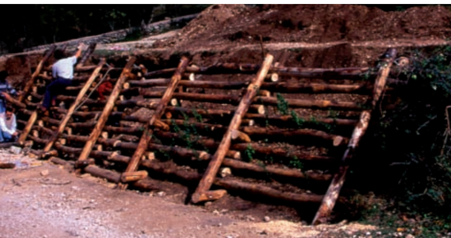
Palificata viva Roma (di versante). Riempimento con materiale inerte di riporto e contemporanea posa di materiale vegetale vivo (astoni di SALIX sp. ed arbusti in fitocella) (in opera) (Foto R.Ferrari).
