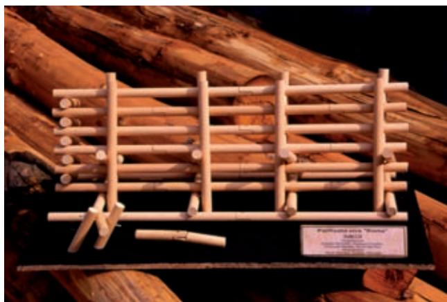
A sinistra: Palificata viva Roma (di versante). Modellino riprodotte la struttura lignea portante della tipologia (prospettiva) (Foto R.Ferrari). A destra: Palificata viva Roma (di versante). Modellino riprodotte la struttura lignea portante della tipologia (vista frontale) (Foto R.Ferrari).
