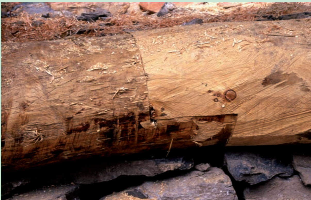
Unione di due tronchi contigui mediante incastro a sormonto e chiodatura (Foto R.Ferrari).
