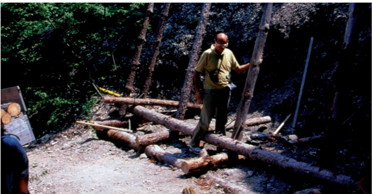
Palificata viva Roma (di versante). Controllo dell'inclinazione del tronco inclinato (montante interno) prima della posa del tronco inclinato (tirante) (in opera) (Foto R.Ferrari).
