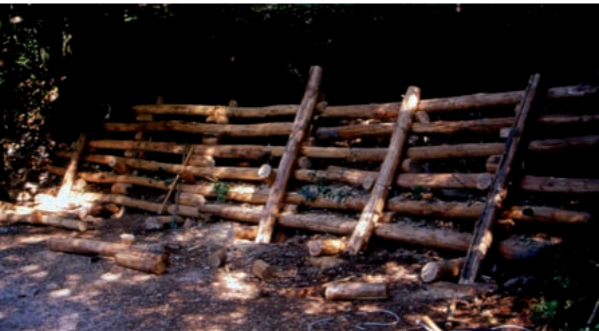
Palificata viva Roma (di versante). Riempimento con materiale inerte di riporto e contemporanea posa di materiale vegetale vivo (in opera) (Foto R.Ferrari).
