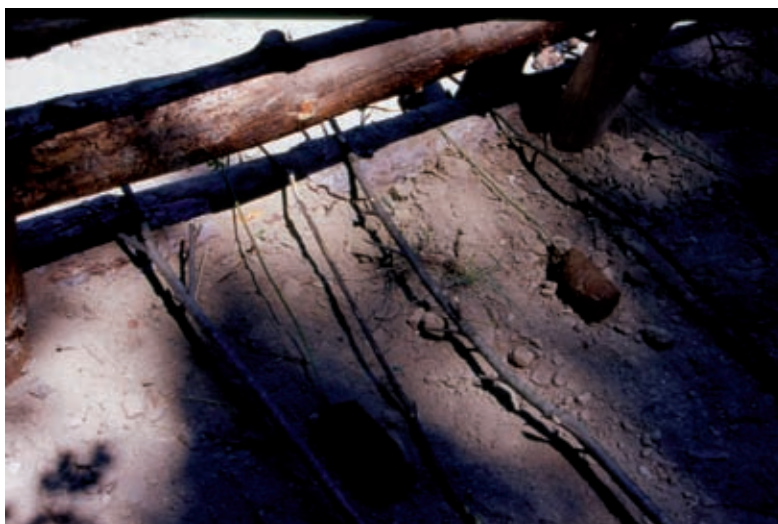
Palificata viva Roma (di versante). Riempimento con materiale inerte di riporto e contemporanea posa di materiale vegetale vivo (astoni di SALIX sp. ed arbusti in fitocella) (in opera) (Foto R.Ferrari).
