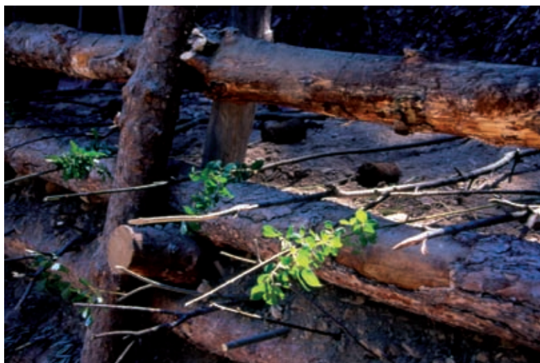
Palificata viva Roma (di versante). Riempimento con materiale inerte di riporto e contemporanea posa di materiale vegetale vivo (in opera) (Foto R.Ferrari).
