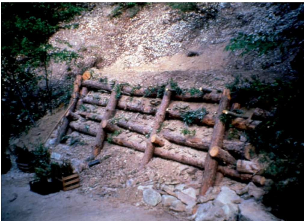
A sinistra: Palificata viva Roma (di versante). Modellino riprodotte la struttura lignea portante della tipologia (prospettiva) (Foto R.Ferrari). A destra: Palificata viva Roma (di versante). Modellino riprodotte la struttura lignea portante della tipologia (vista frontale) (Foto R.Ferrari).
