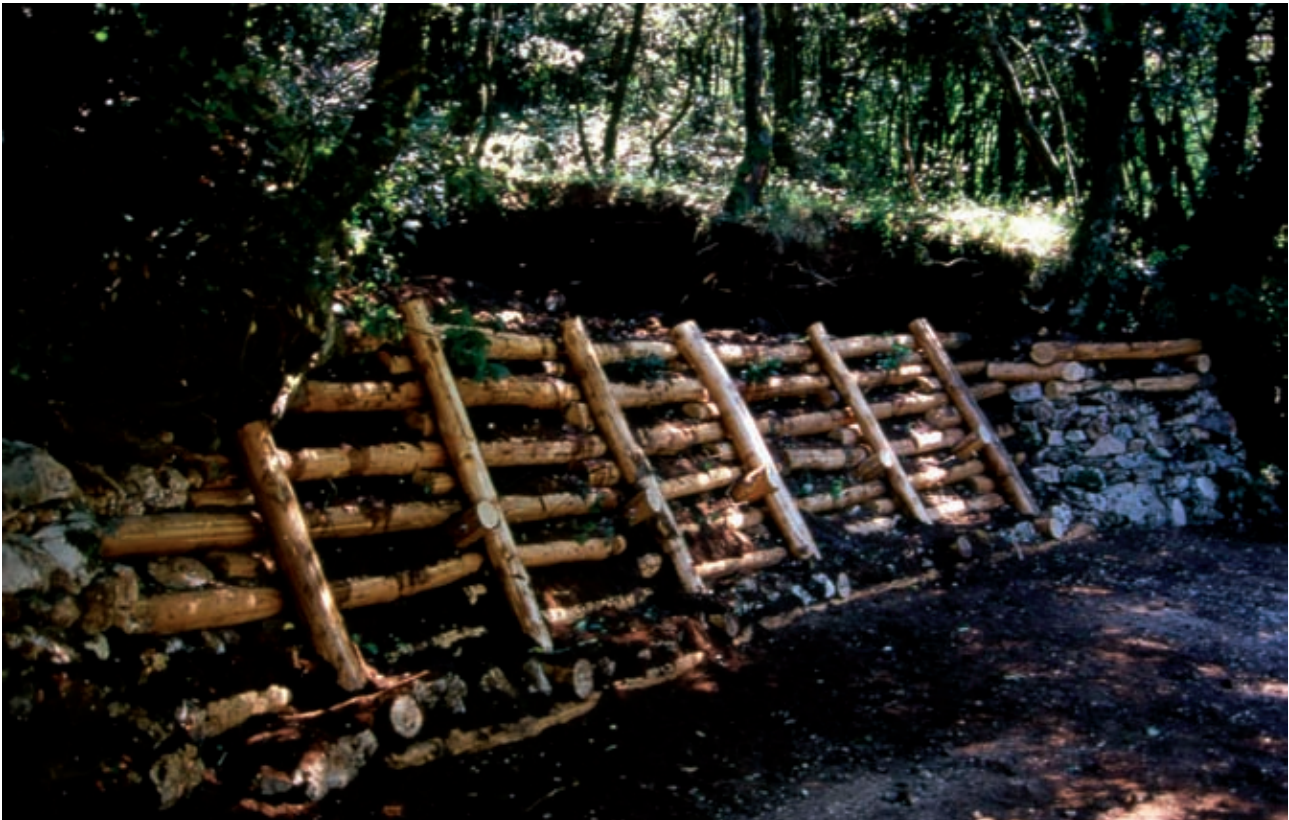
Palificata viva Roma (di versante). Raccordi laterali della struttura con la morfologia preesistente (in opera) (Foto R.Ferrari).
