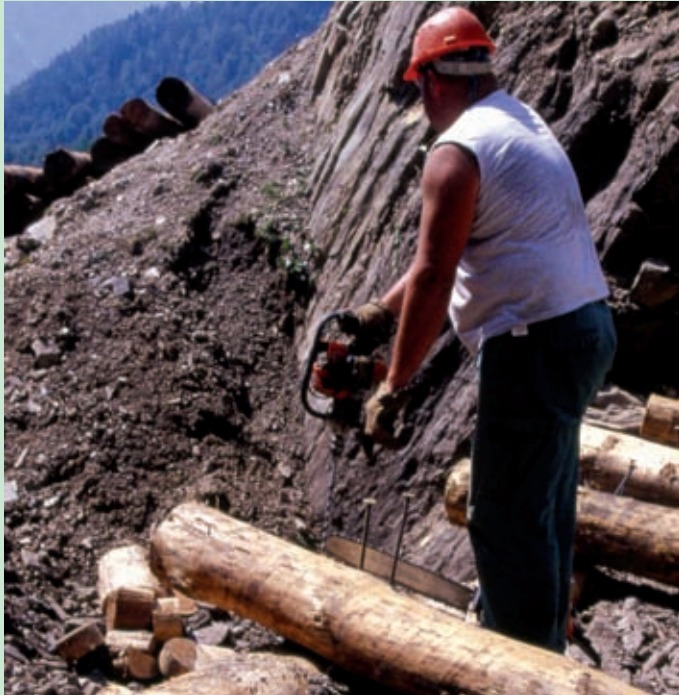
Esecuzione del foro (Foto R.Ferrari).
