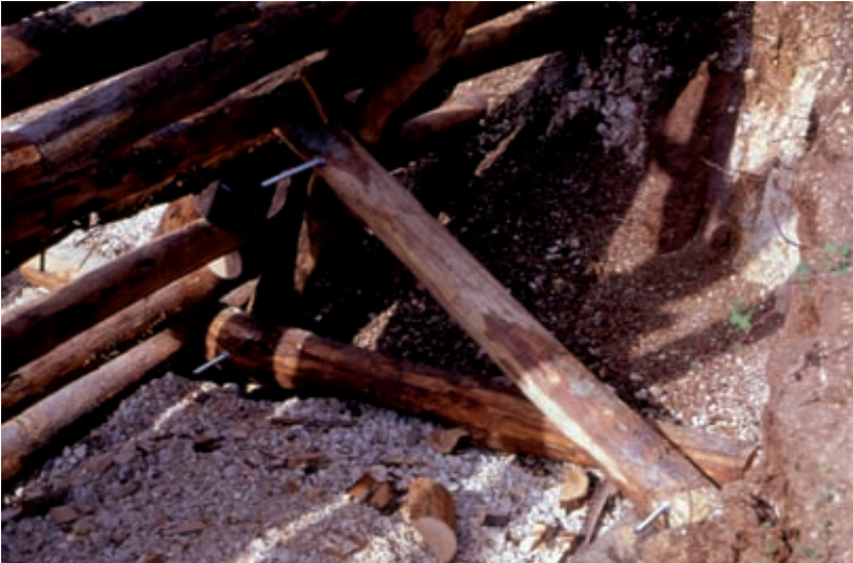
Palificata viva Roma (di versante). Parte interna della struttura lignea portante completata (in opera) (Foto R.Ferrari).
