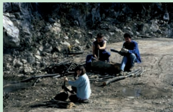
Preparazione di materiale vegetale vivo (talee) sul sito di intervento (Foto R.Ferrari).
