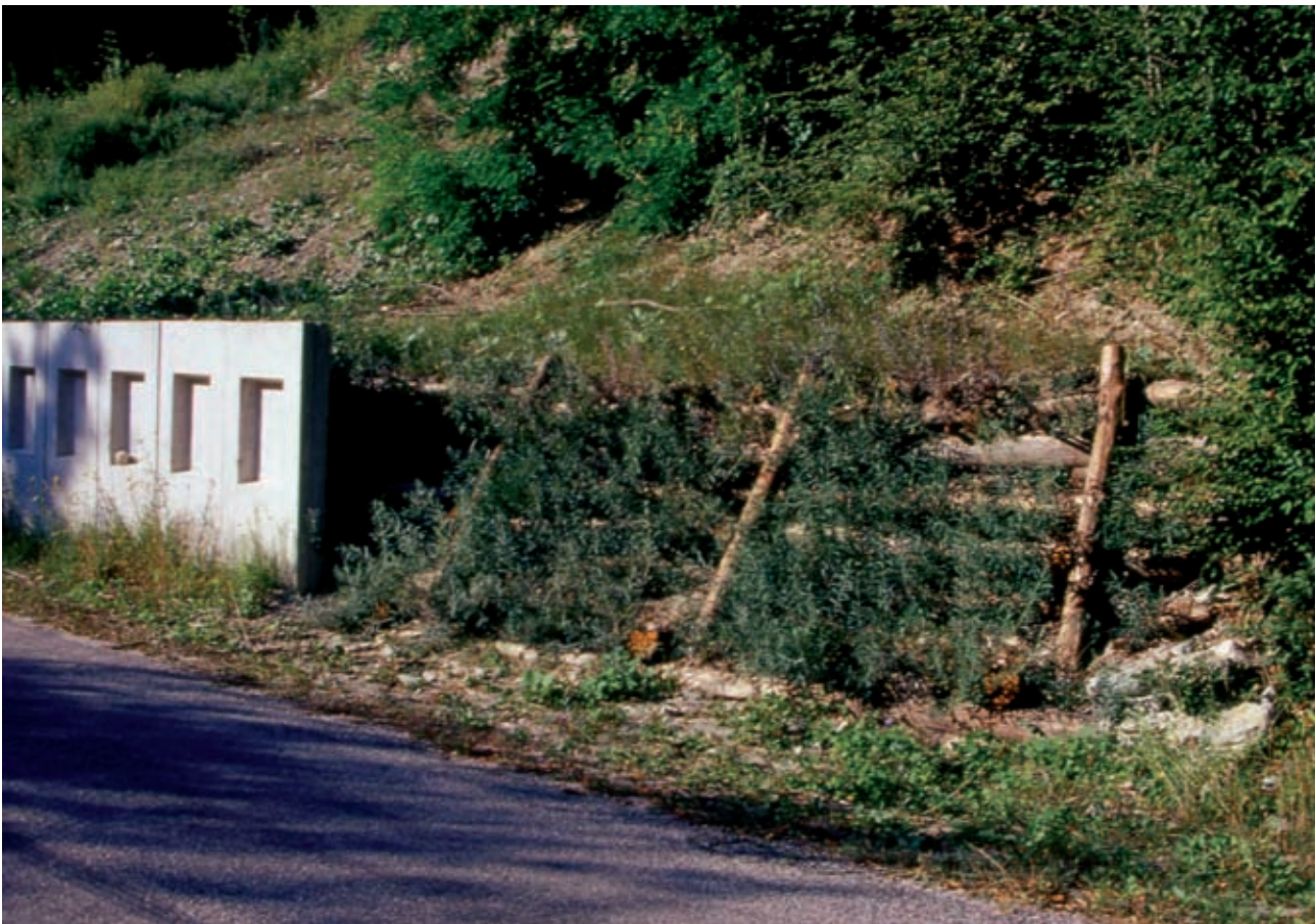
Palificata viva Roma (di versante). La tipologia a confronto con una soluzione tradizionale (post operam) (Foto R.Ferrari).
