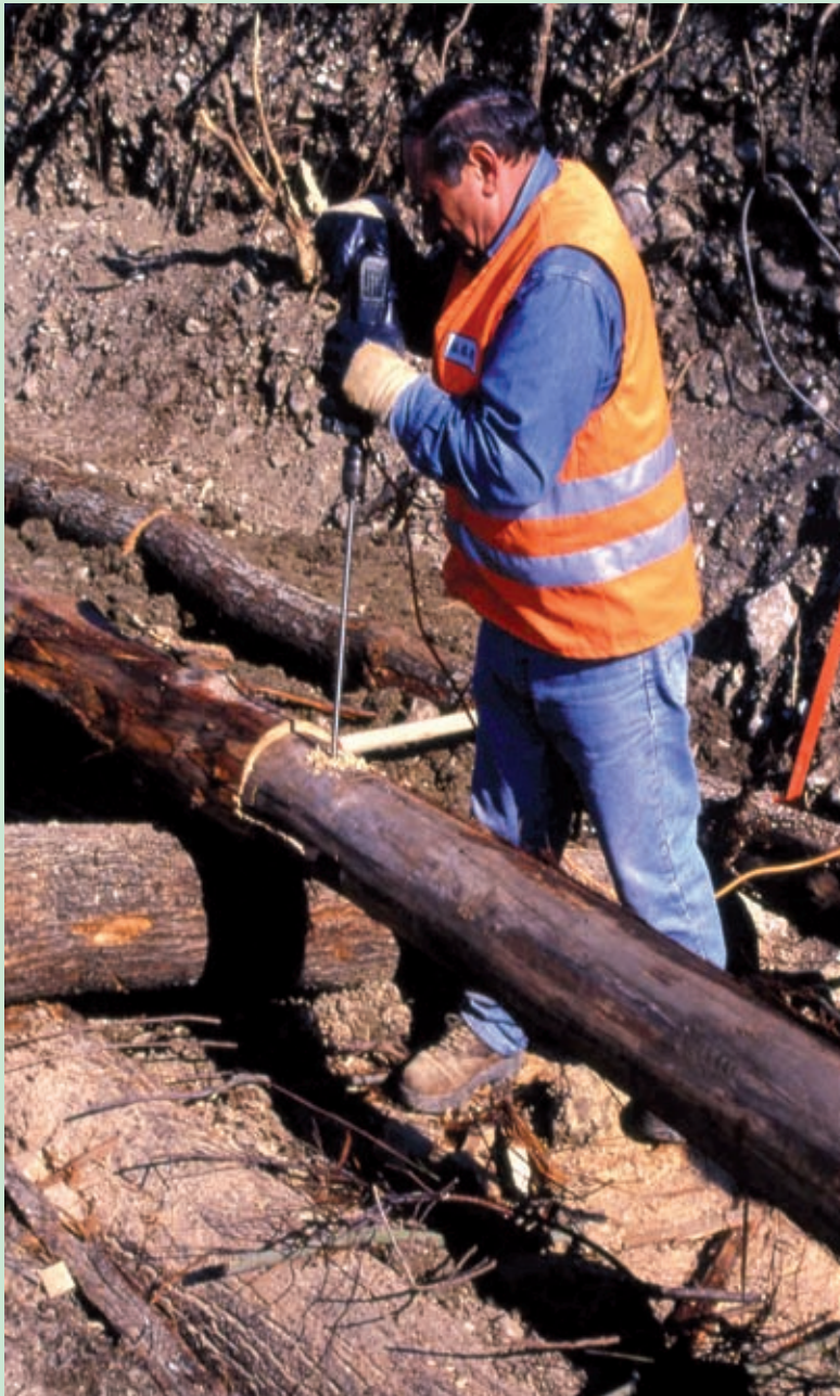
Esecuzione del foro (Foto R.Ferrari).
