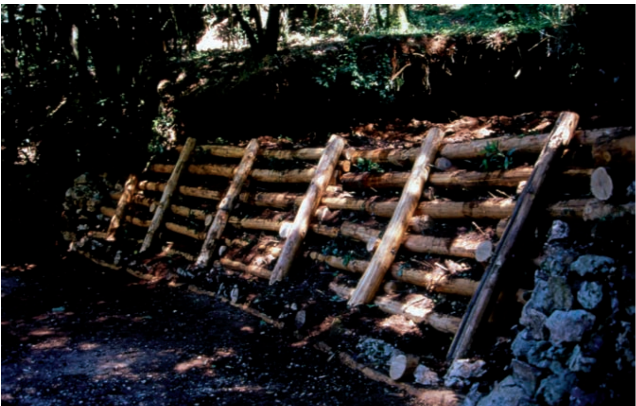
Palificata viva Roma (di versante). Sistemazione finale dell'area di cantiere (in opera). (Foto R.Ferrari).
