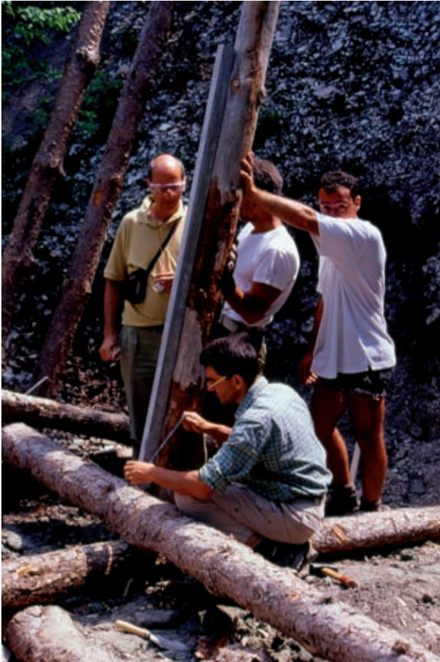
Palificata viva Roma (di versante). Controllo dell'inclinazione del tronco inclinato (montante interno) (in opera) (Foto A.Ferrari).
