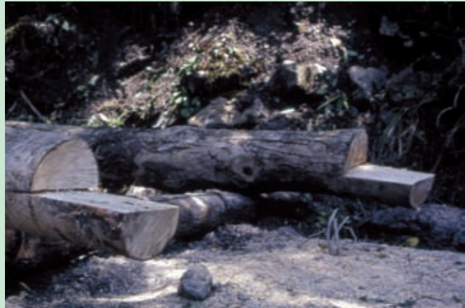
Posizionamento definitivo del primo elemento (Foto R.Ferrari).
