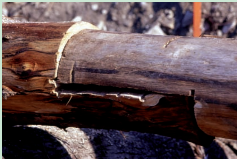
Combaciamento degli elementi (Foto R.Ferrari).
