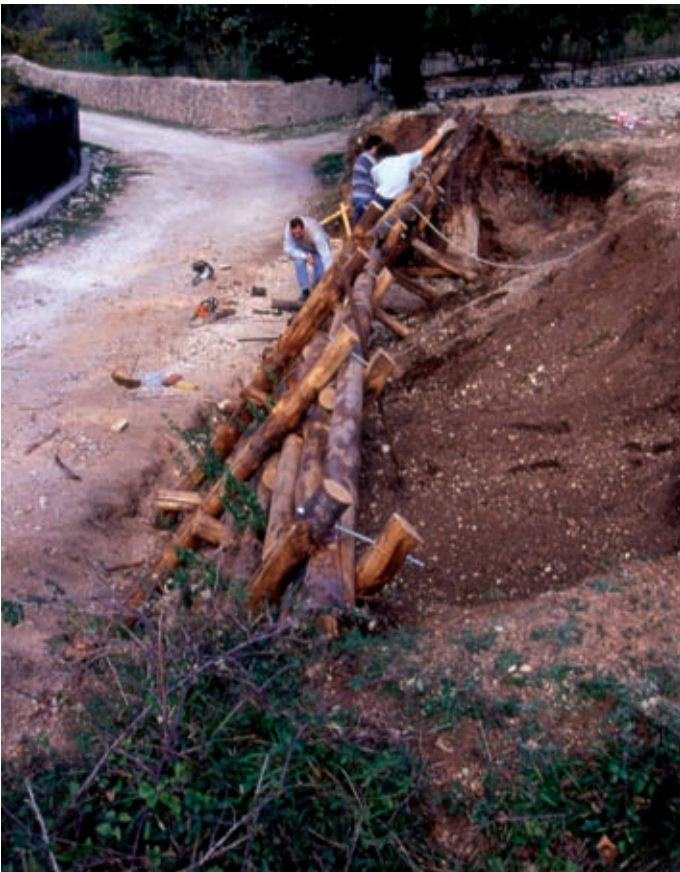
Palificata viva Roma (di versante). Completamento della struttura lignea portante (in opera) (Foto P.Cornelini).
