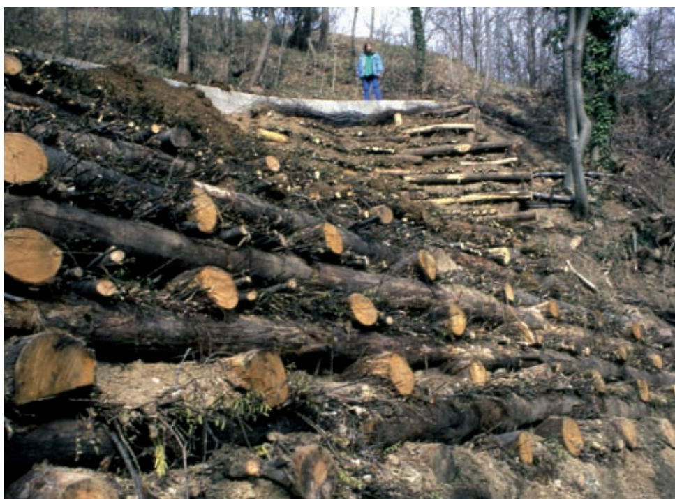
Palificata viva doppia (di versante). Come si presenta la tipologia appena terminata la fase realizzativa di cantiere (post operam) (Foto R.Ferrari).
