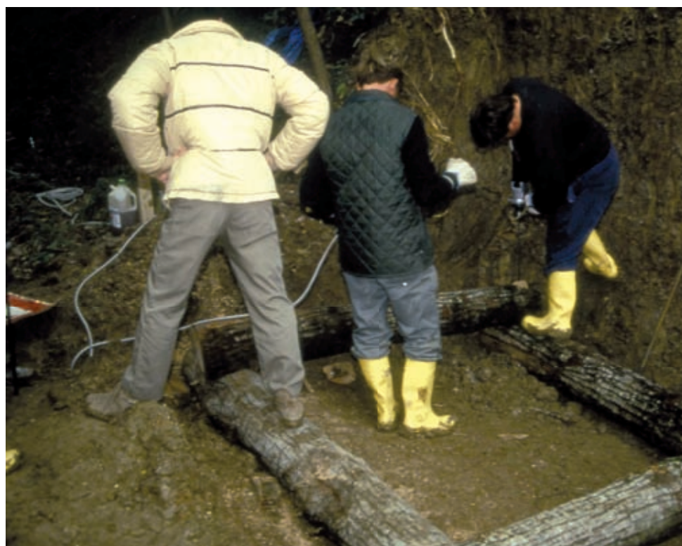
Palificata viva doppia (di versante). Fissaggio del primo ordine di tronchi trasversali (in opera) (Foto R.Ferrari).
