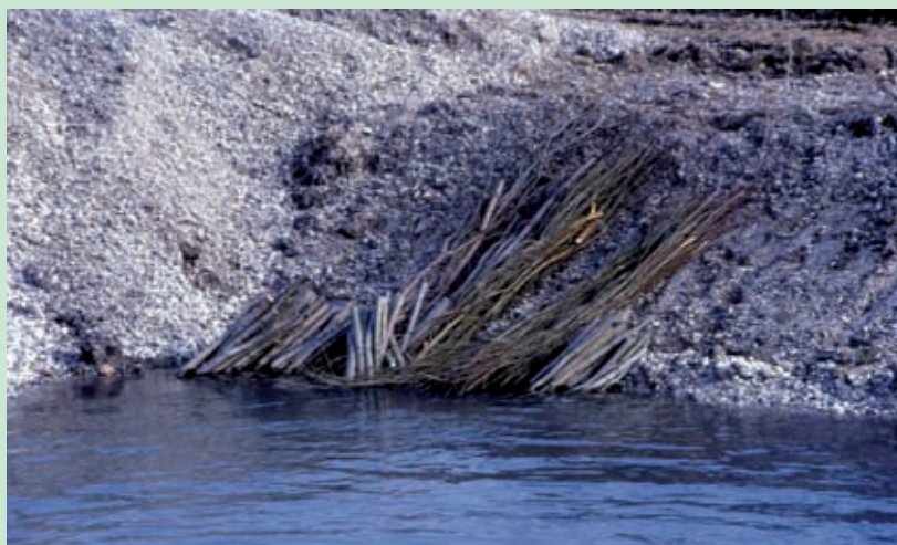
Stoccaggio in cantiere di materiale vegetale vivo (talee ed astoni) con la parte basale immersa in acqua (Foto R.Ferrari).
