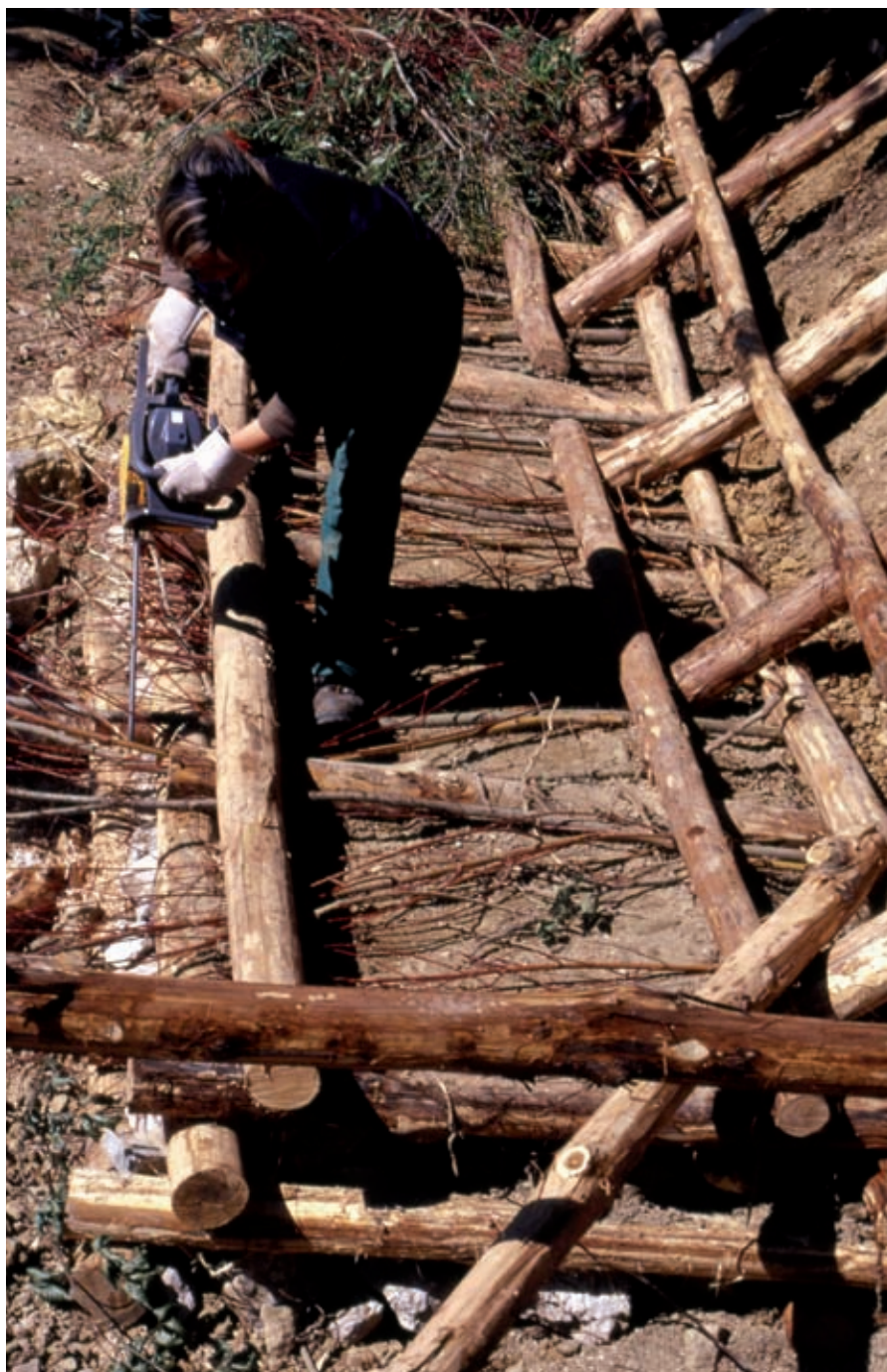
Palificata viva doppia (di versante). Dimensionamento definitivo del materiale vegetale vivo (astoni di SALIX PURPUREA) inserito nella costruenda struttura (in opera) (Foto R.Ferrari).
