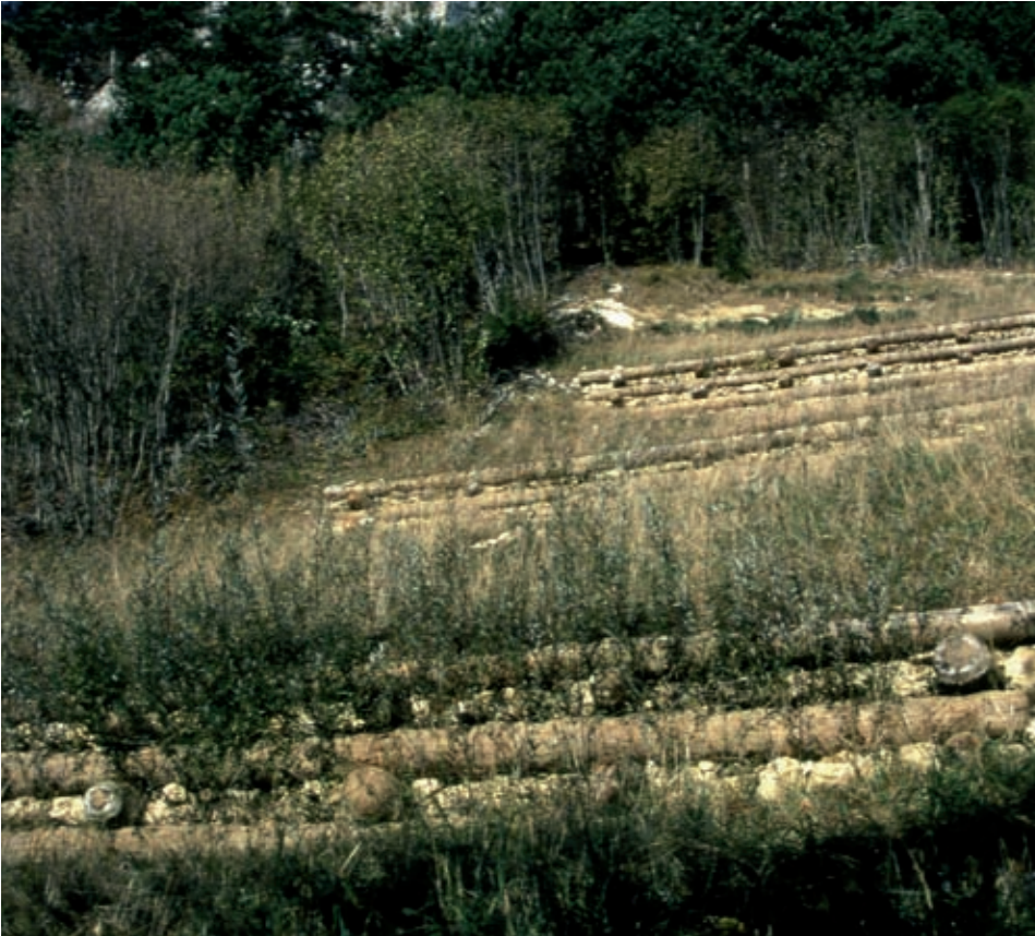
Palificata viva doppia (di versante). Realizzazione di più file sovrapposte (post operam) (Foto R.Ferrari).
