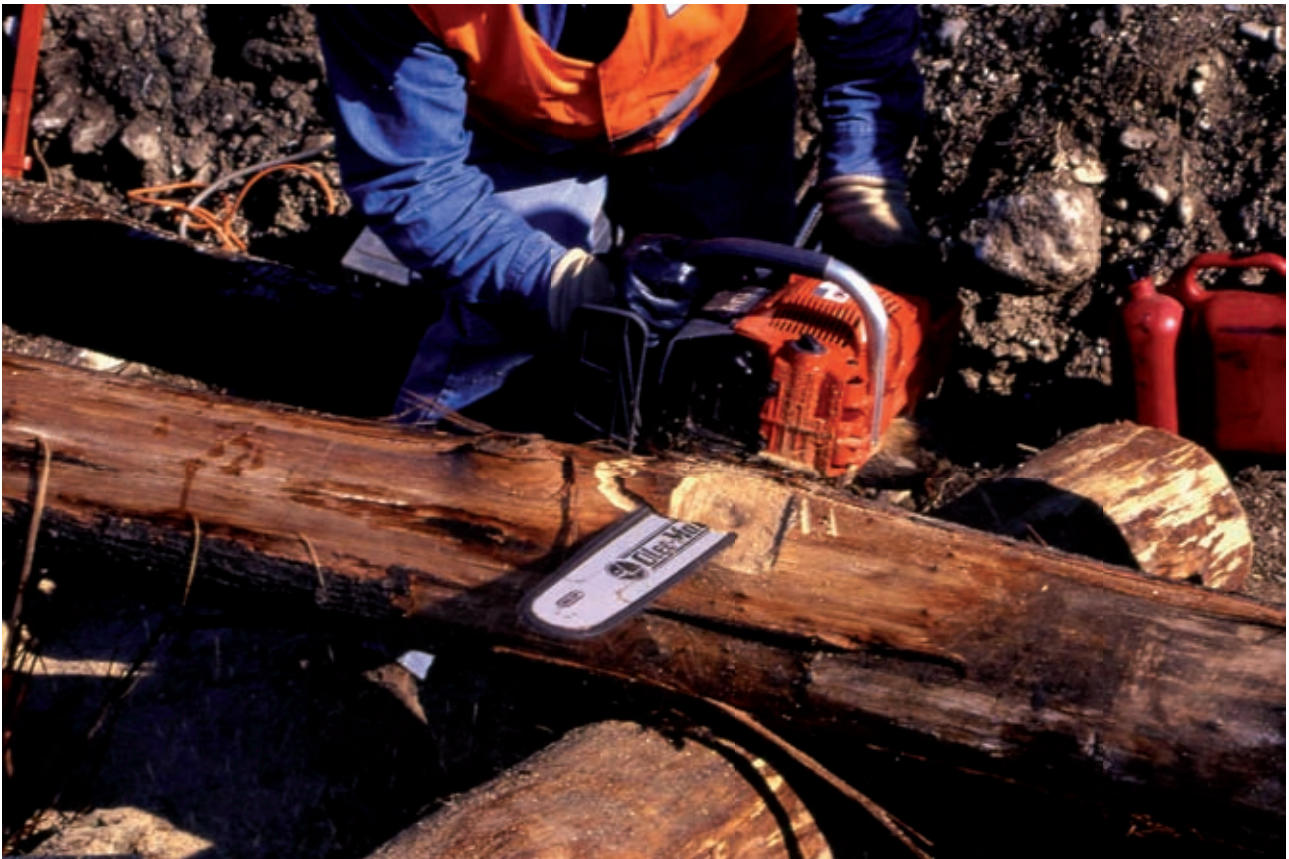
Palificata viva doppia (di versante). Realizzazione di tacca per sopperire a diametro troppo grosso (in opera) (Foto R.Ferrari).
