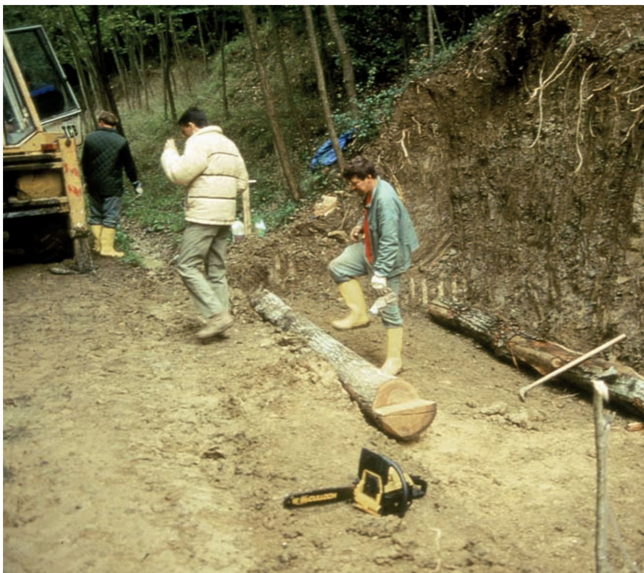
Palificata viva doppia (di versante). Posa del primo ordine di tronchi longitudinali (correnti) (in opera) (Foto R.Ferrari).
