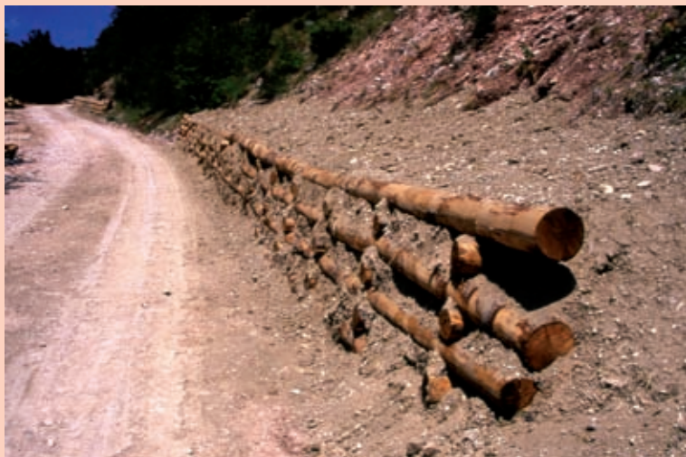
Palificata ?viva doppia (di versante). Inadeguata inclinazione (prossima alla verticale) della parete esterna, ma soprattutto totale assenza di materiale vegetale vivo: non può essere considerata un'opera di Ingegneria Naturalistica (post operam) (Foto R.Ferrari).
