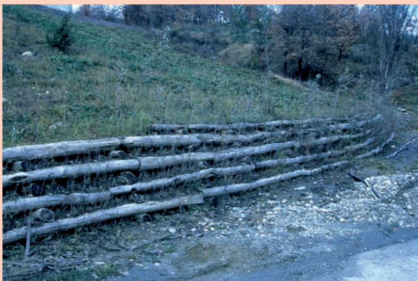
Palificata viva doppia (di versante). Mancanza di sfalsatura tra gli elementi delle file di tronchi longitudinali (correnti), nonché di incastri tra gli stessi (post operam) (Foto R.Ferrari).
