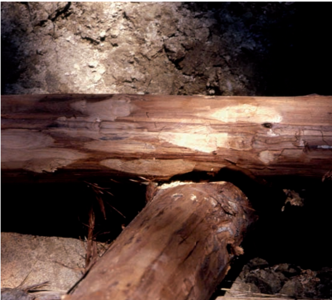
Palificata viva doppia (di versante). Realizzazione di tacca per sopperire a diametro troppo grosso (in opera) (Foto R.Ferrari).
