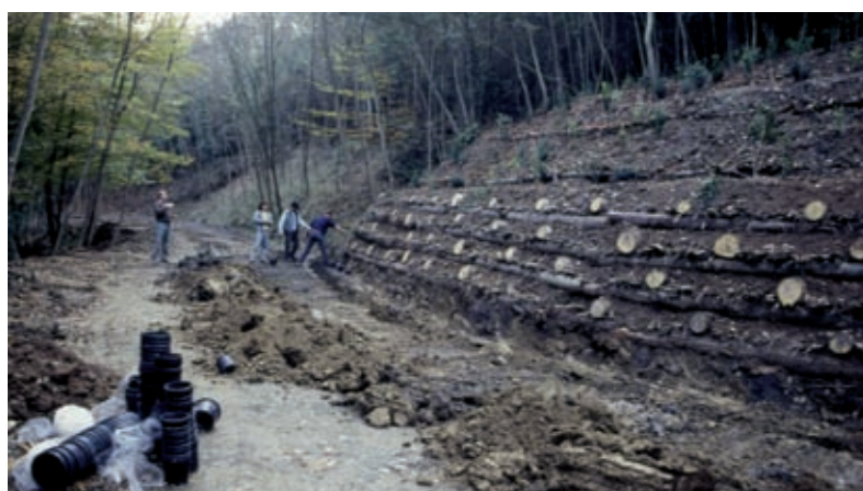
Palificata viva doppia (di versante). Operazioni di rifinitura e di bonifica dell'area di cantiere (in opera) (Foto R.Ferrari).
