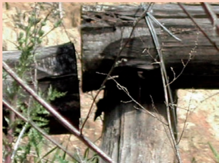
Palificata viva doppia (di versante). Fissaggio inadeguato mediante legatura con filo di ferro e mancanza di incastro tra gli elementi (tronchi) longitudinali (post operam) (Foto F.Gubernale).
