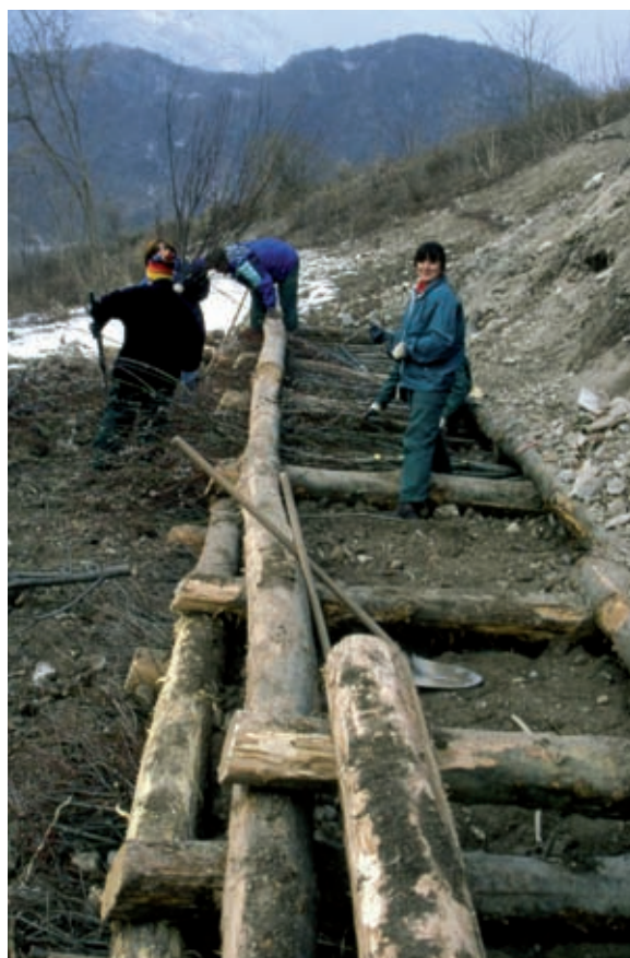
Palificata viva doppia (di versante). Arretramento delle file di tronchi longitudinali (correnti) rispetto alle sottostanti (in opera) (Foto R.Ferrari).
