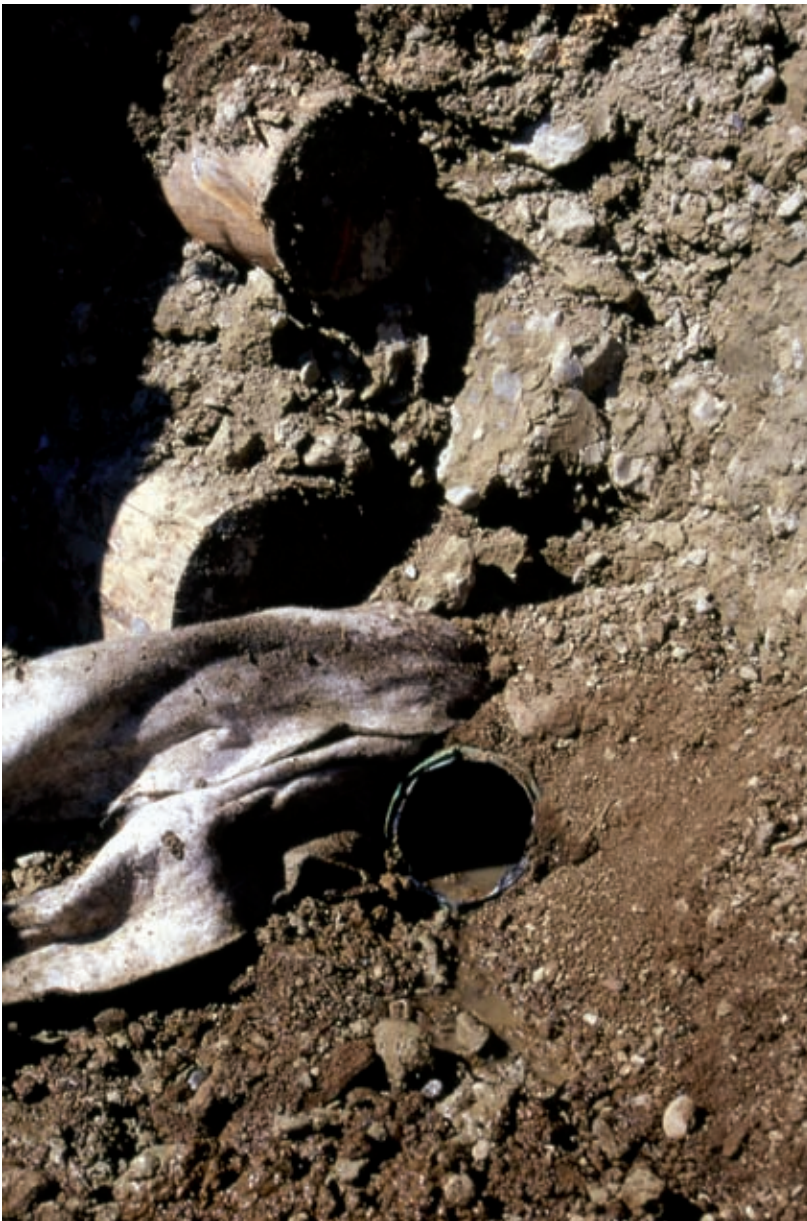
Palificata viva doppia (di versante). Sistema drenante tradizionale costituito da tubo microfessurato in PVC avvolto in geotessile, posizionato nella parte posteriore basale della struttura (in opera) (Foto R.Ferrari).
