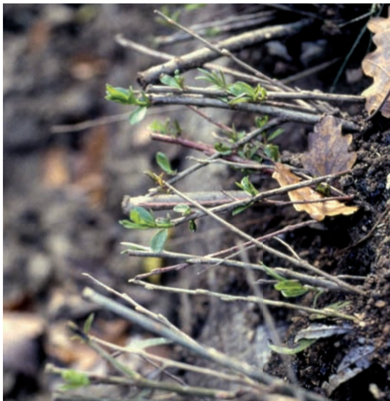
Palificata viva doppia (di versante). Emissione di getti apicali (in opera) (Foto R.Ferrari).
