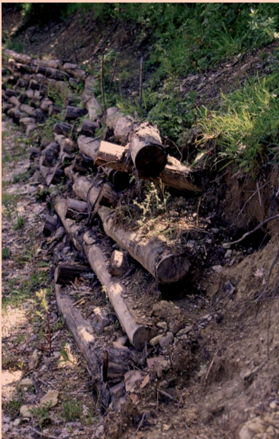
Palificata viva doppia (di versante). Mancanza di raccordo con la superficie morfologica. Inoltre mancato allineamento dei primi tronchi trasversali ed inadeguata inclinazione (maggiore di 60°) della parete esterna (post operam) (Foto R.Ferrari).
