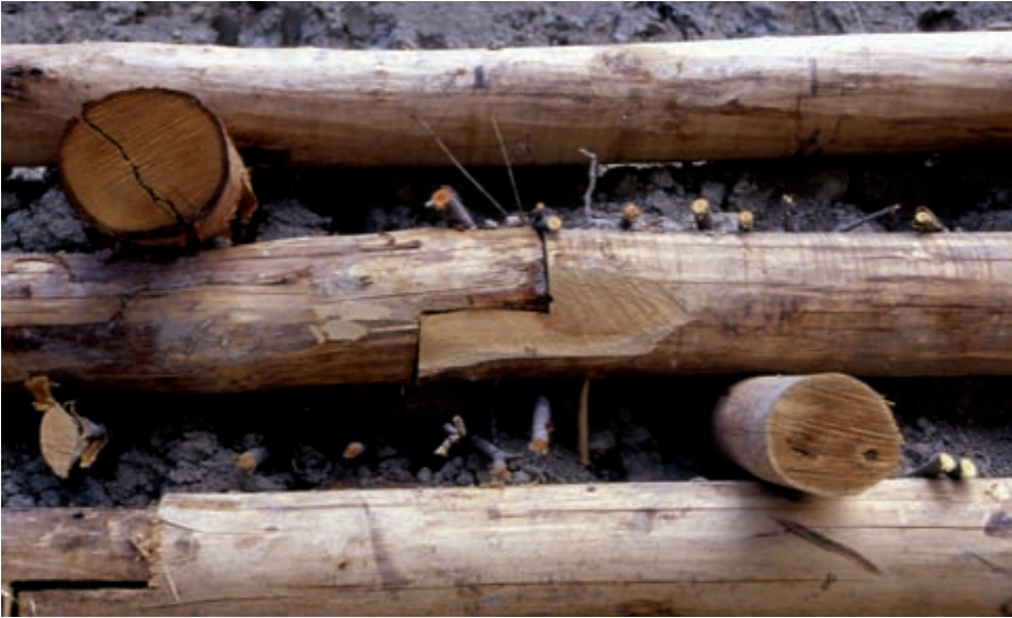
Palificata viva doppia (di versante). Distribuzione spaziale di incastri e di chiodature (in opera) (Foto R.Ferrari).
