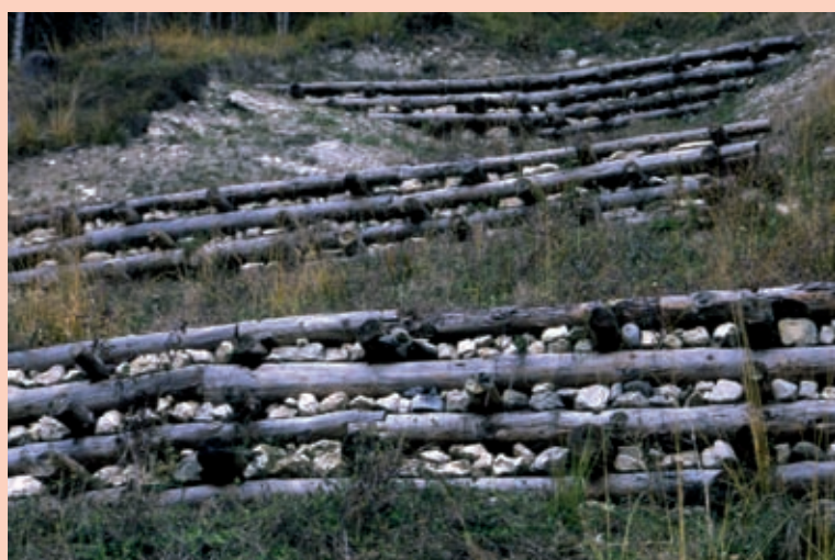
Palificata ?viva doppia (di versante). Facciata a vista costituita da pietrame e totale assenza di materiale vegetale vivo, senza possibilità di inserimento successivo: non può essere considerata un'opera di Ingegneria Naturalistica (ibidem, post operam) (Foto R.Ferrari).
