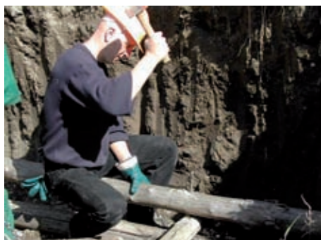
Palificata viva doppia (di versante). Fissaggio del secondo ordine di tronchi longitudinali (correnti) (in opera) (Foto F.Gubernale).
