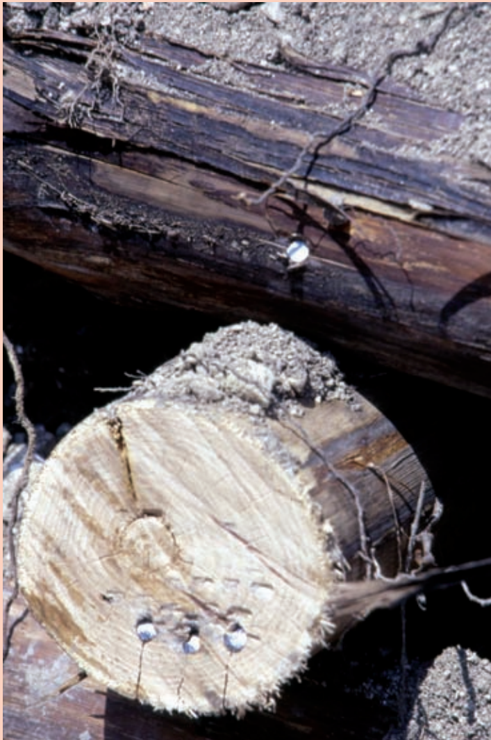
Palificata viva doppia (di versante). Chiodatura inadeguata sia tipologicamente sia dimensionalmente (post operam) (Foto R.Ferrari).
