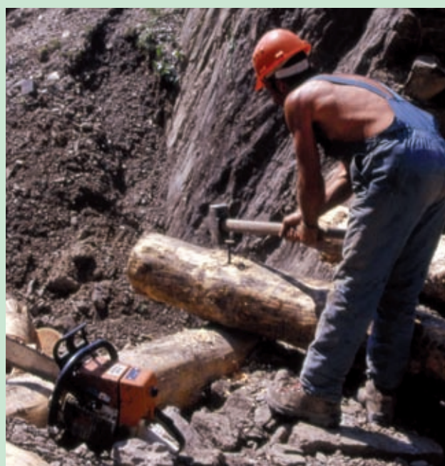
A sinistra: Esecuzione del foro. Sopra: Battitura del "chiodo" (Foto R.Ferrari).
