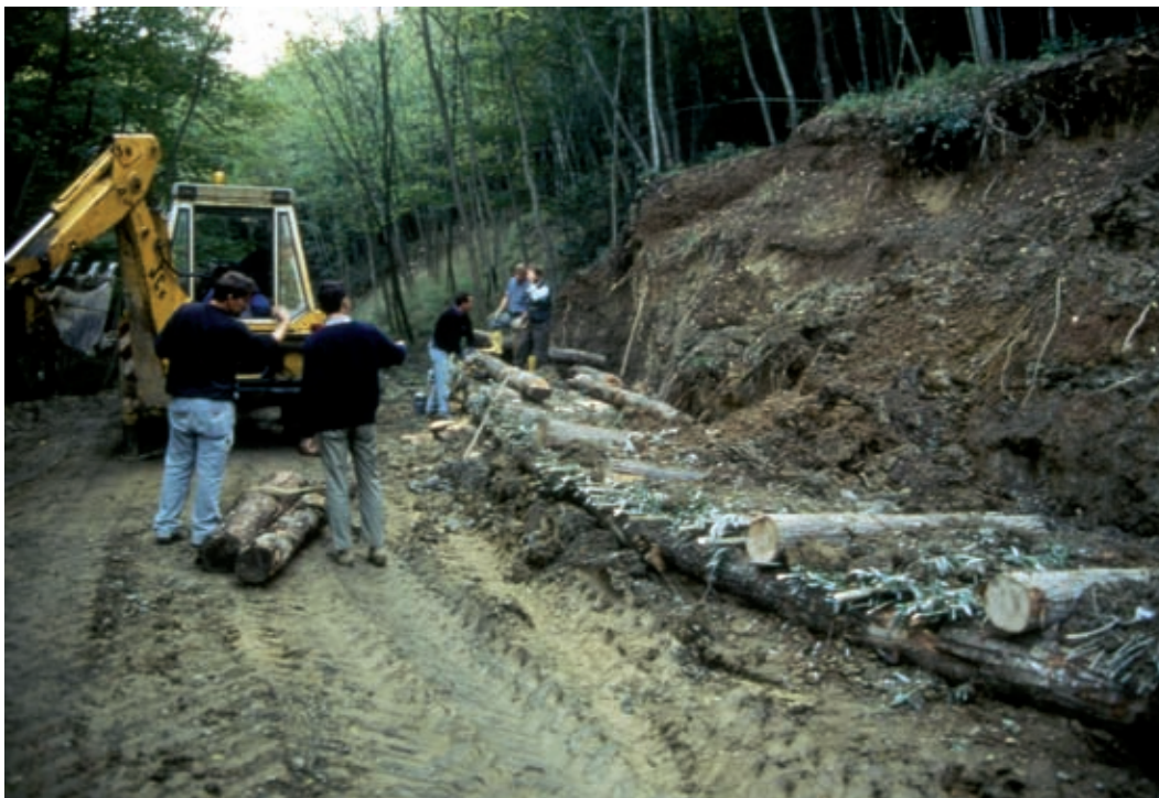
Palificata viva doppia (di versante). Completamento del secondo corso (in opera) (Foto R.Ferrari).
