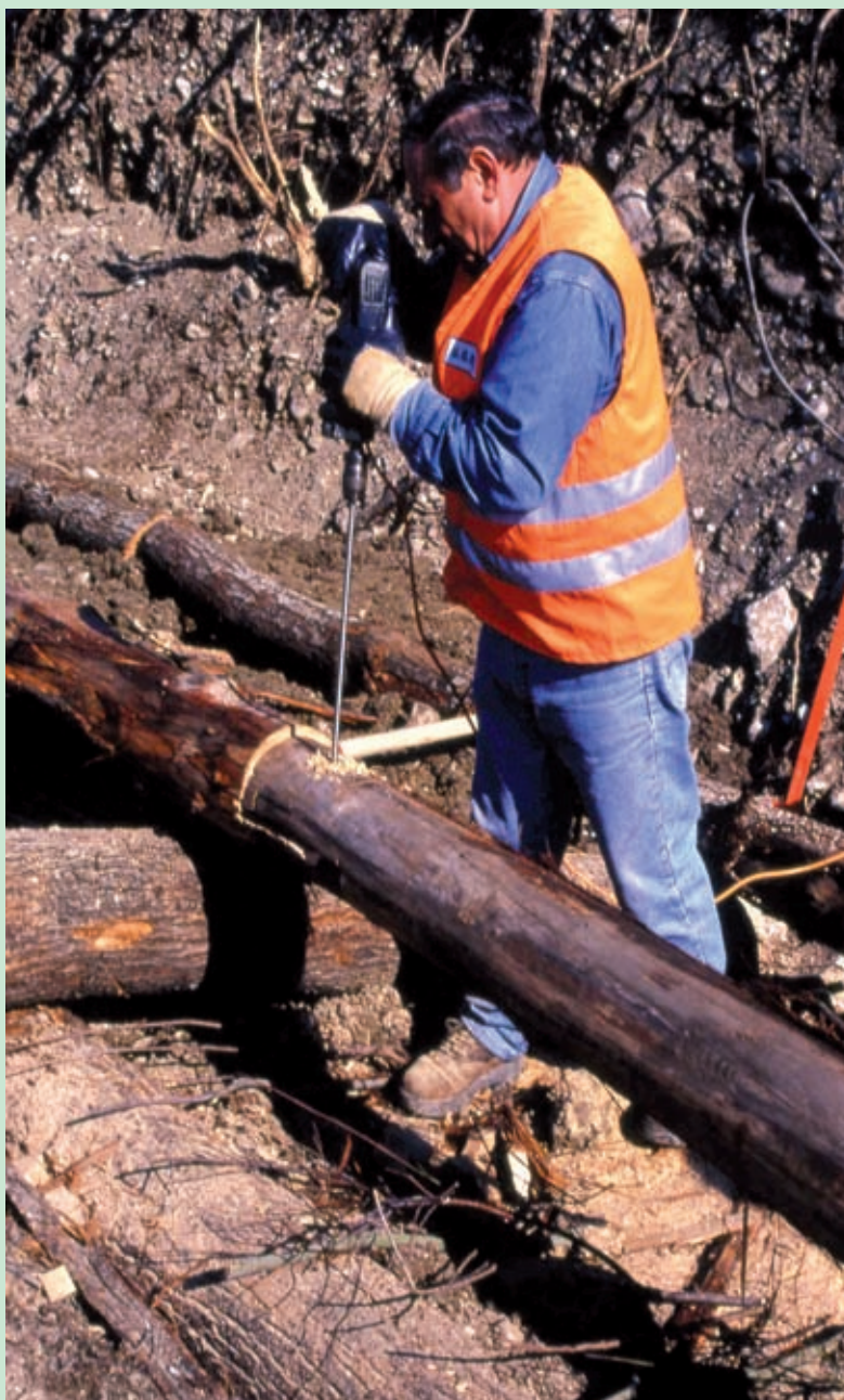
Esecuzione del foro (Foto R.Ferrari).
