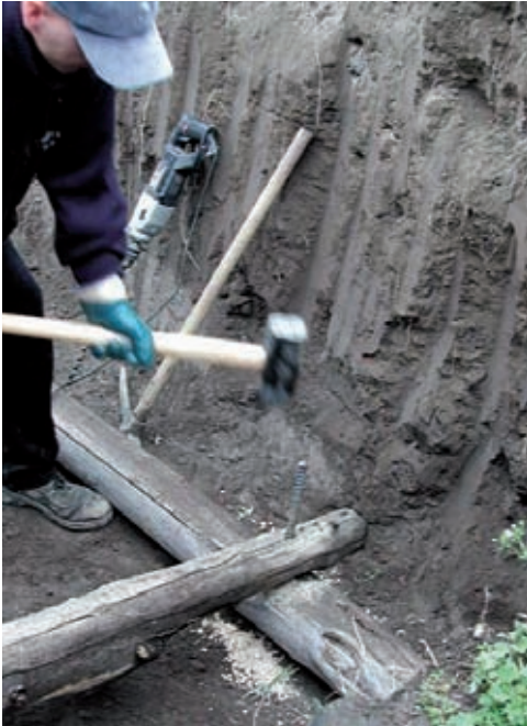
Palificata viva doppia (di versante). Fissaggio del primo ordine di tronchi trasversali (in opera) (Foto F.Gubernale).
