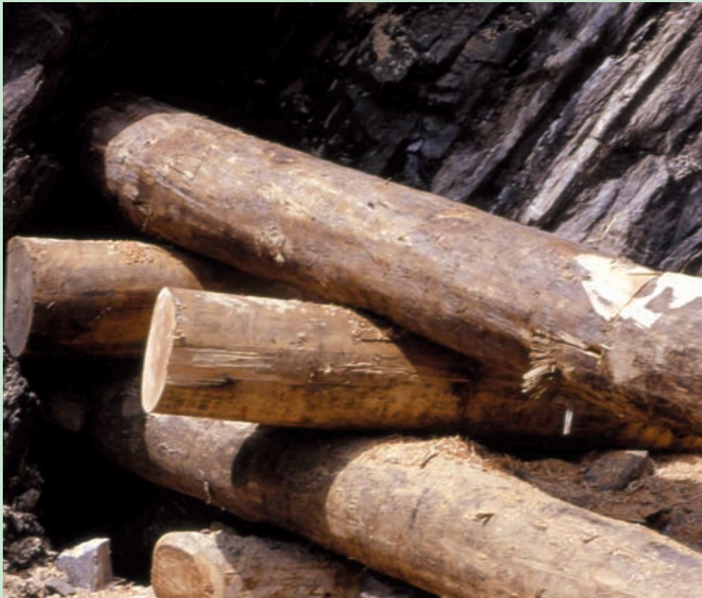
Unione di tronchi sovrapposti mediante chiodatura (Foto R.Ferrari).
