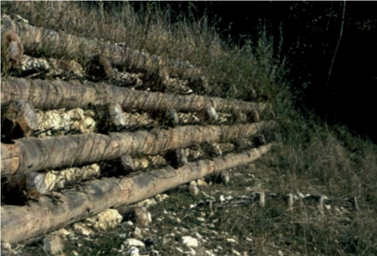
Palificata viva doppia (di versante). Utilizzo di pietrame a vista (post operam) (Foto R.Ferrari).
