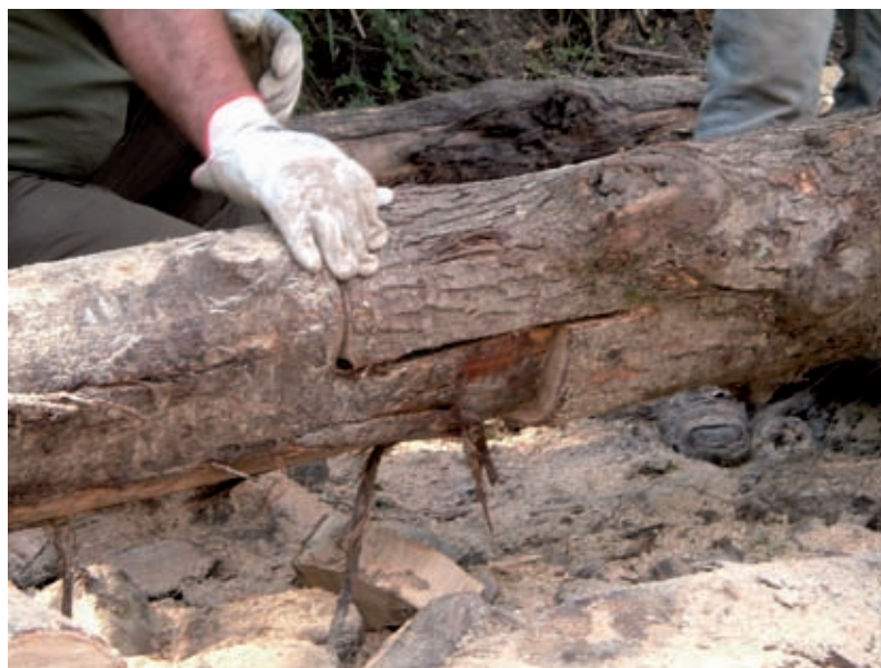
Palificata viva doppia (di versante). Unione di due tronchi longitudinali contigui (correnti) (in opera) (Foto F.Gubernale).
