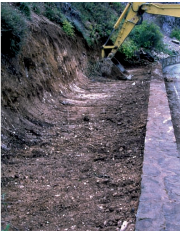
Palificata viva doppia (di versante). Predisposizione della sede di posa (in opera) (Foto R.Ferrari).
