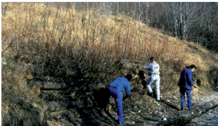
Palificata viva doppia (di versante). Intervento manutentorio di potatura (post operam) (Foto R.Ferrari).
