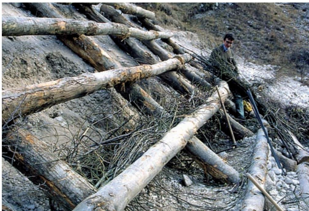
**Fase 10** - Completamento della struttura mediante la posa del materiale vegetale vivo ed il riempimento con materiale inerte di riporto, secondo le modalità e gli accorgimenti precedenti, seguendo un criterio lineare e solo quando si è conclusa l'operazione per una fila orizzontale di "camere" passare alla successiva (Dis. 38, 39, 40).
