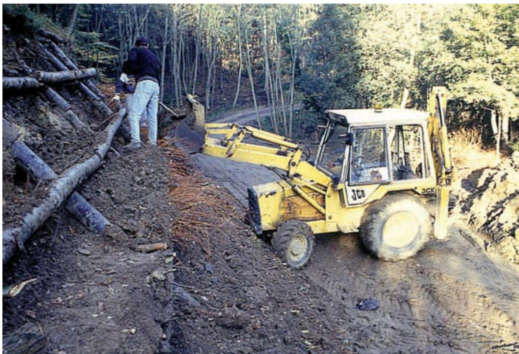
*Grata viva semplice (di versante). Riempimento delle "camere" mediante la posa di materiale vegetale vivo (talee e ramaglia) ed il riempimento con materiale inerte di riporto (in opera) (Foto R.Ferrari).*
