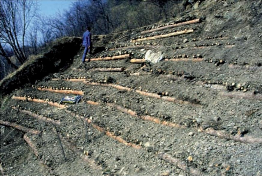
*Grata viva semplice (di versante). Un buon compattamento del materiale inerte di riporto utilizzato per il riempimento è necessario per prevenire l'essiccamento del materiale vegetale vivo (in opera) (Foto R.Ferrari).*
