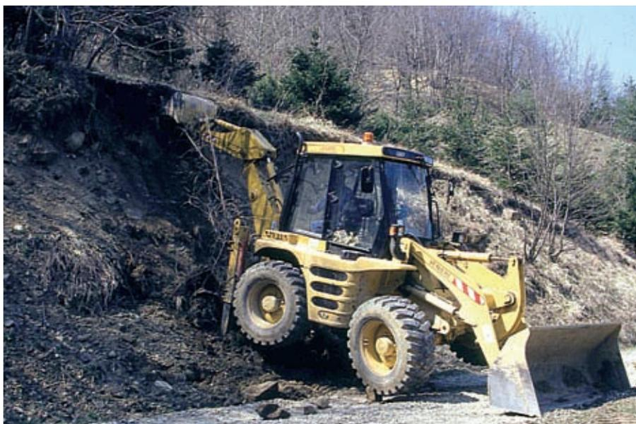
**Fase 2** - Predisposizione della sede di posa degli elementi di fondazione, costituita da una trincea di sufficiente larghezza e profondità pari a circa due diametri dei tronchi in uso, che deve presentare andamento piano. Tale operazione viene effettuata mediante l'utilizzo del mezzo meccanico ed eventualmente completata manualmente (Dis. 2, 3, 4).
