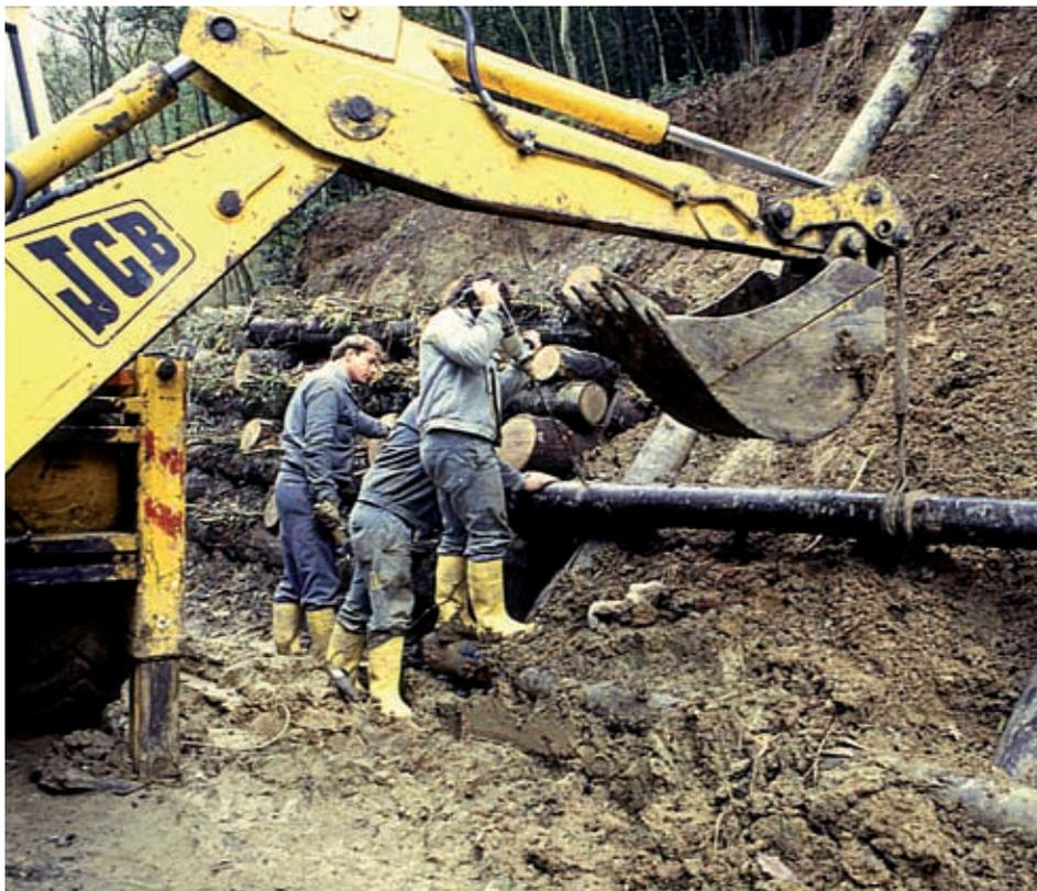
Il fissaggio viene effettuato mediante trapanazione sequenziale di entrambi i tronchi (longitudinale (corrente) ed inclinato (montante)) e successivo inserimento con battitura manuale del "chiodo" costituito da tondino di ferro ad aderenza migliorata, secondo le modalità e gli accorgimenti precedenti. L'utilizzo del mezzo meccanico si limita alla movimentazione degli elementi più pesanti e ad assistenza in genere (Dis. 18, 19, 20).
