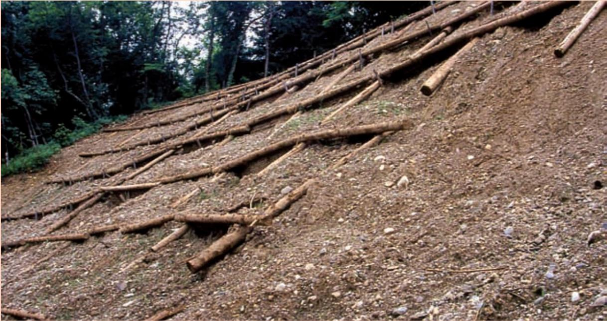
Grata viva semplice (di versante). Effetti dovuti a riempimento con materiale inerte di riporto con caratteristiche geotecniche non rispondenti alla necessità, nonché fondamentale errore di sovrastima nella scelta del materiale vegetale vivo utilizzato (idrosemina) (post operam) (Foto R.Ferrari).
