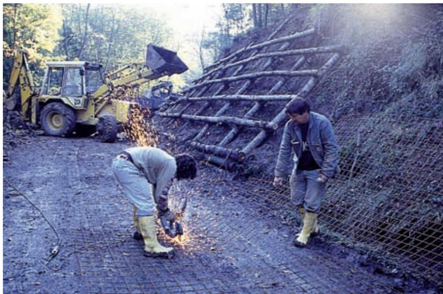
**Grata viva semplice (di versante).** Dimensionamento e taglio di rete elettrosaldata (in opera) (Foto R.Ferrari).
