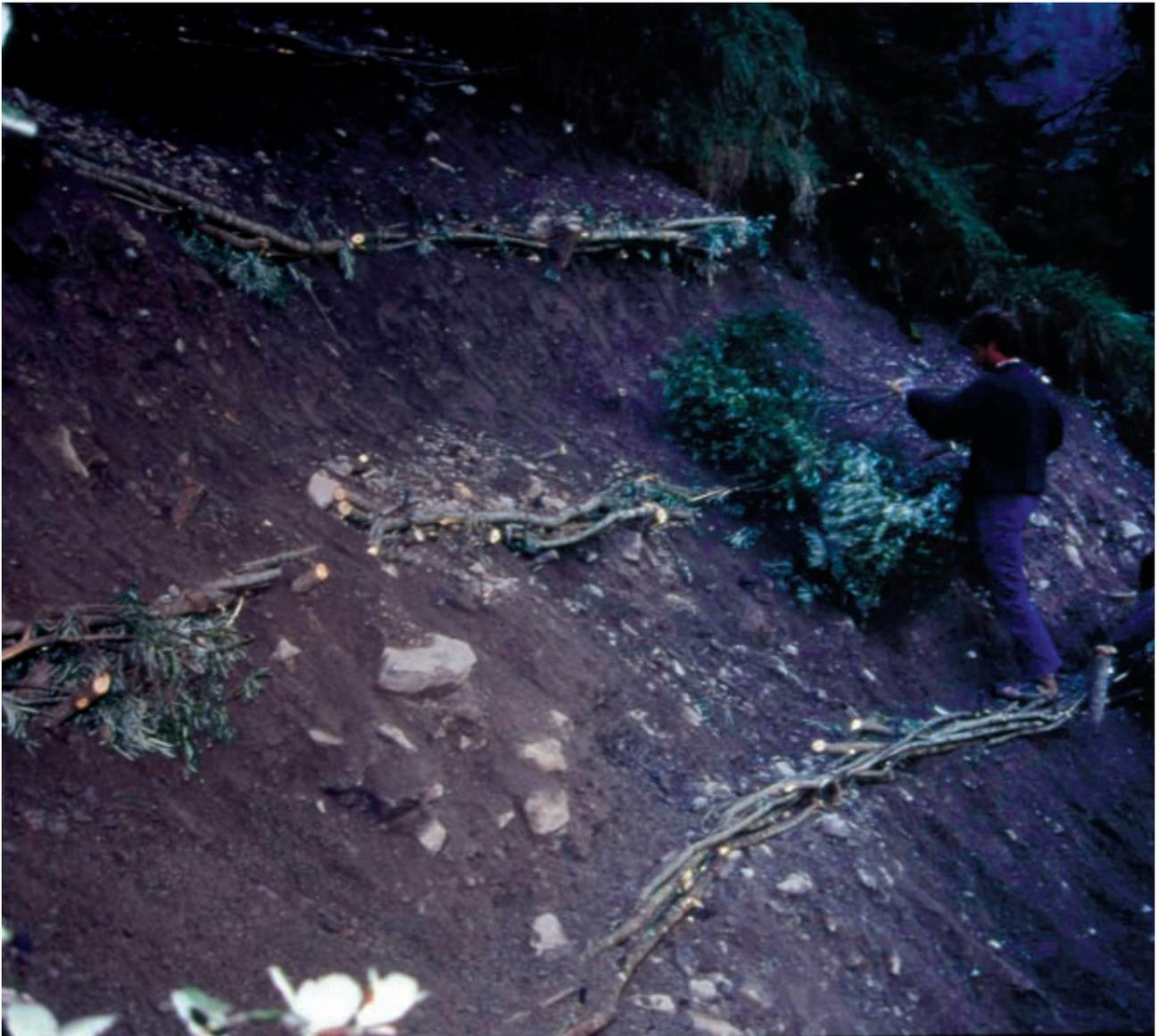
Fascinata viva (di versante). Ricolmo del solco e ricostituzione del pendio (in opera) (Foto R.Ferrari).
