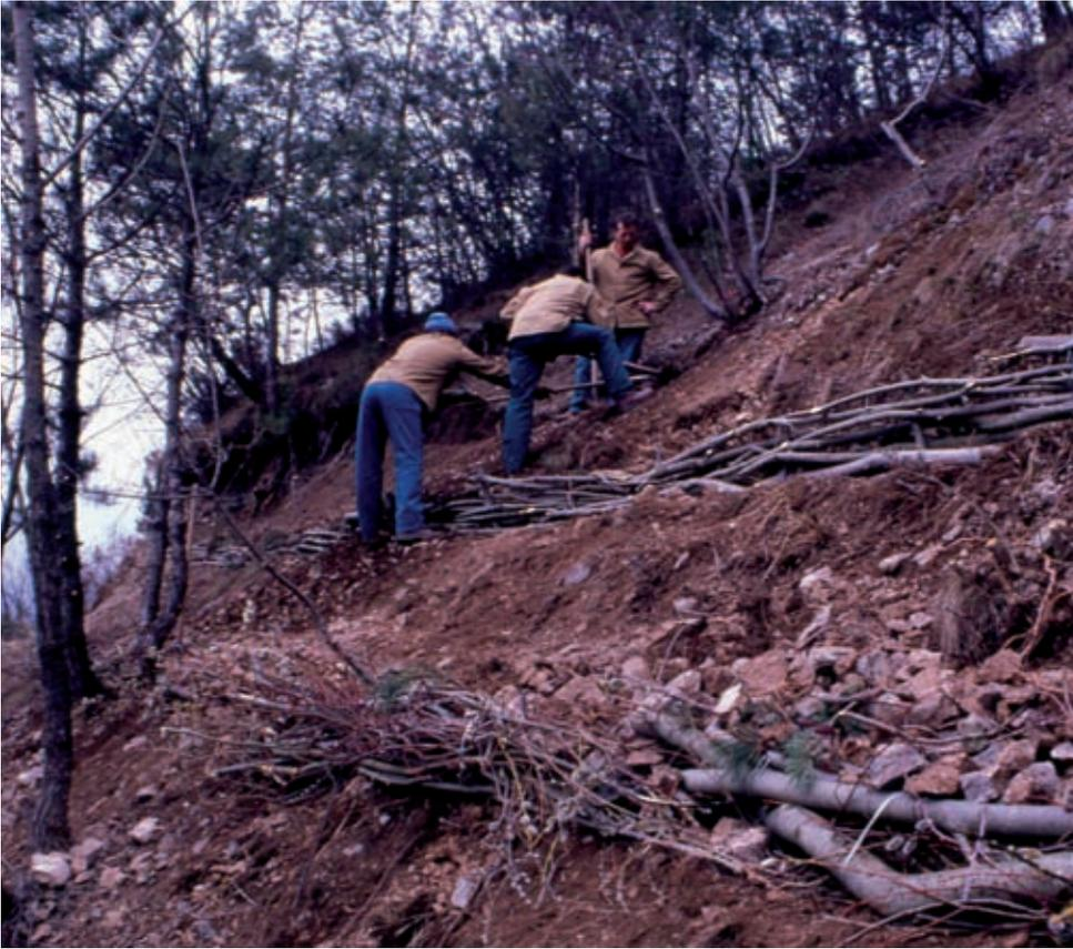
**Fascinata viva (di versante).** L'inserimento di questa tipologia (in primo piano) in un substrato detritico altamente drenante con scarsa frazione fine può compromettere lo sviluppo della componente vegetale viva (in opera) (Foto R.Ferrari).
