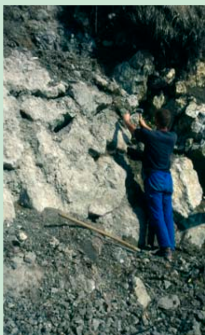
In alto: posa di talee di SALIX DAPHNOIDES sul substrato (Foto R.Ferrari).
