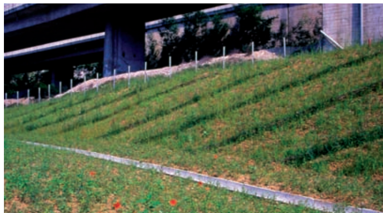
Viminata viva (di versante). Realizzazione di allineamenti paralleli a disposizione suborizzontale (post operam) (Foto R.Ferrari).
