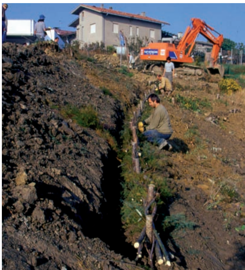
Viminata viva (di versante). Intreccio alternato di materiale vegetale vivo in livelli costipati mediante pressione (in opera) (Foto R.Ferrari).
