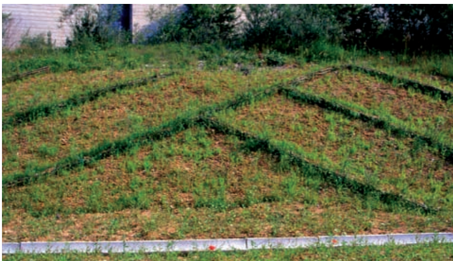
Viminata viva (di versante). Realizzazione di allineamenti paralleli a disposizione inclinata (post operam) (Foto R.Ferrari).
