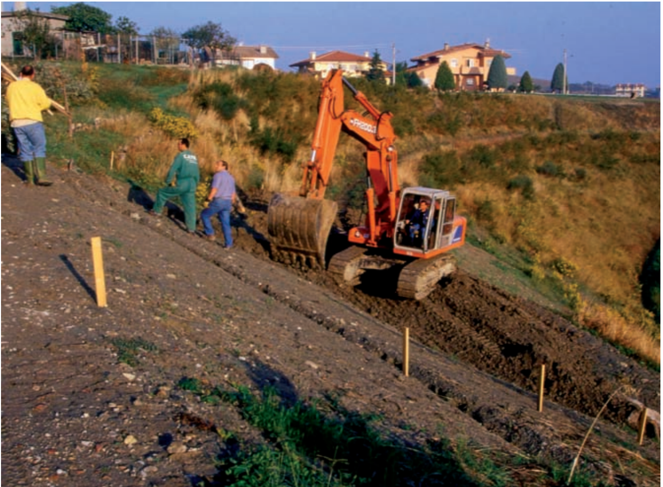
Viminata viva (di versante). Predisposizione della sede di posa (in opera) (Foto R.Ferrari).
