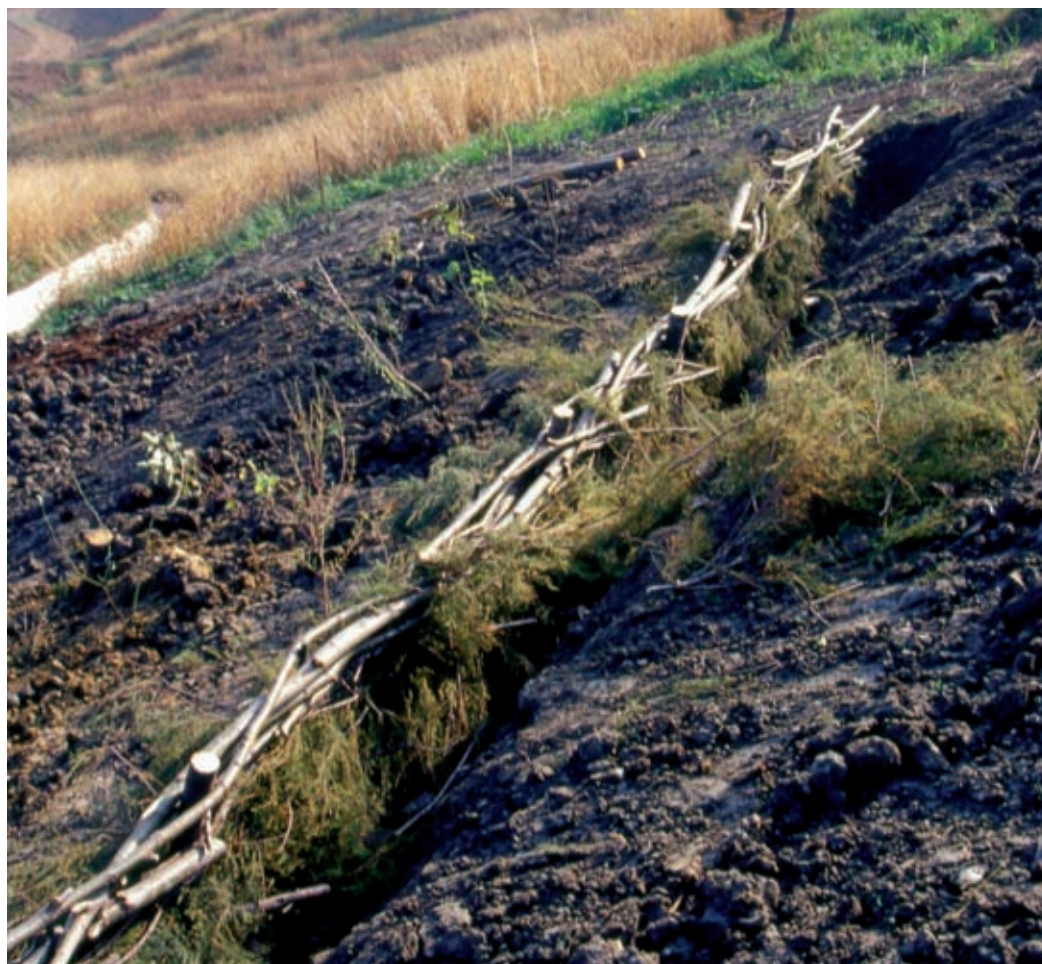
Viminata viva (di versante). Intreccio alternato di materiale vegetale vivo (astoni di SALIX PURPUREA ) (in opera) (Foto R.Ferrari).
