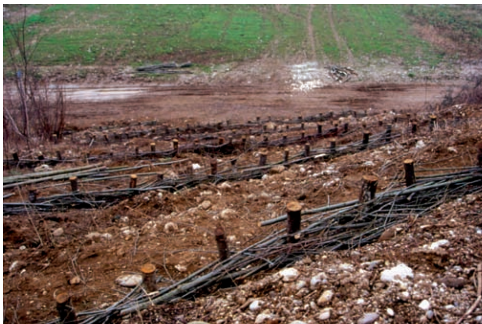
Viminata viva (di versante). Utilizzo di picchetti in castagno (in opera) (Foto R.Ferrari).
