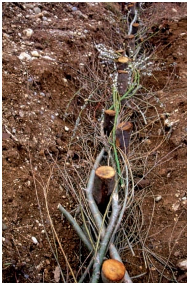
Viminata viva (di versante). Intreccio alternato di mate- riale vegetale vivo (astoni di SALIX SP.) (in opera) (Foto R.Ferrari).
