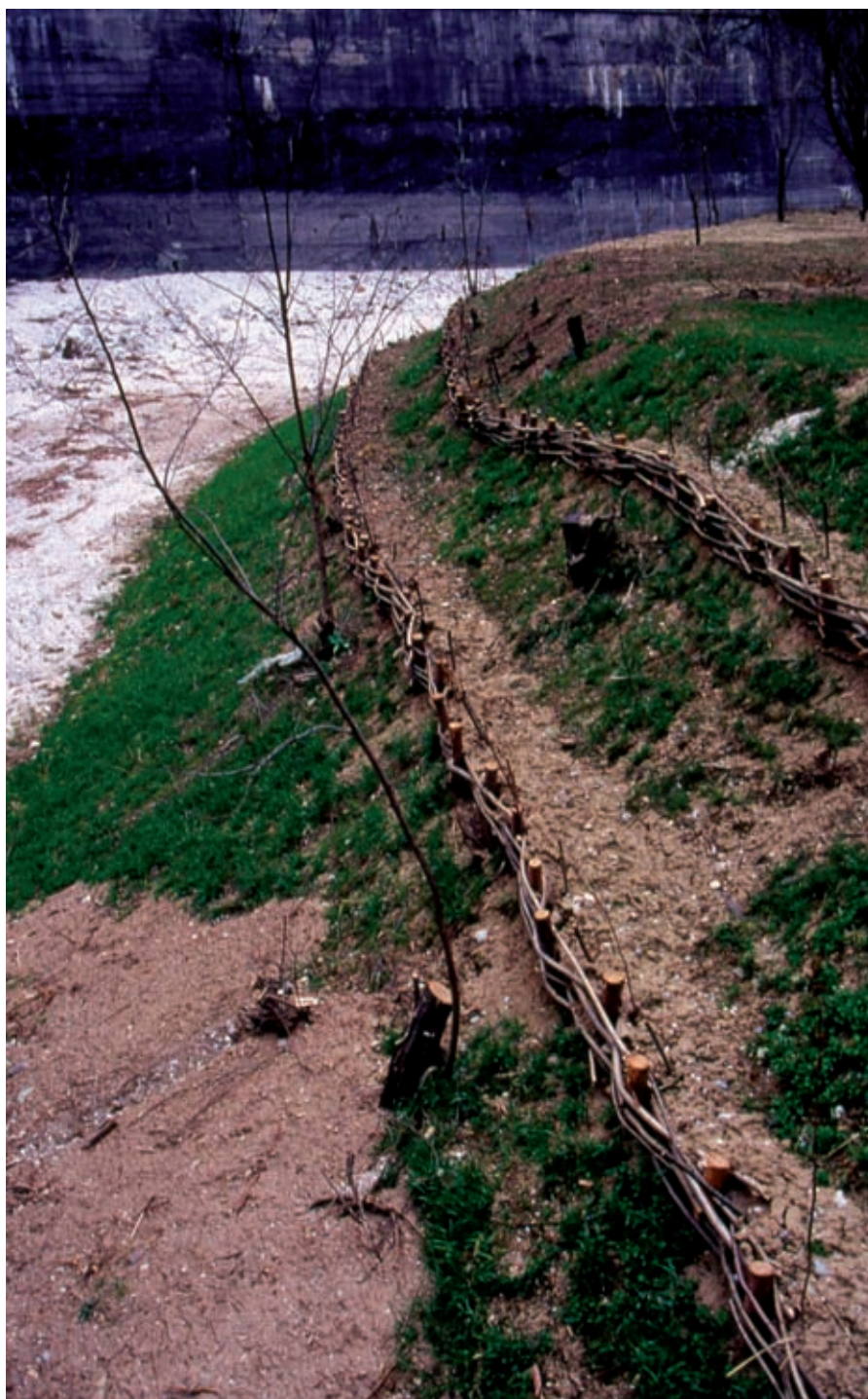
Viminata viva (di versante). Come si presenta la tipologia appena terminata la fase realiz- zativa di cantiere (post operam) (Foto R.Ferrari)
