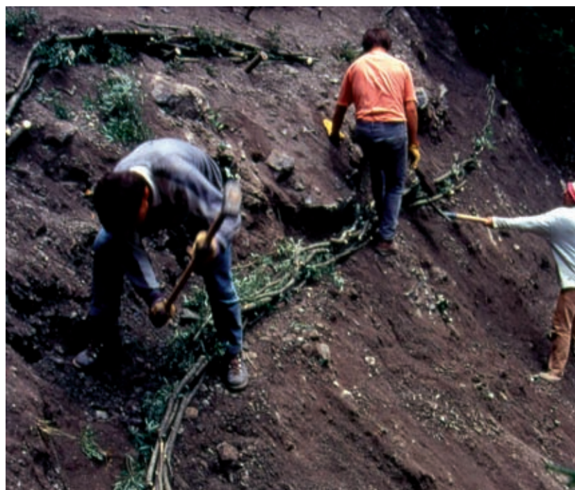
Viminata viva (di versante). Ricolmo del solco e ricostituzione del pendio (in opera) (Foto R.Ferrari).
