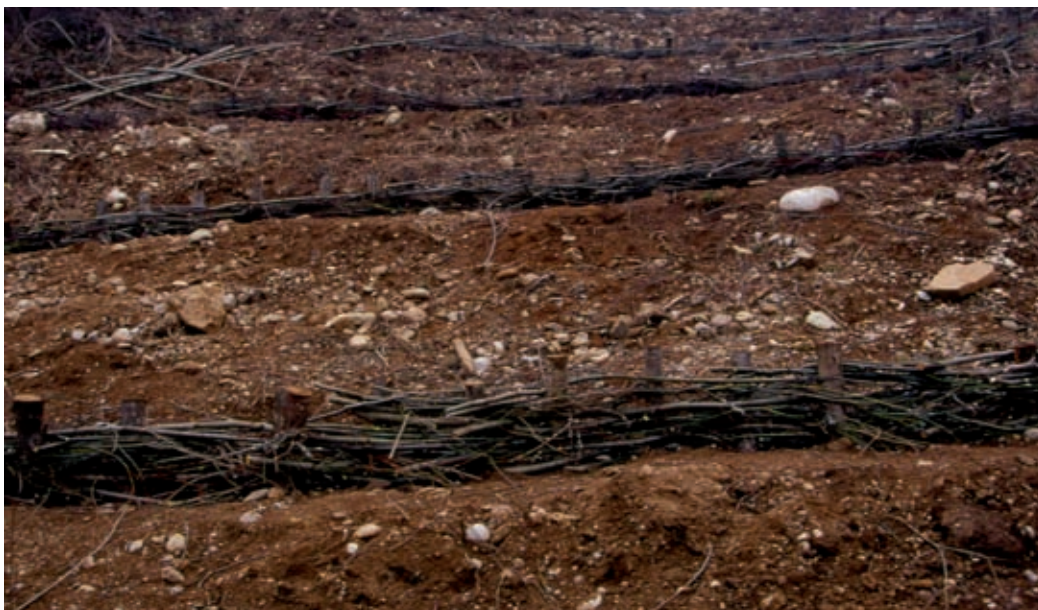
Viminata viva (di versante). Intreccio alternato di materiale vegetale vivo in livelli a disposizione alternata del verso di crescita dei singoli elementi di materiale vegetale vivo (in opera) (Foto R.Ferrari).
