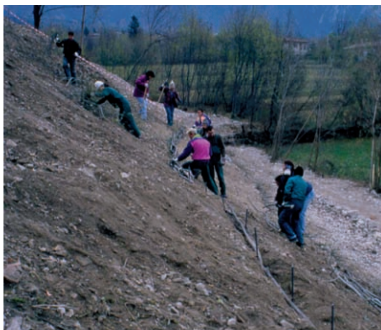
Viminata viva (di versante). Utilizzo di picchetti in castagno (in opera) (Foto R.Ferrari).
