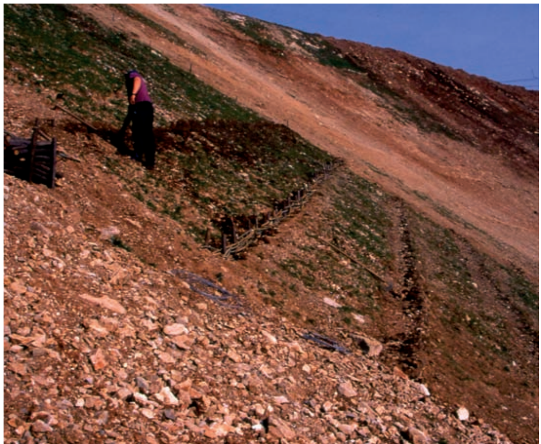
Viminata viva (di versante). Predisposizione della sede di posa (in opera) (Foto R.Ferrari).
