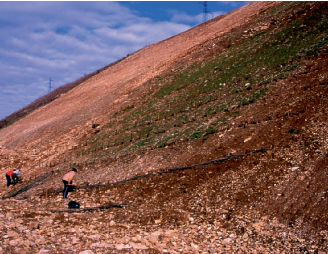
Viminata viva (di versante). Predisposizione della sede di posa iniziando dal basso (in opera) (Foto R.Ferrari).
