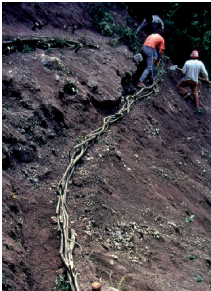
Viminata viva (di versante). Intreccio alternato di materiale vegetale vivo (astoni di SALIX PURPUREA ) (in opera) (Foto R.Ferrari).
