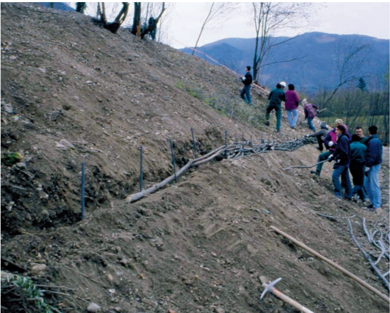
Viminata viva (di versante). Intreccio alternato di materiale vegetale vivo in livelli continui ed interconnessi (in opera) (Foto R.Ferrari).
