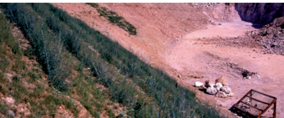
Viminata viva (di versante). Evoluzione all'inizio della prima stagione vegetativa (post operam) (Foto R.Ferrari).
