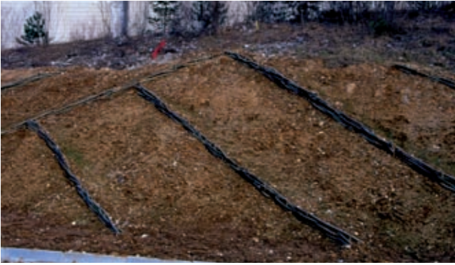
A sinistra: Viminata viva (di versante). Realizzazione di successivi allineamenti (post operam) (Foto R.Ferrari). A destra: Viminata viva (di versante). Sistemazione finale dell'area di cantiere (post operam) (Foto R.Ferrari).
