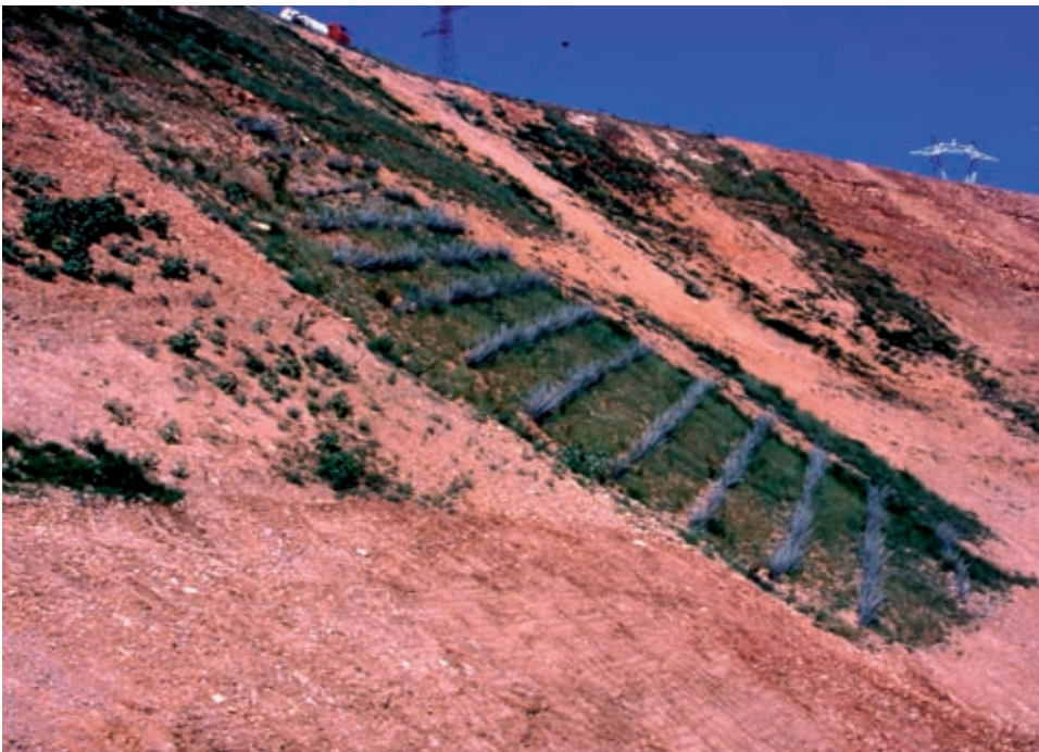
Viminata viva (di versante). Irrigazione di soccorso mediante l'utilizzo di autobotte (post operam) (Foto R.Ferrari).
