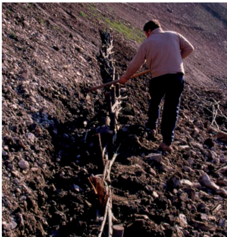
Viminata viva (di versante). Ricolmo del solco e ricostituzione del pendio (in opera) (Foto R.Ferrari).
