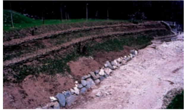
A sinistra: Viminata viva (di versante). Realizzazione di successivi allineamenti (post operam) (Foto R.Ferrari). A destra: Viminata viva (di versante). Sistemazione finale dell'area di cantiere (post operam) (Foto R.Ferrari).
