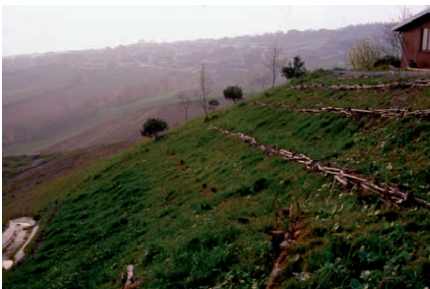
Viminata viva (di versante). Realizzazione di allineamenti paralleli a disposizione suborizzontale (post operam) (Foto R.Ferrari).
