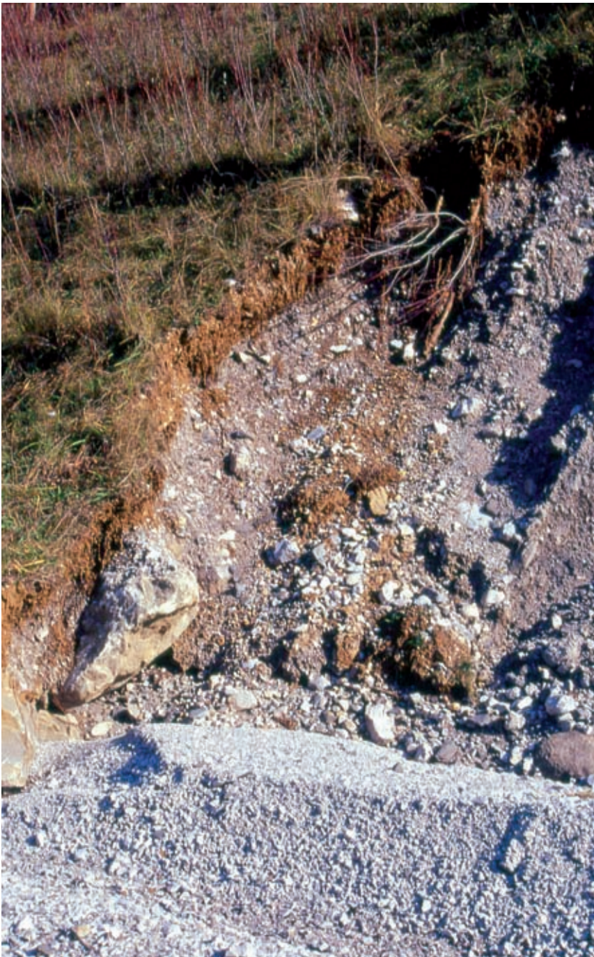
Gradonata viva. Parziale dislocazione a seguito di evento meteorico eccezionale (post operam) (Foto R.Ferrari).
