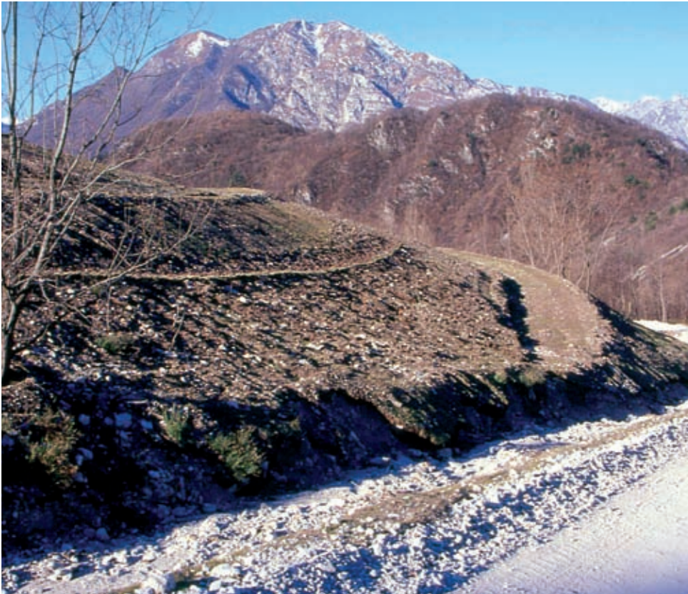
Gradonata viva. Come si presenta la tipologia appena terminata la fase realizzativa di cantiere (post operam) (Foto R.Ferrari)
