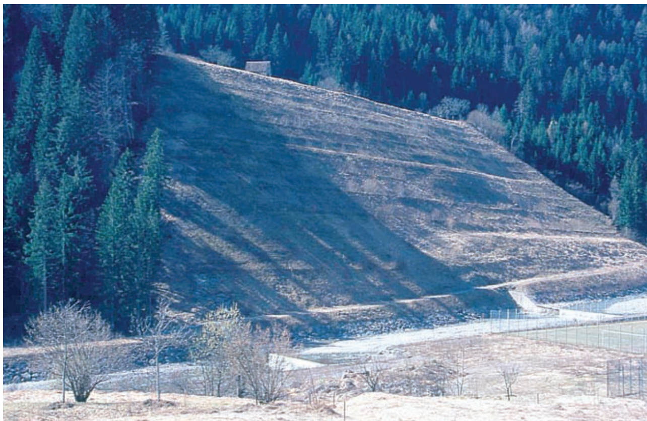
Gradonata viva. Realizzazione di successivi allineamenti paralleli (post operam) (Foto R.Ferrari).
