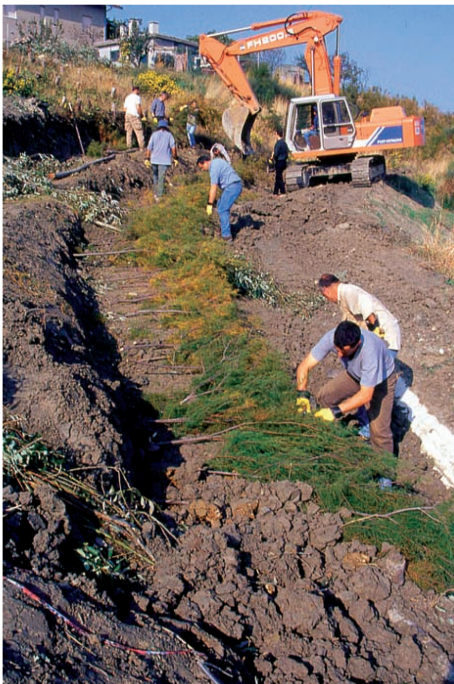
Gradonata viva. Posa di materiale vegetale vivo (talee di TAMARIX GALLICA) (in opera) (Foto R.Ferrari).
