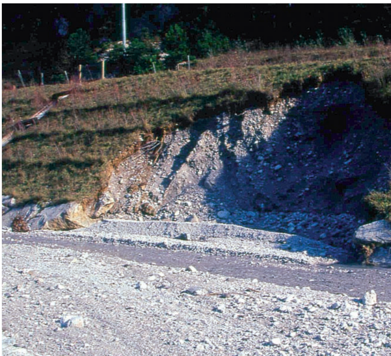
Gradonata viva. Parziale dislocazione a seguito di evento meteorico eccezionale (post operam) (Foto R.Ferrari).
