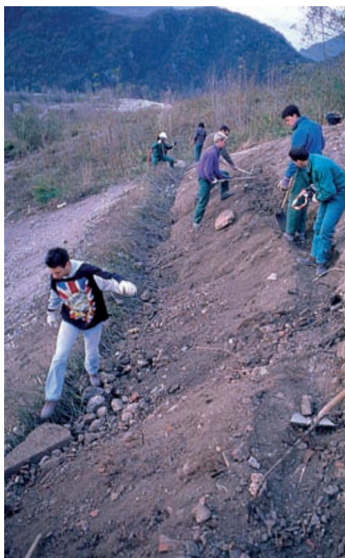
Gradonata viva. Predisposizione della sede di posa (in opera) (Foto R.Ferrari).
