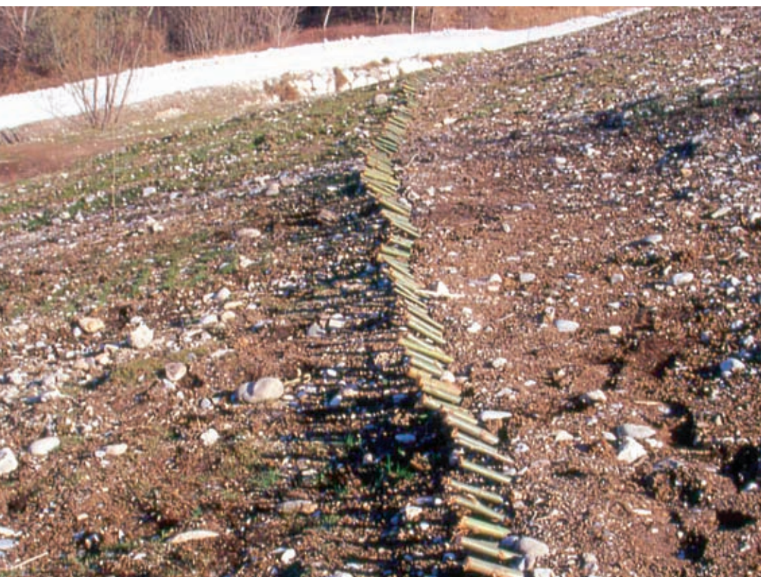
Gradonata viva. Ricolmo dello scavo con ripristino morfologico del substrato (in opera) (Foto R.Ferrari).
