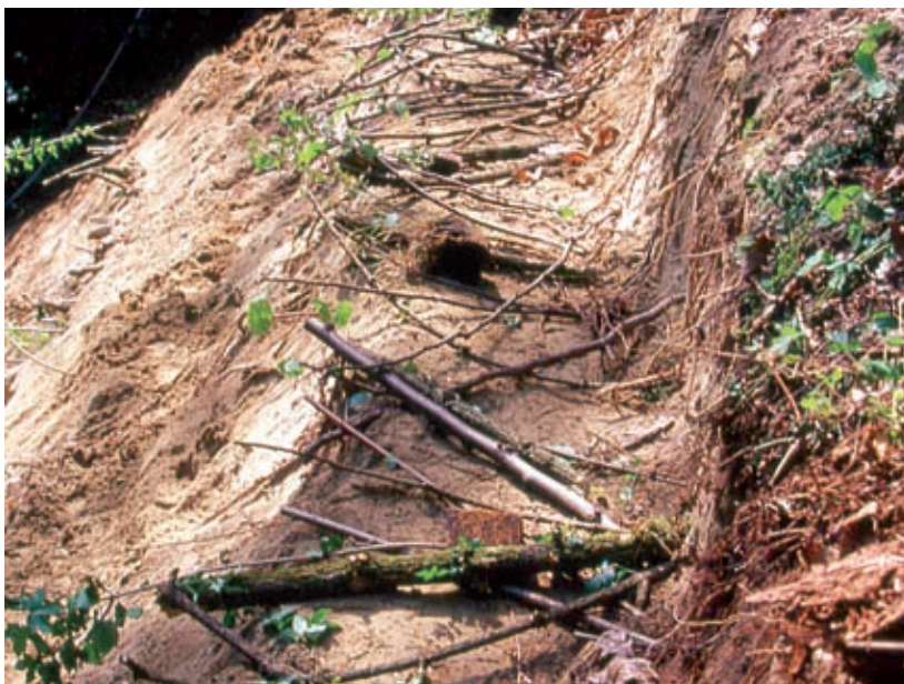
Gradonata viva. Posa di materiale vegetale vivo (talee di SAMBUCUS NIGRA (sambuco)) a disposizione incrociata dei singoli elementi (in opera) (Foto R.Ferrari).
