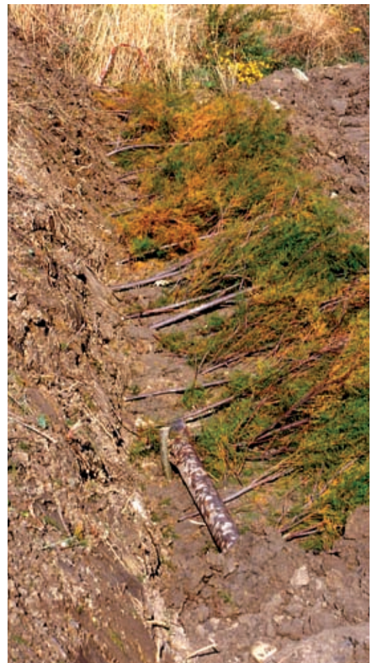
Gradonata viva. Posa di materiale vegetale vivo (talee di TAMARIX GALLICA (tamerice)) a disposizione parallela dei singoli elementi (in opera) (Foto R.Ferrari).
