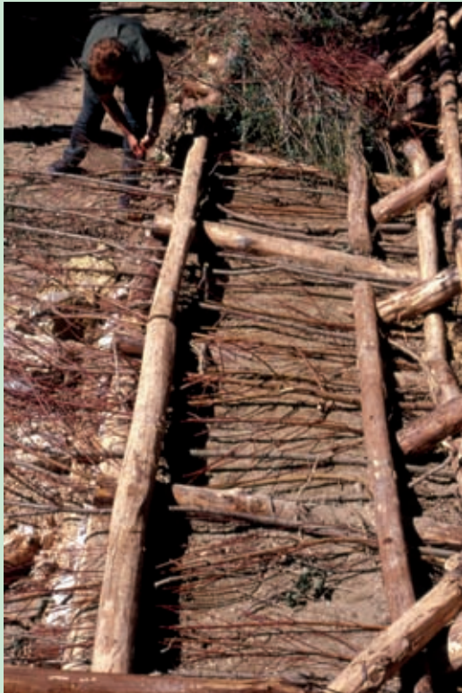
Astoni di SALIX PURPUREA inseriti nella costruenda struttura, prima del loro definitivo dimensionamento che fornirà altro materiale vegetale vivo idoneo (Foto R.Ferrari).
