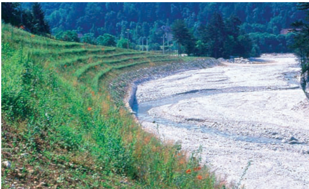
Gradonata viva. Evoluzione all'inizio della prima stagione vegetativa (post operam) (Foto R.Ferrari).
