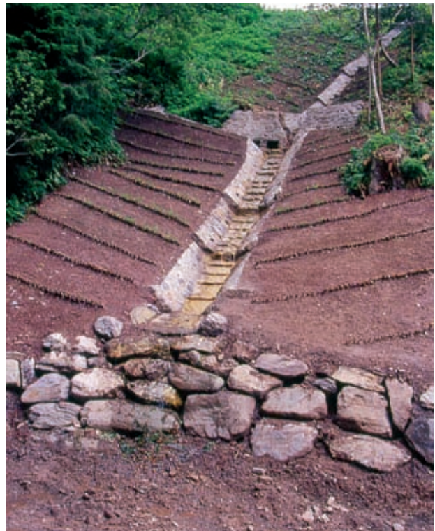
Gradonata viva. Realizzazione di allineamenti paralleli a disposizione inclinata a completamento di un intervento di drenaggio e convogliamento di acque superficiali (post operam) (Foto R.Ferrari)
