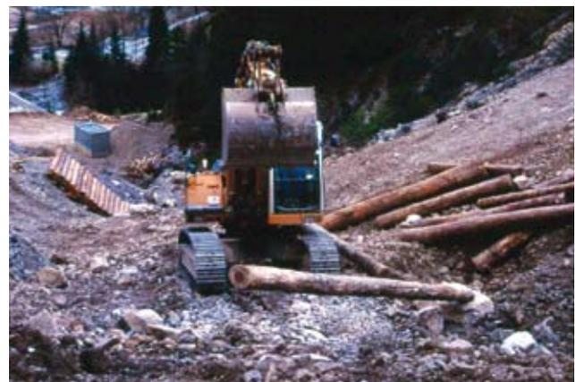
A sinistra: Attrezzature, Attrezzature per scavo. Macchine movimento terra, Scavatori meccanici. Scavatore meccanico cingolato adibito a posizionamento di tondame di grosso diametro in Palizzata viva su sponda di canale (Foto R.Ferrari).
