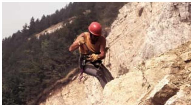
Attrezzature, Attrezzature per movimentazione. Leve. Operazioni di disgaggio in parete mediante leva (Foto R.Ferrari).
