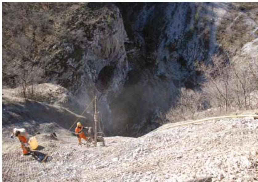
A sinistra: Attrezzature, Attrezzature per perforazione. Perforatrici ad aria. Perforatrice ad aria manuale (Foto R.Ferrari).
