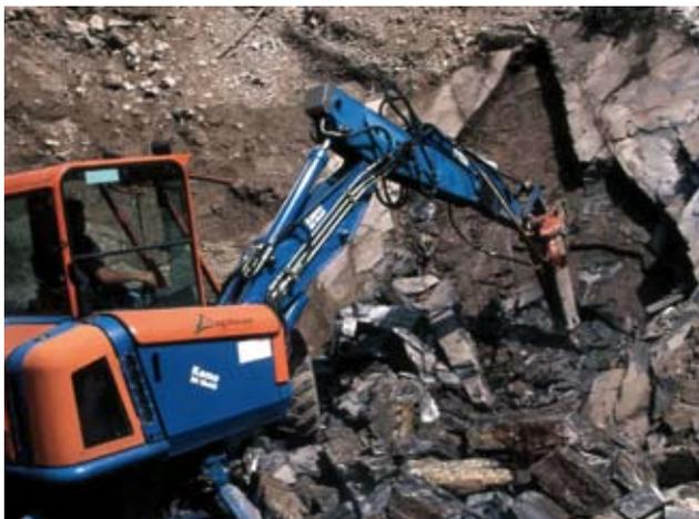
In alto: Attrezzature, Attrezzature per infissione. Martelloni demolitori. Martellone demolitore applicato a Ragno meccanico adibito a scavo della sede di posa di Briglia viva in legname e pietrame (Foto R.Ferrari).
