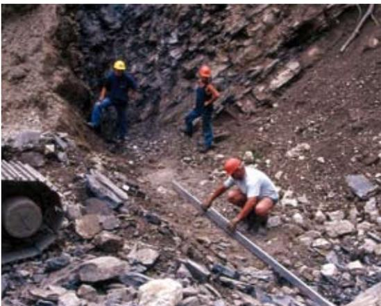
*Attrezzature, Attrezzature per il rilevamento speditivo in campagna, controllo in cantiere, monitoraggio. Livelle. L'utilizzo complementare alle livelle a bolla consente la precisione necessaria in alcune fasi costruttive (Foto R.Ferrari).*
