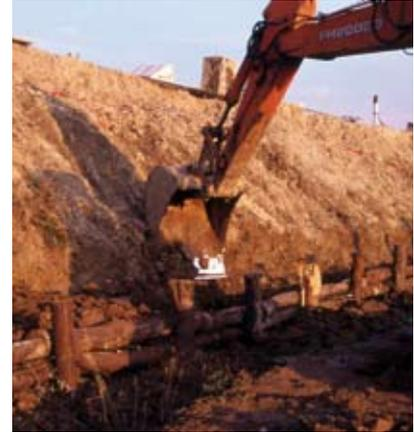
A sinistra: Attrezzature, Attrezzature per scavo. Macchine movimento terra, Scavatori meccanici. Scavatore meccanico cingolato adibito ad infissione a pressione di tondame di grosso diametro su sponda di canale (Foto R.Ferrari).
