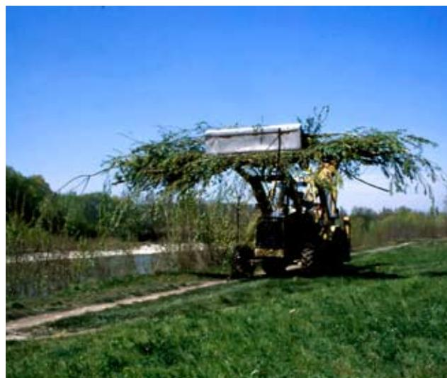
A sinistra: Attrezzature, Attrezzature per scavo. Macchine movimento terra, Terne. Terna adibita a preparazione della sede di posa di Grata viva semplice di versante (Foto R.Ferrari).
