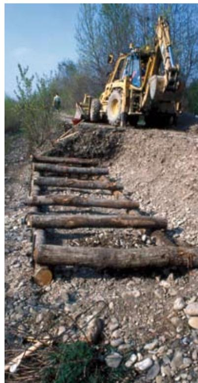
A sinistra: Attrezzature, Attrezzature per scavo. Macchine movimento terra, Terne. Terna adibita a scavo della sede di posa di Palificata viva doppia (Foto R.Ferrari).
