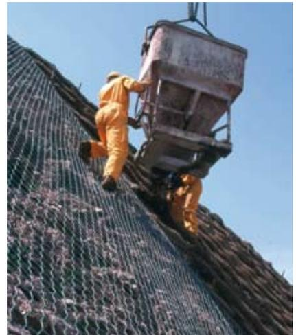
A sinistra: Attrezzature, Attrezzature per trasporto. Secchi. Secchio a svuotamento manuale dal fondo con attacco per sollevamento meccanico (Foto R.Ferrari).
