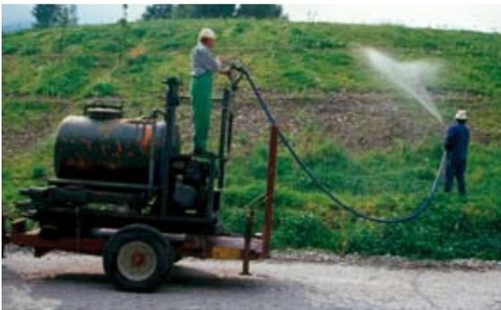
Attrezzature, Attrezzature particolari. Idroseminatrici. Idroseminatrice montata su carro rimorchio (Foto R.Ferrari).
