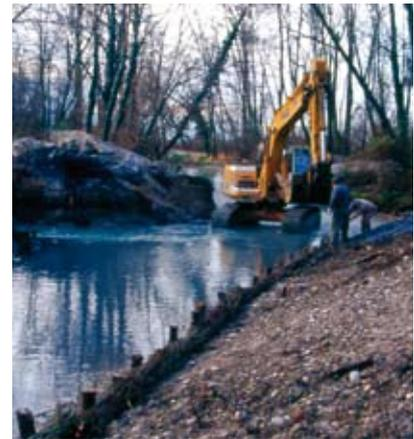
A sinistra: Attrezzature, Attrezzature per scavo. Macchine movimento terra, Scavatori meccanici. Scavatore meccanico cingolato adibito a rimodellamento di alveo fluviale (Foto R.Ferrari).
