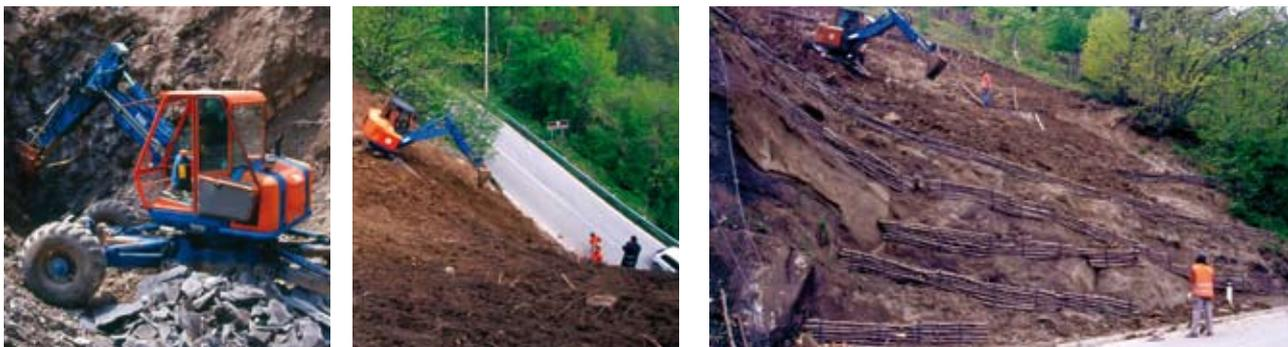
A sinistra: Attrezzature, Attrezzature per scavo. Macchine movimento terra, Ragni meccanici. Ragno meccanico dotato di martellone demolitore adibito a scavo della sede di posa di Briglia viva in legname e pietrame (Foto R.Ferrari).
