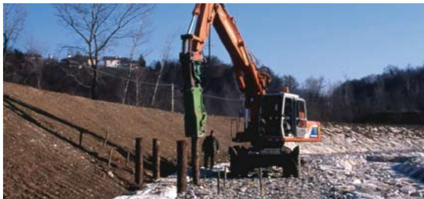
A sinistra: Attrezzature, Attrezzature per infissione. Battipali. Testa battipalo applicata a scavatore meccanico (Foto R.Ferrari).
