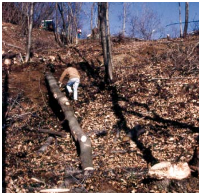
Materiali. Tondame di grande diametro ( \varnothing > 15 cm); approvvigionamento da taglio ad hoc di tronchi di castagno (Foto R.Ferrari).
