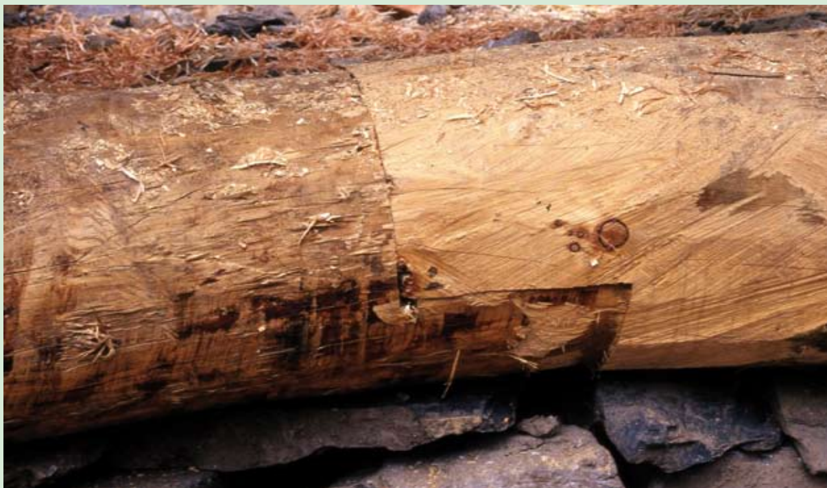
Unione di due tronchi contigui mediante incastro a sormonto e chiodatura (Foto R.Ferrari).
