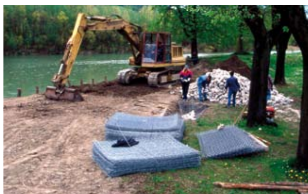
A sinistra: Materiali. Elementi litoidi a consolidamento spondale (Foto R.Ferrari).
