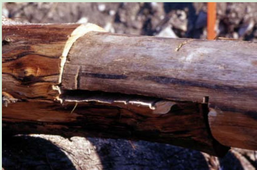
Combaciamento degli elementi (Foto R.Ferrari).
