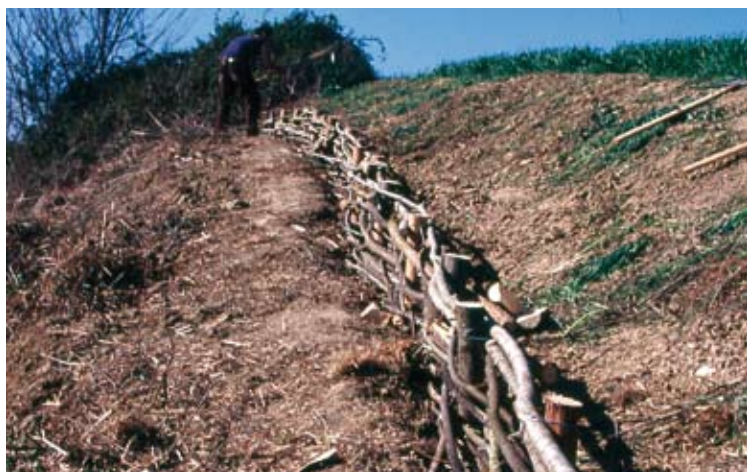
Materiali. Tondame di piccolo diametro ( \emptyset 8÷15 cm); utilizzo in Viminata viva di versante (Foto R.Ferrari).
