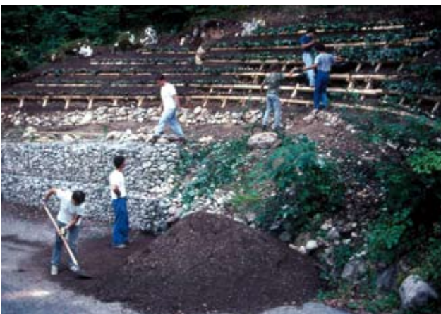
A sinistra: Materiali. Terreni vegetali; la posa richiede attenzioni particolari a seconda della tipologia: Grata viva semplice di versante (Foto R.Ferrari).
