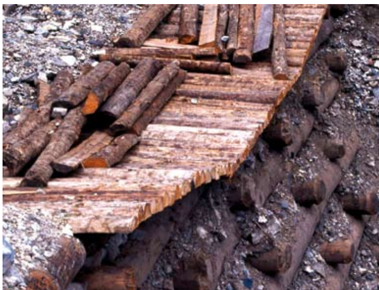
Materiali. Tondame di piccolo diametro ( \emptyset 8÷15 cm); utilizzo di mezzi tronchi per la realizzazione di gaveta in Briglia viva in legname e pietrame (Foto R.Ferrari).
