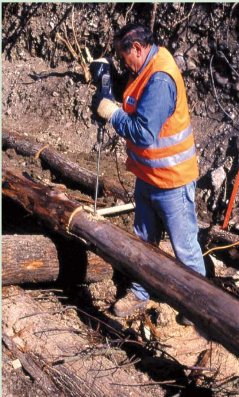
Esecuzione del foro (Foto R.Ferrari).
