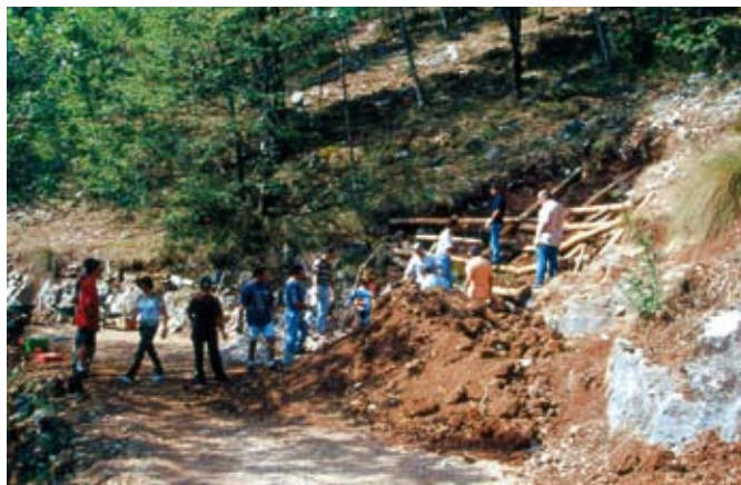
Materiali. Terreni vegetali (Foto R.Ferrari).
