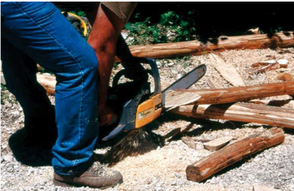
Materiali. Tondame di piccolo diametro ( \varnothing 8÷15 cm); predisposizione di punta ad una estremità di tronchi di castagno (Foto R.Ferrari).
