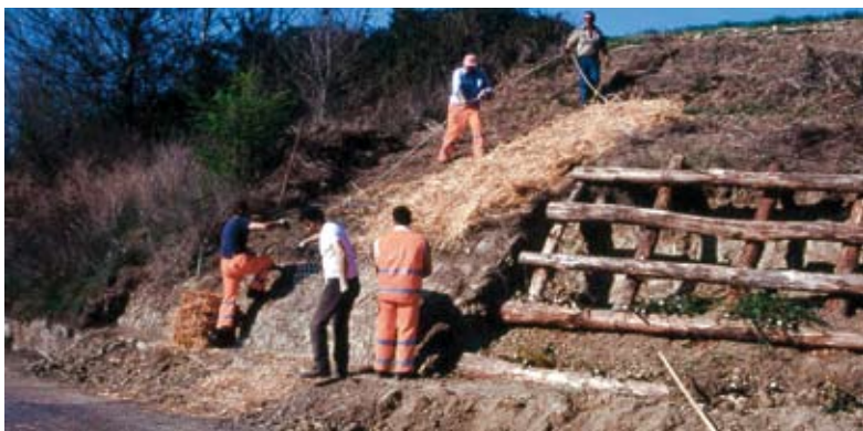
Materiali. Fibre vegetali; fibre di paglia sciolte a copertura protettiva del substrato (Foto R.Ferrari).
