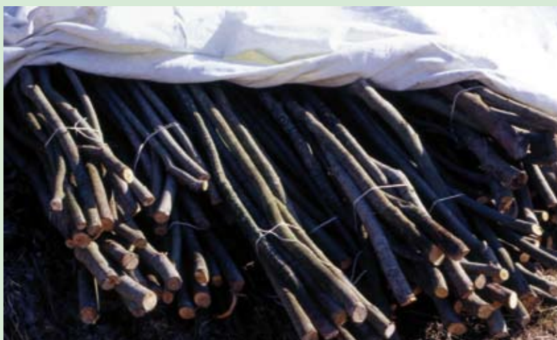
Stoccaggio in cantiere di materiale vegetale vivo (astoni) in ombra e con la parte basale immersa in acqua (Foto R.Ferrari).
