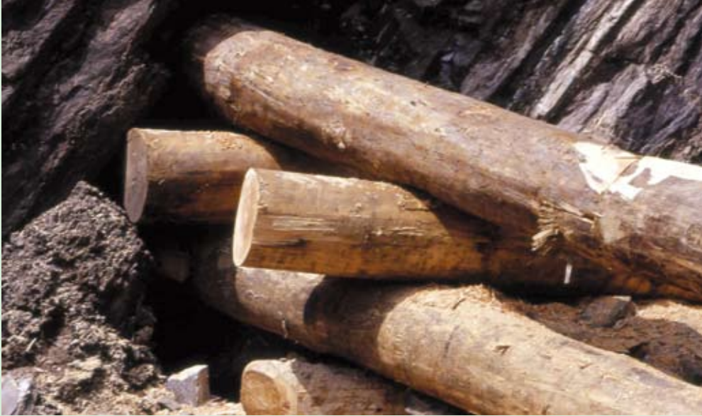
Unione di tronchi sovrapposti mediante chiodatura (Foto R.Ferrari).
