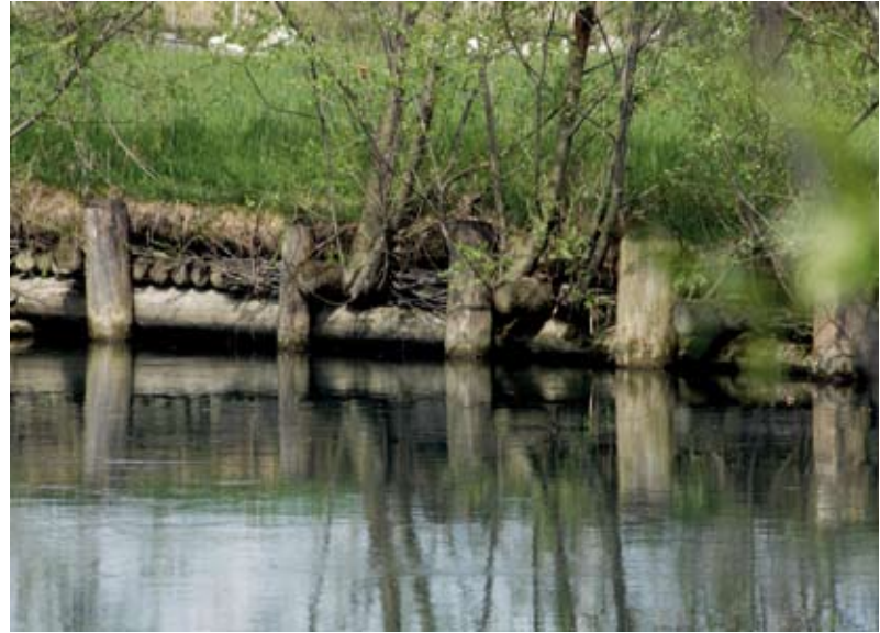
In alto: Palificata viva spondale con palo verticale frontale. Evoluzione dopo alcune stagioni vegetative (post operam) (Foto R.Ferrari). A sinistra: Palificata viva spondale con palo verticale frontale. Evoluzione dopo alcune stagioni vegetative (post operam) (Foto R.Ferrari).
