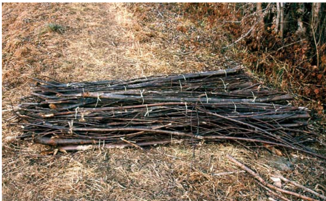
Palificata viva spondale con palo verticale frontale. Fascine di materiale vegetale morto (in opera) (Foto R.Ferrari).
