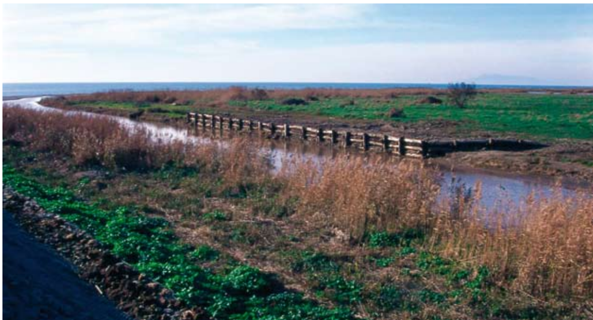
Palificata viva spondale con palo verticale frontale. Completamento del riempimento con materiale inerte di riporto (in opera) (Foto R.Ferrari).
