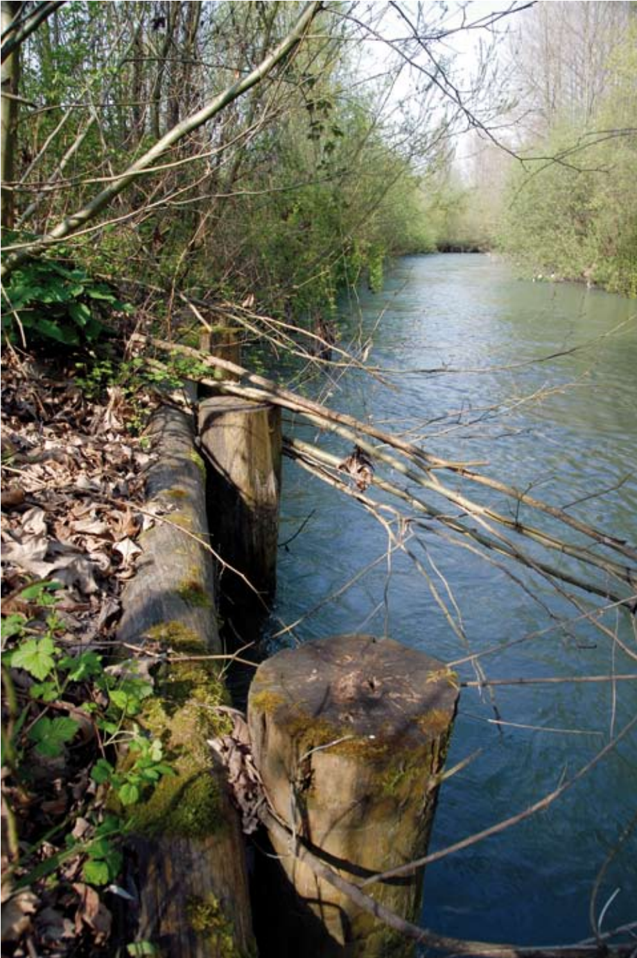
Palizzata viva spondale con palo verticale frontale. E' importante mantenere la sponda libera da ostacoli che potrebbero influenzare il naturale flusso idrico (post operam) (Foto R.Ferrari).
