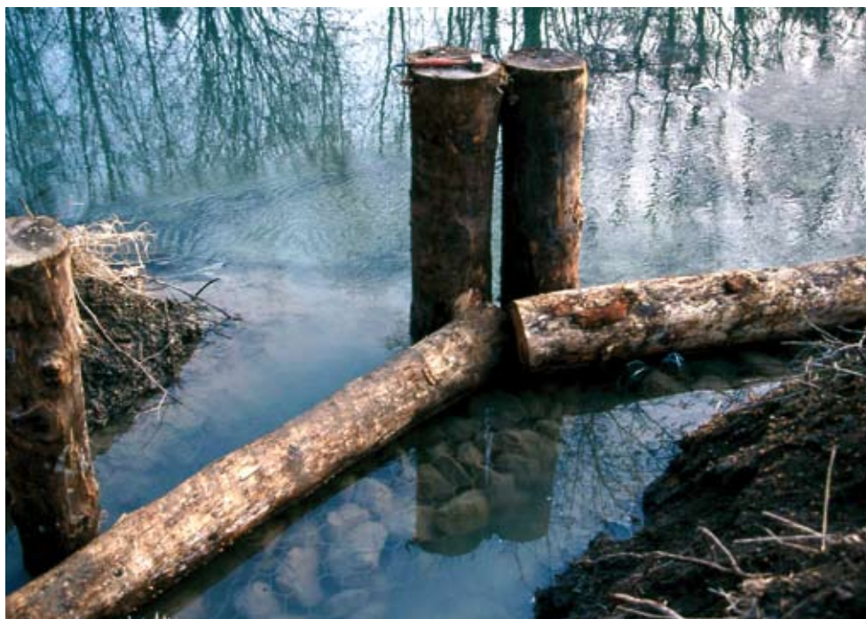
Palificata viva spondale con palo verticale frontale. Raccordo tra struttura e superficie morfologica-substrato (in opera) (Foto R.Ferrari).
