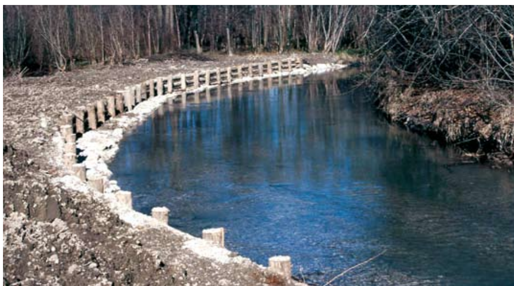
Palificata viva spondale con palo verticale frontale. Come si presenta la tipologia appena terminata la fase realizzativa di cantiere (post operam) (Foto R.Ferrari).
