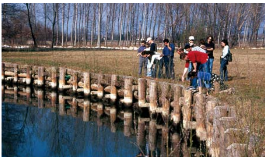
Palificata viva spondale con palo verticale frontale. Evoluzione all'inizio della prima stagione vegetativa (post operam) (Foto R.Ferrari).
