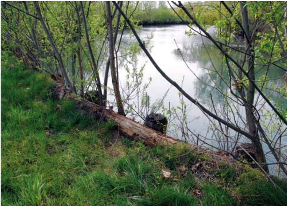
In alto: Palificata viva spondale con palo verticale frontale. Evoluzione dopo alcune stagioni vegetative (post operam) (Foto R.Ferrari). A sinistra: Palificata viva spondale con palo verticale frontale. Evoluzione dopo alcune stagioni vegetative (post operam) (Foto R.Ferrari).
