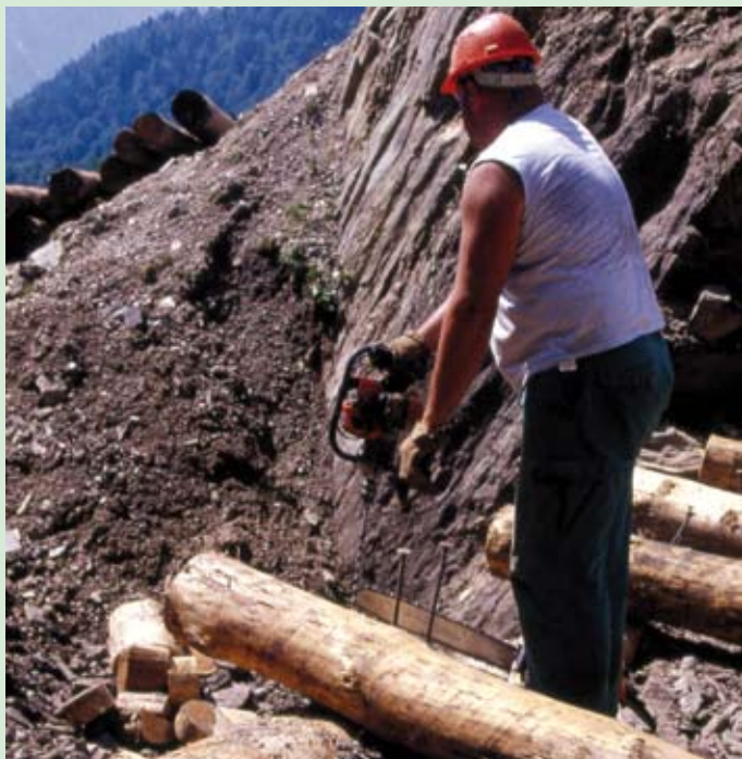
Esecuzione del foro (Foto R.Ferrari).
