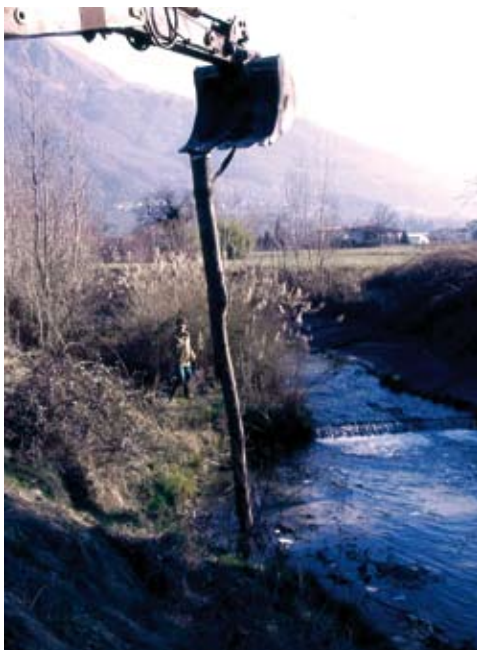
Palificata viva spondale con palo verticale frontale. Infissione verticale di tronchi mediante l'utilizzo a spinta della benna del mezzo meccanico (in opera) (Foto R.Ferrari).
