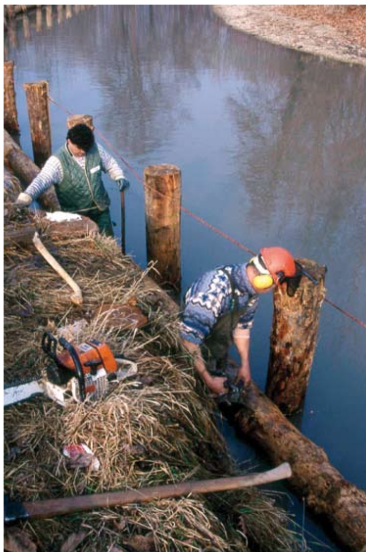
Palificata viva spondale con palo verticale frontale. Posa del primo ordine di tronchi longitudinali (correnti) (in opera) (Foto R. Ferrari).
