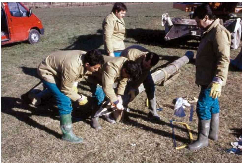
Palificata viva spondale con palo verticale frontale. Applicazione di puntale di rinforzo in ferro (in opera) (Foto R.Ferrari).
