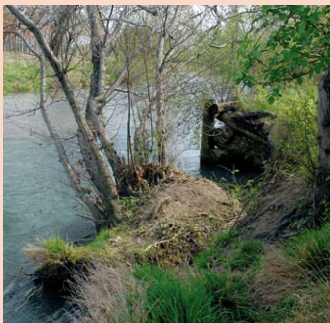
Palificata viva spondale con palo verticale frontale. Mancanza di raccordo tra struttura e superficie morfologica-substrato. (post operam) (Foto R.Ferrari).
