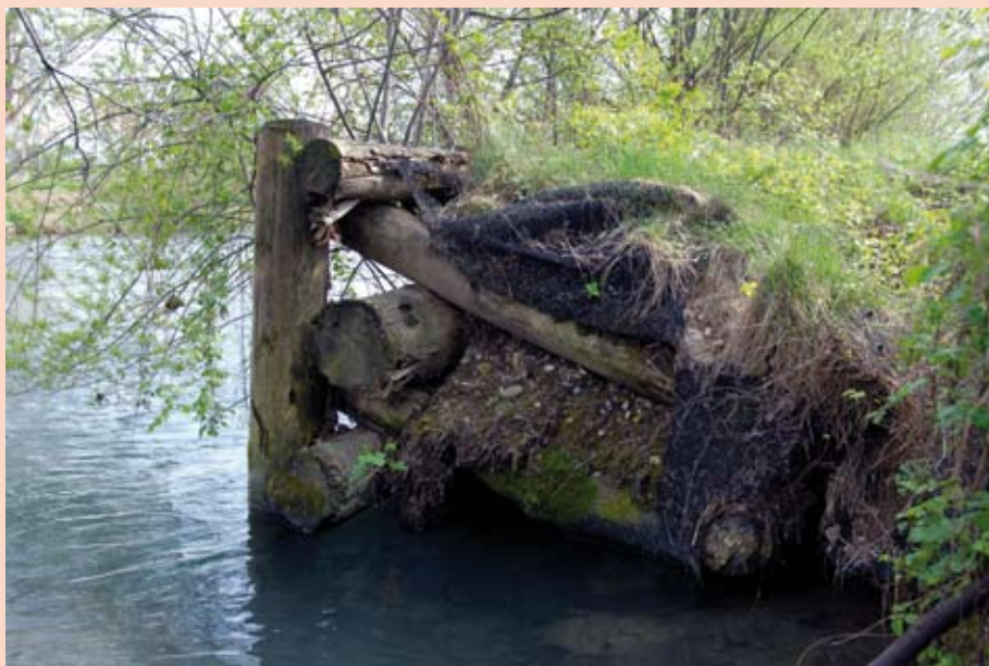
Palificata viva spondale con palo verticale frontale. Mancanza di raccordo tra struttura e superficie morfologica-substrato. (post operam) (Foto R.Ferrari).
