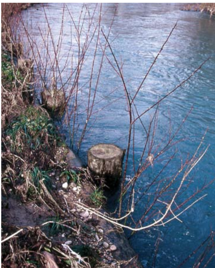
Palificata viva spondale con palo verticale frontale. Evoluzione all'inizio della prima stagione vegetativa (post operam) (Foto R.Ferrari).
