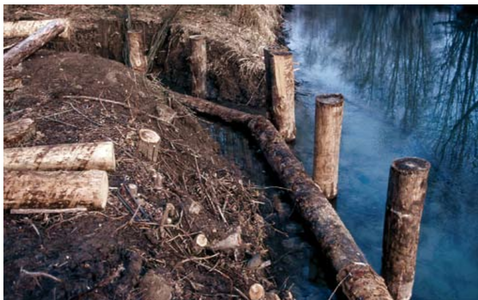
Palificata viva spondale con palo verticale frontale. Raccordo tra struttura e superficie morfologica-substrato (in opera) (Foto R.Ferrari).
