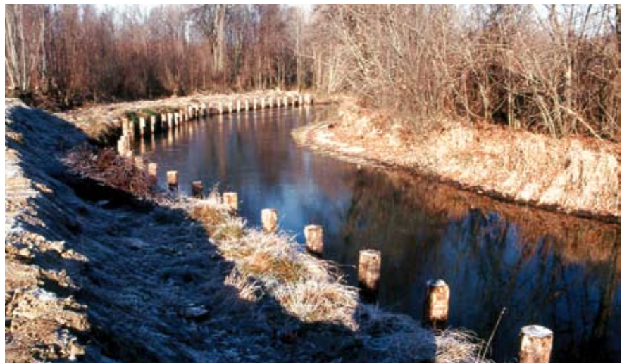
Palificata viva spondale con palo verticale frontale. Raccordo laterale (in opera) (Foto R.Ferrari).
