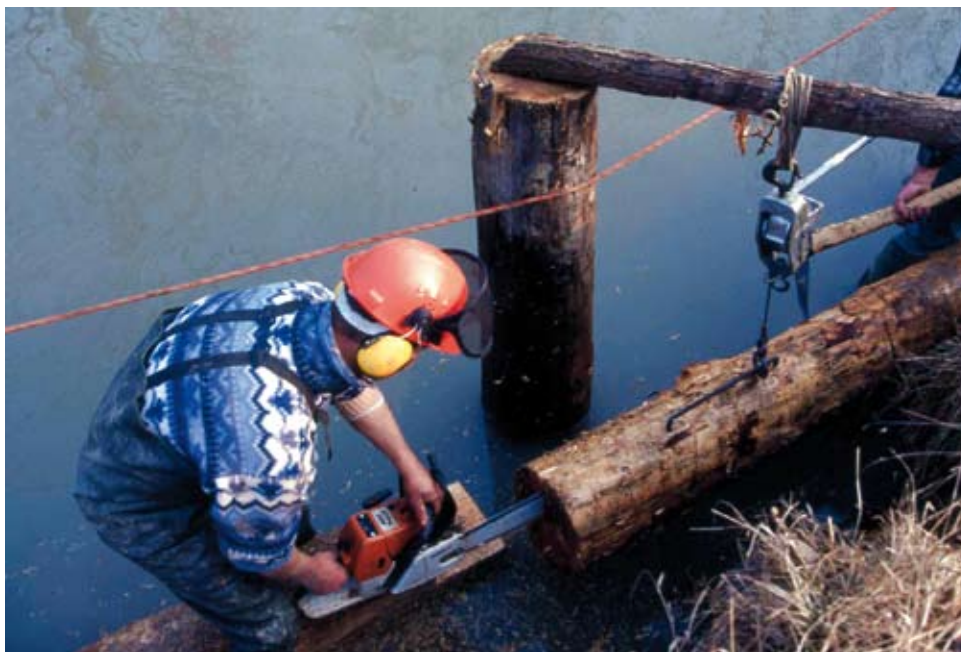
Palificata viva spondale con palo verticale frontale. Scelta di tronchi con diametri simili (in opera) (Foto R.Ferrari).
