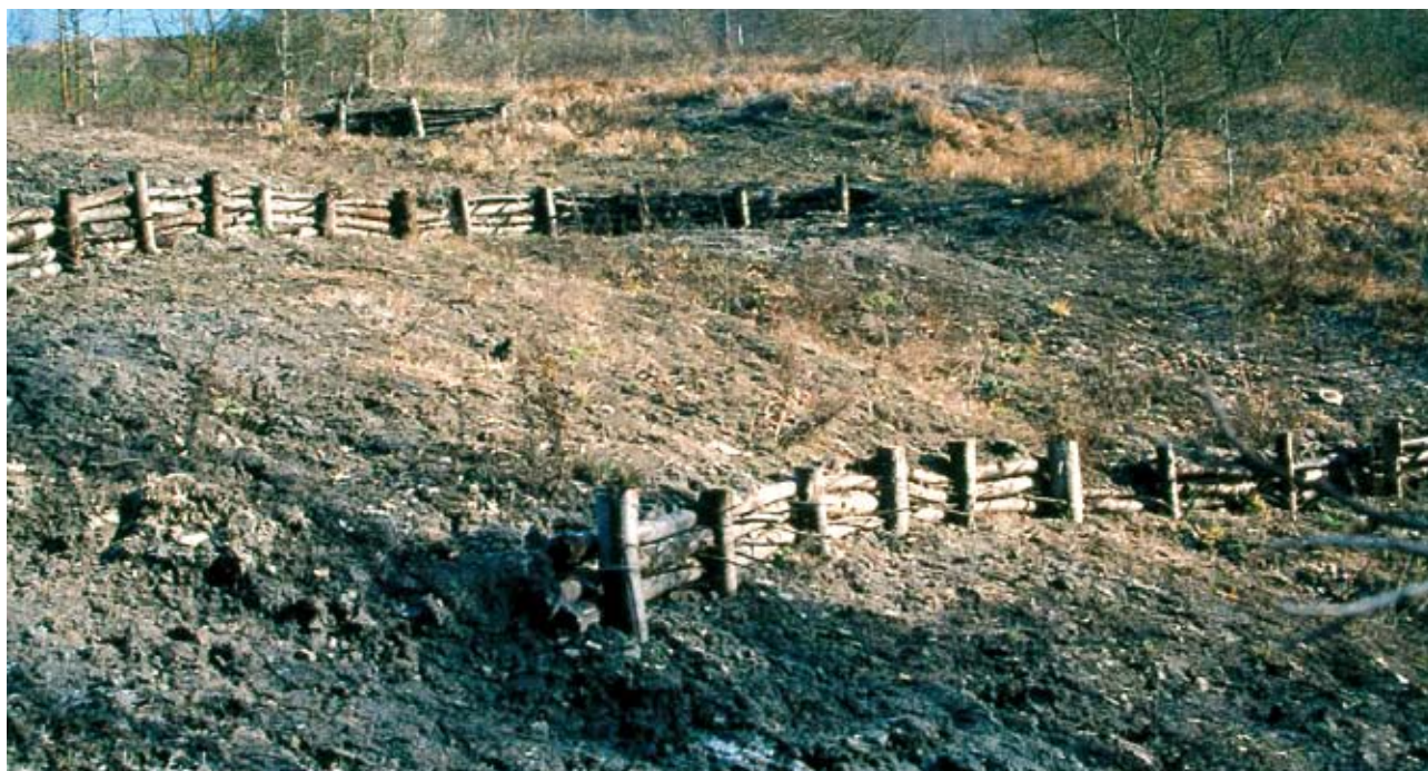
Palizzata viva. Realizzazione a filari (post operam) (Foto R.Ferrari).
