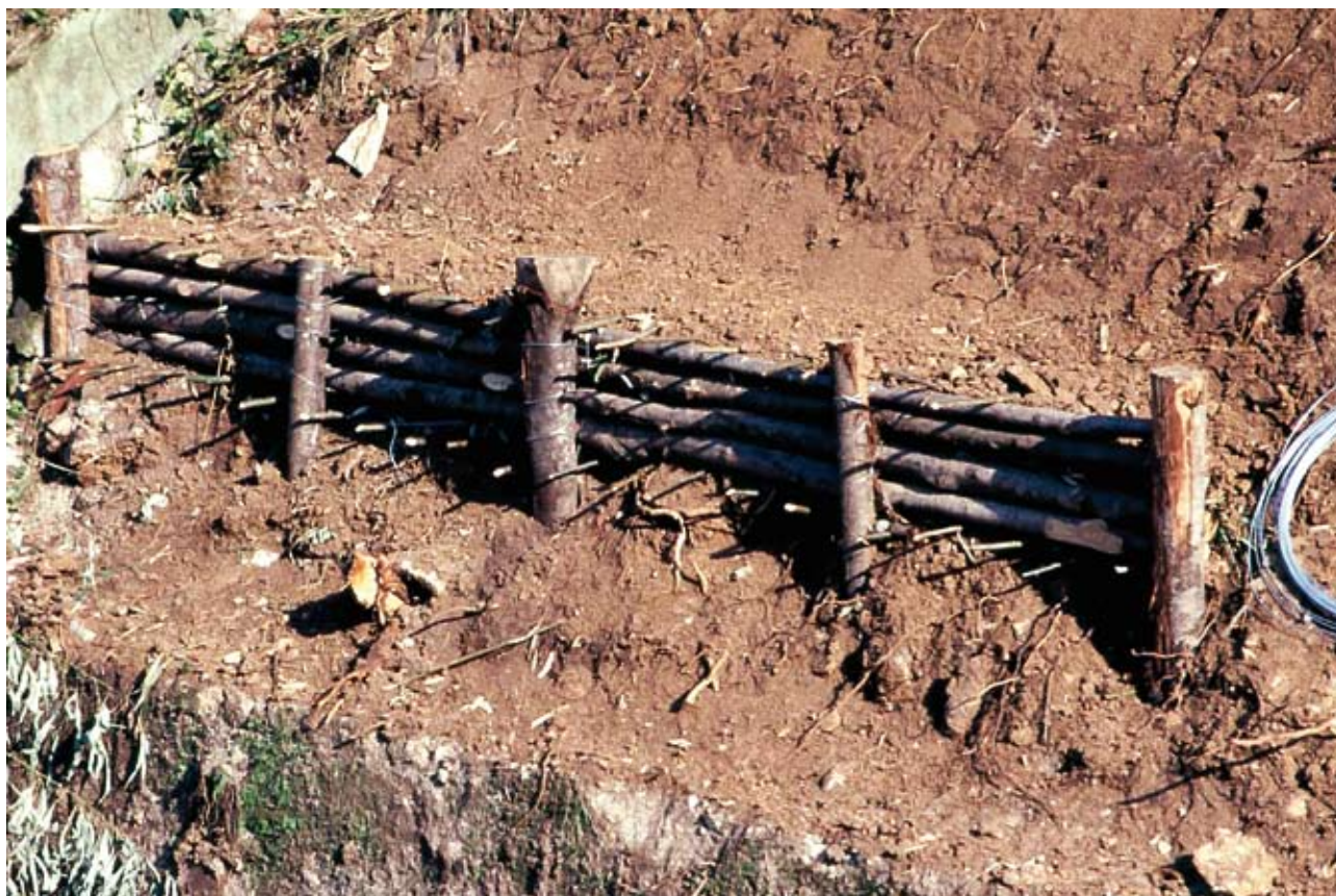
Palizzata viva. Riempimento con materiale inerte di riporto e contemporanea posa di materiale vegetale vivo (talee) (in opera) (Foto R.Ferrari).
