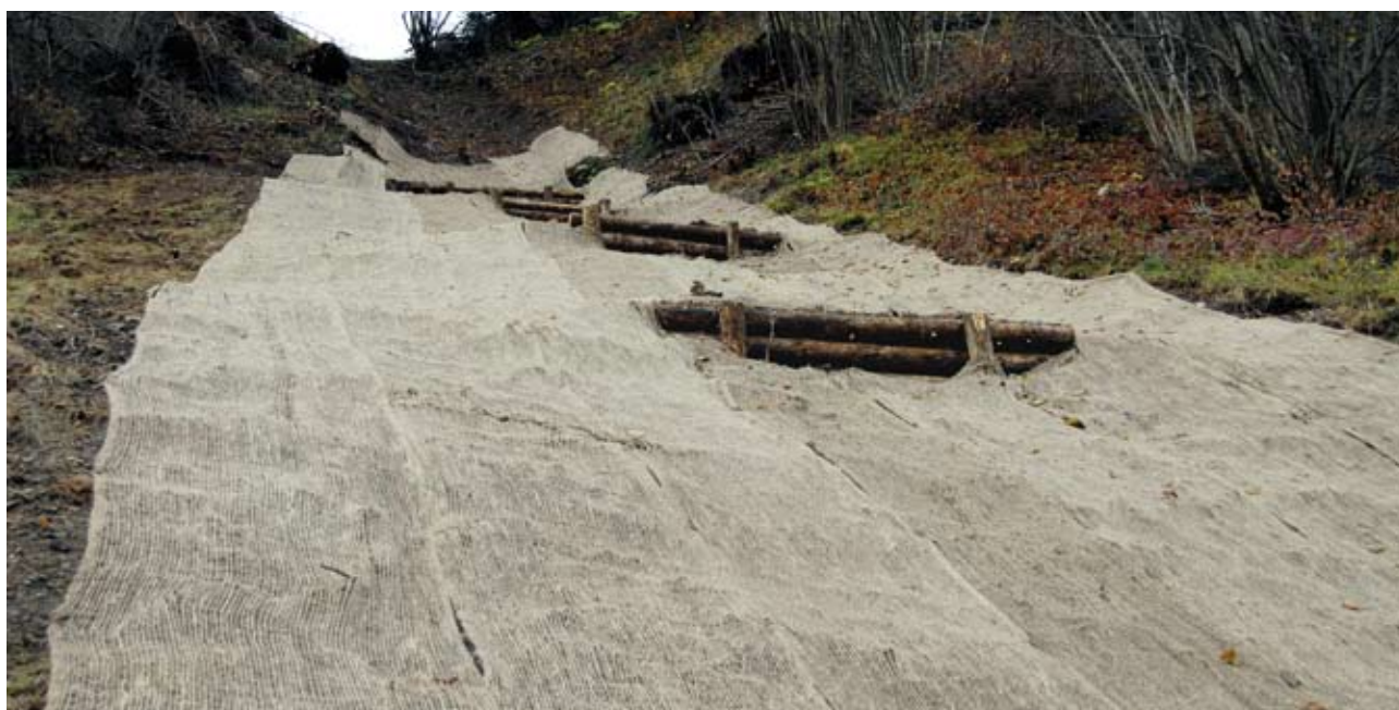
Palizzata viva. Realizzazione a blocchi (in questo caso, essendo il diametro dei tronchi sufficientemente grande, l'unione tra essi è realizzata mediante chiodatura e non mediante legatura con filo di ferro) (post operam) (Foto R.Ferrari).
