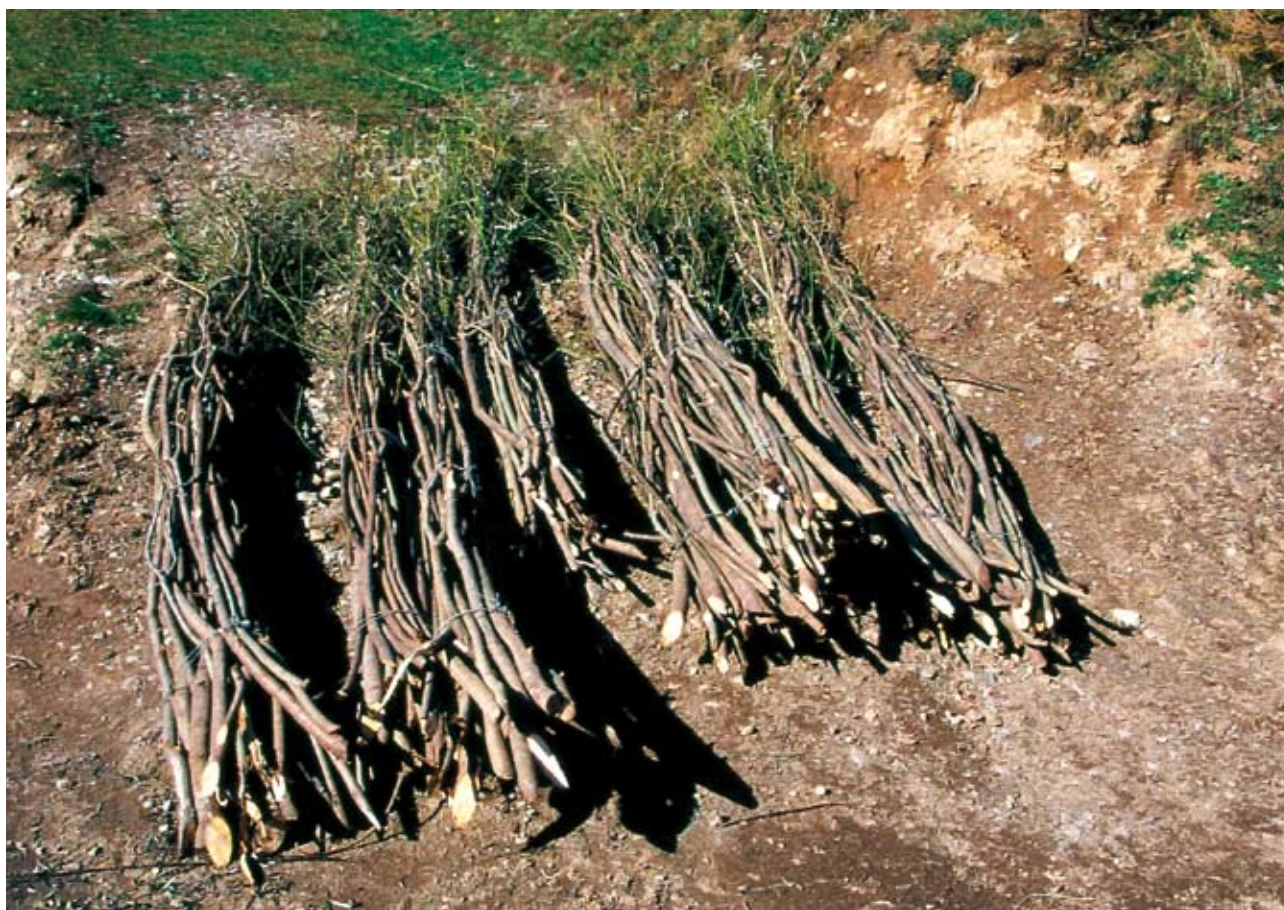
Fascinata viva drenante. Gruppo di fascine preparate e pronte per l'inserimento (in opera) (Foto R.Ferrari).
