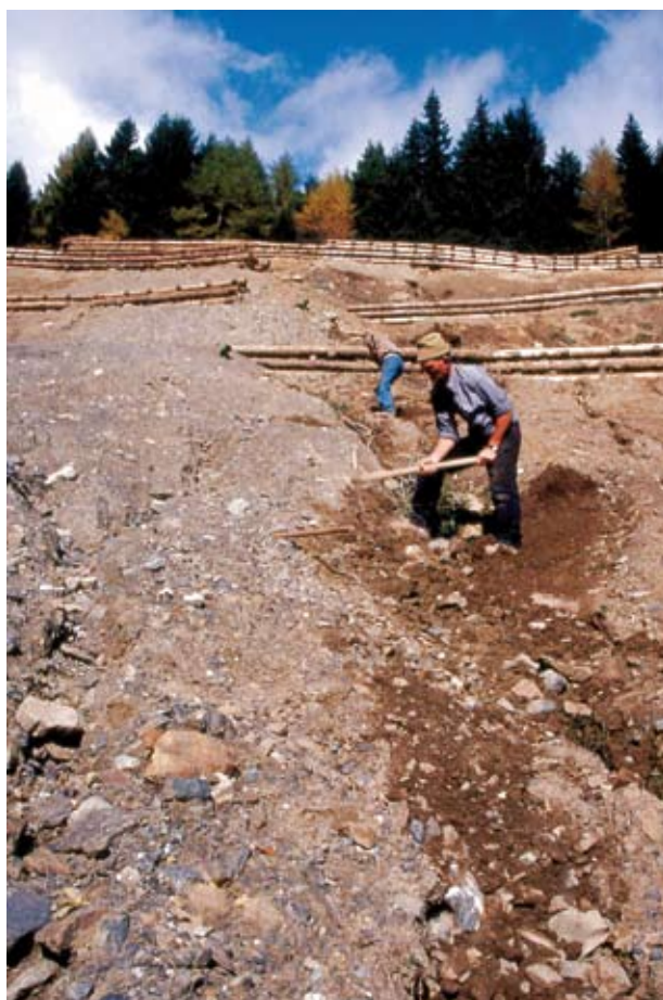
Fascinata viva drenante. Ricolmo del solco (in opera) (Foto R.Ferrari).
