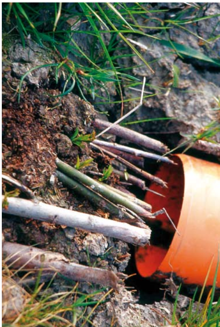
Fascinata viva drenante. Convogliamento in un sistema drenante tradizionale alla base di un intervento con tipologie a basso impatto ambientale (Gradonata viva, Cordonata viva, Viminata viva) (post operam) (Foto R.Ferrari).
