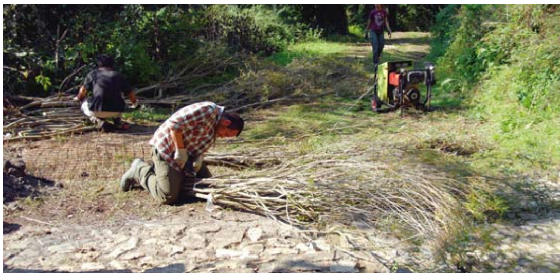
Fascinata viva drenante. Preparazione delle singole fascine (in opera) (Foto R.Ferrari).
