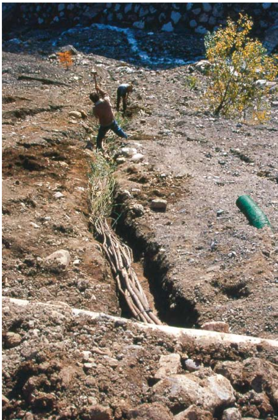
Fascinata viva drenante. Infissione di picchetti di ancoraggio delle singole fascine (in opera) (Foto R.Ferrari).
