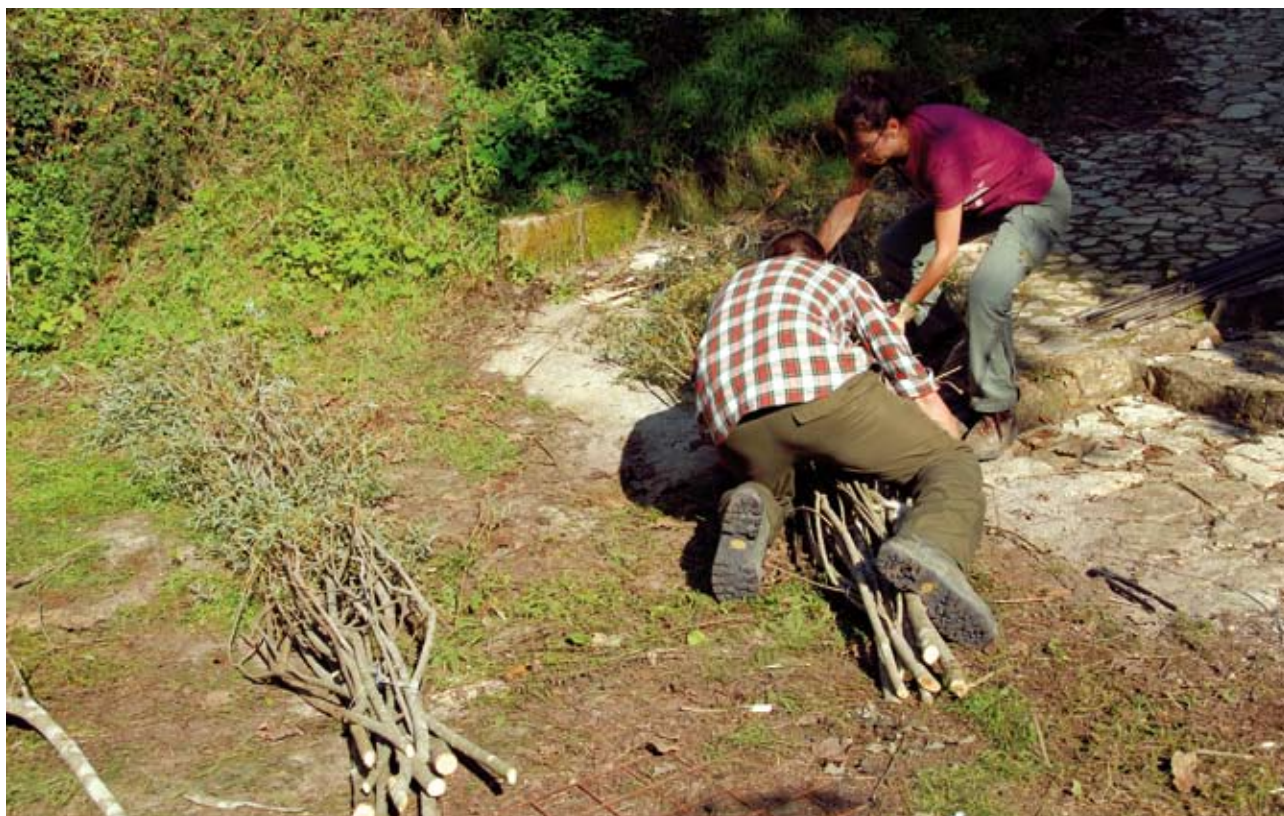
Fascinata viva drenante. Preparazione delle singole fascine (in opera) (Foto R.Ferrari).
