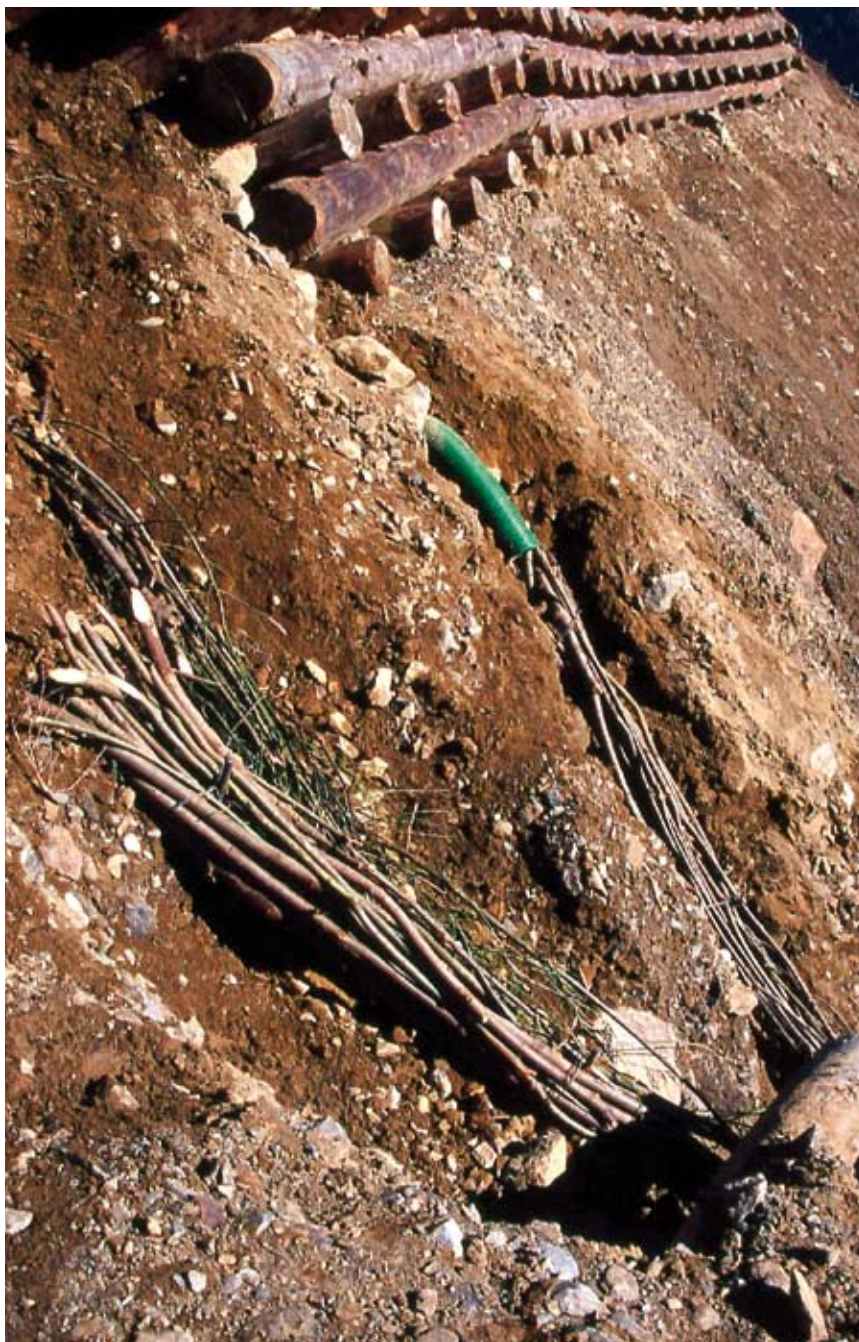
Fascinata viva drenante. Orientamento delle singole fascine dipendente dal verso del flusso (in opera) (Foto R.Ferrari).
