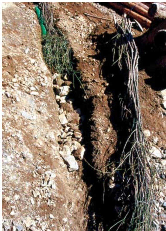
Fascinata viva drenante. Predisposizione della sede di posa (in opera) (Foto R. Ferrari).
