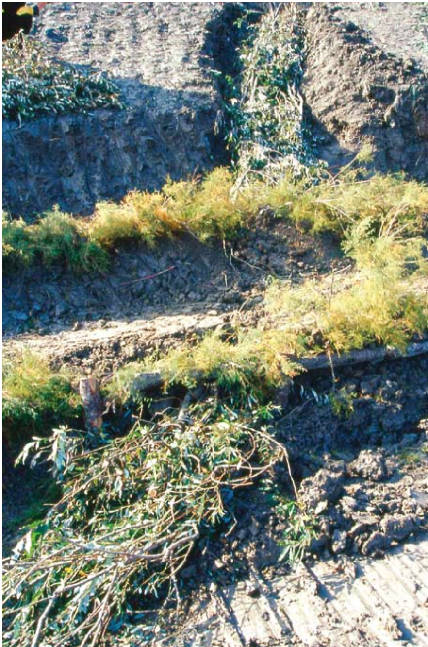
Fascinata viva drenante. Posizionamento delle singole fascine da monte a valle (in opera) (Foto R.Ferrari).
