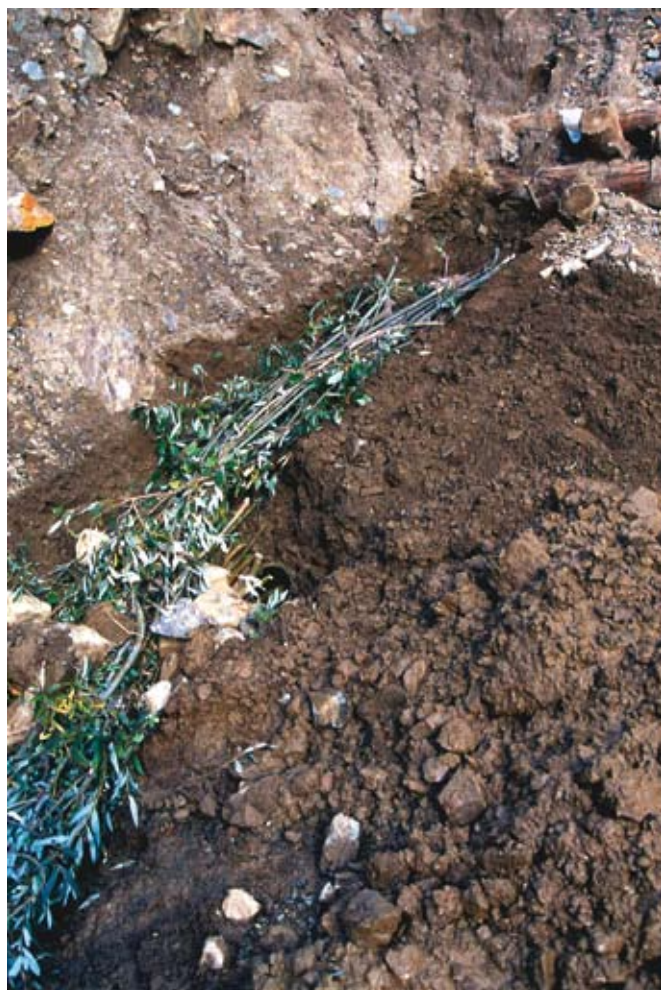
Fascinata viva drenante. Ricolmo del solco (in opera) (Foto R.Ferrari).
