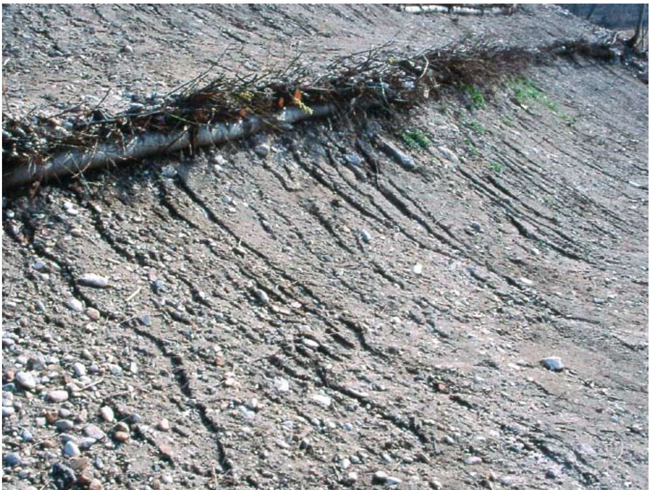
Cordonata viva. Fenomeni erosivi superficiali innescatesi a seguito di intense precipitazioni nella fase immediatamente successiva a quella di realizzazione (post operam) (Foto R.Ferrari).
