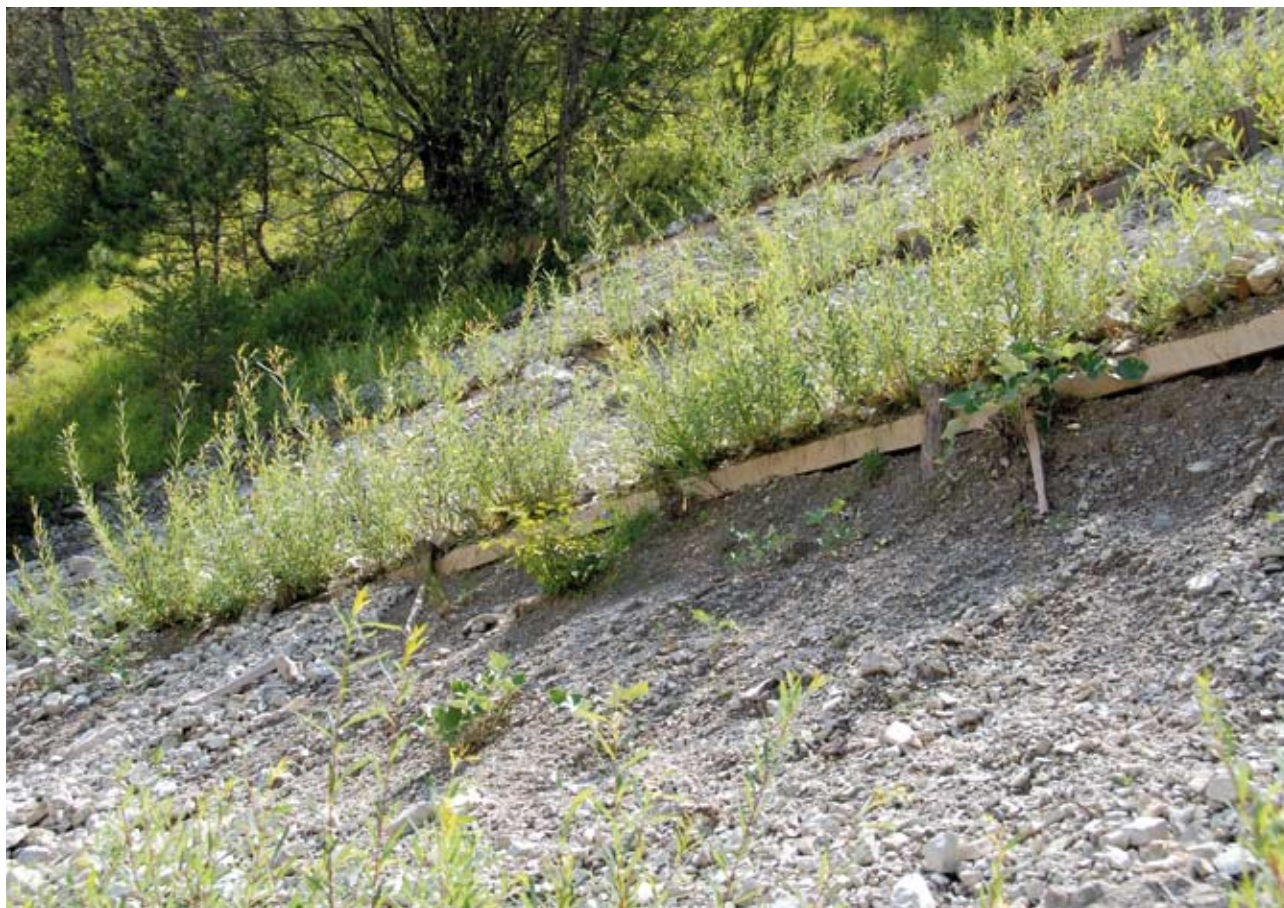
Cordonata viva. Variante con la sola fila esterna di tronchi (mezzi tronchi) (post operam) (Foto R.Ferrari).
