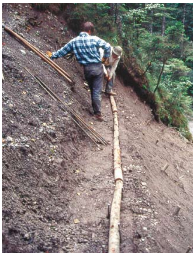
Cordonata viva. Posa di tronchi longitudinali (in opera) (Foto R.Ferrari).
