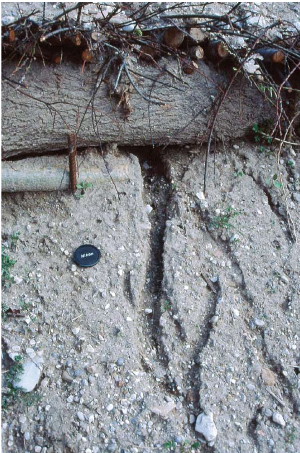
Cordonata viva. Fenomeni erosivi superficiali innescatesi a seguito di intense precipitazioni nella fase immediatamente successiva a quella di realizzazione (post operam) (Foto R.Ferrari).
