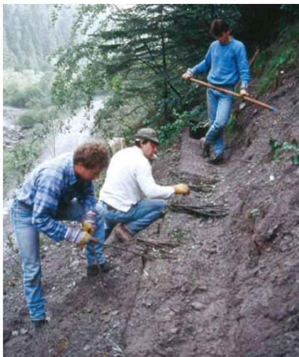
Cordonata viva. Ricolmo dello scavo (in opera) (Foto R.Ferrari).
