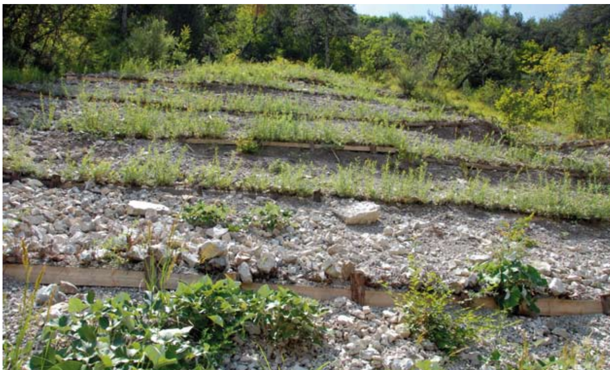
Cordonata viva. Evoluzione all'inizio della prima stagione vegetativa (post operam) (Foto R.Ferrari).
