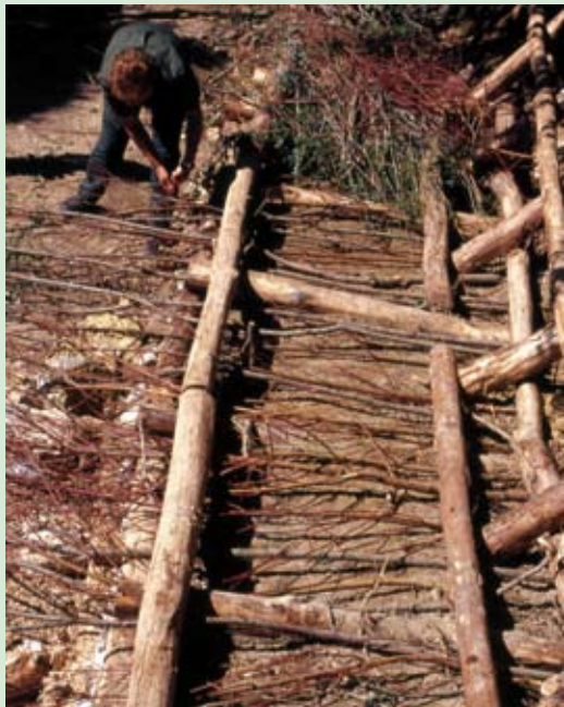
Astoni di SALIX PURPUREA inseriti nella costruenda struttura, prima del loro definitivo dimensionamento che fornirà altro materiale vegetale vivo idoneo (Foto R.Ferrari).
