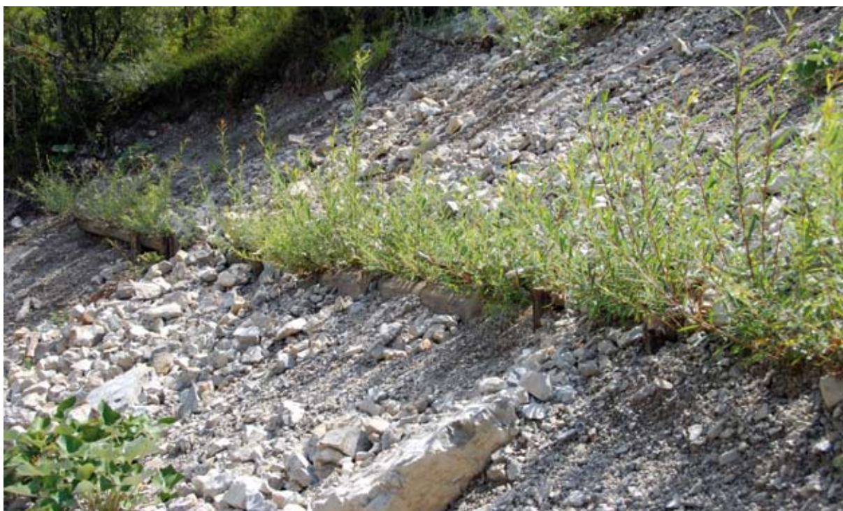
Cordonata viva. Il buon attecchimento del materiale vegetale vivo utilizzato ed una colonizzazione spontanea pioniera di specie presenti in loco, testimoniano il buon inserimento ecologico dell'intervento (post operam) (Foto R.Ferrari).
