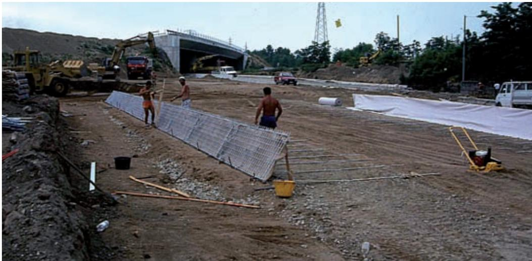
Terra rinforzata rinverdita (di versante), Gruppo C. Completamento della posa e fissaggio del primo ordine di elementi (in opera) (Foto R.Ferrari).
