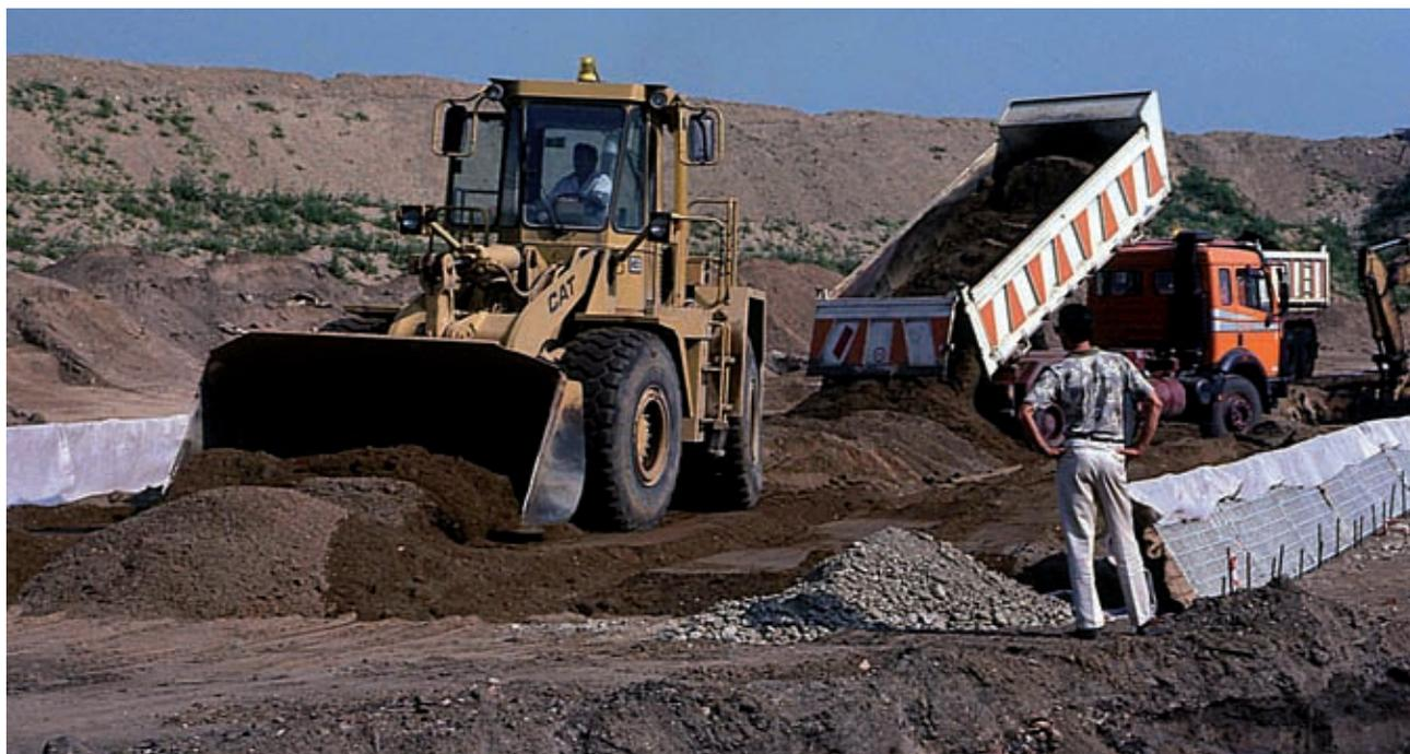
*Terra rinforzata rinverdita (di versante), Gruppo C. Realizzazione del primo strato di riempimento con materiale inerte di riporto del primo ordine di elementi (in opera) (Foto R.Ferrari).*
