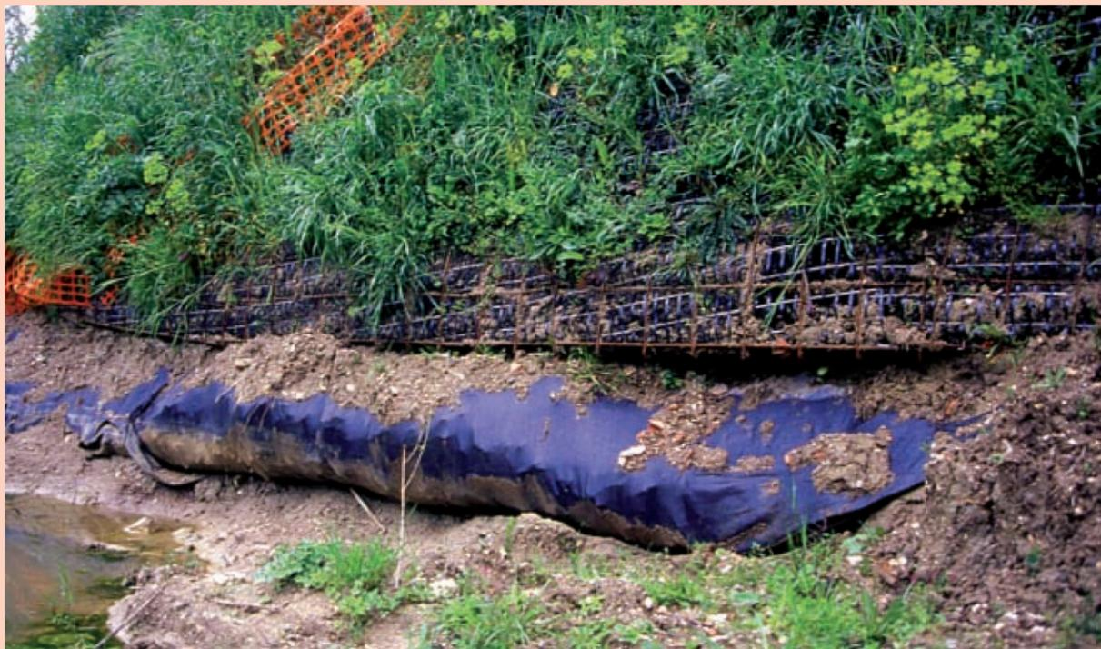
*Terra rinforzata rinverdita (di versante), s.l. Cedimento della parte basale a causa delle non idonee caratteristiche geotecniche del substrato (post operam) (Foto R.Ferrari).*
