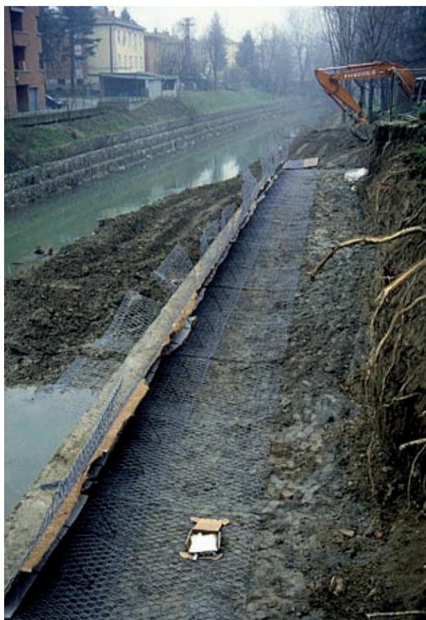
Terra rinforzata rinverdita (di versante), Gruppo D. Posa e fissaggio del primo ordine di elementi (in opera) (Foto R.Ferrari).
