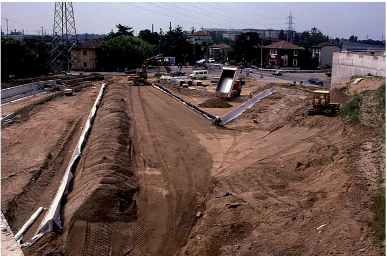
Terra rinforzata rinverdita (di versante), Gruppo C. Completamento del riempimento con materiale inerte di riporto del primo ordine di elementi (in opera) (Foto R.Ferrari).
