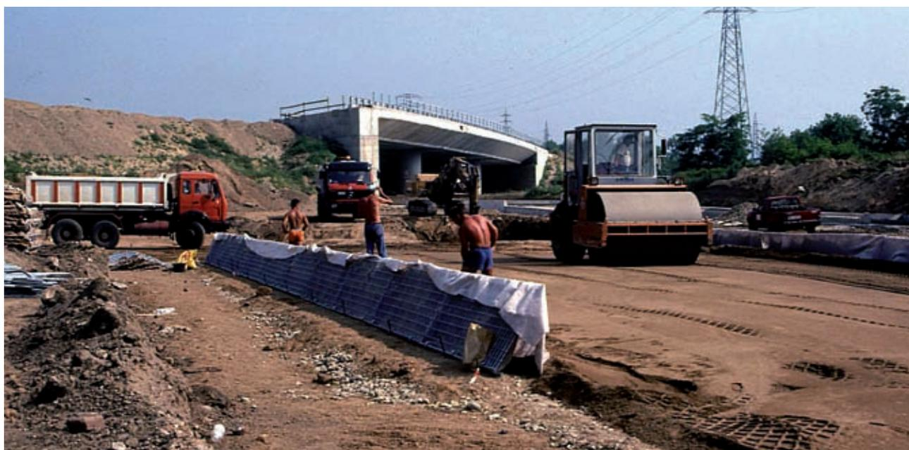
*Terra rinforzata rinverdita (di versante) Gruppo C. Rullatura del primo strato di riempimento con materiale inerte di riporto del primo ordine di elementi (in opera) (Foto R.Ferrari).*
