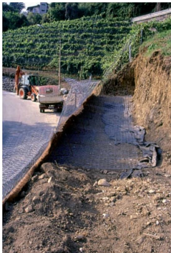
A sinistra: Terra rinforzata rinverdita (di versante), Gruppo D. Realizzazione di successivi ordini di elementi (in opera) (Foto R.Ferrari). A destra: Terra rinforzata rinverdita (di versante), Gruppo D. Realizzazione di successivi ordini di elementi (in opera) (Foto R.Ferrari).
