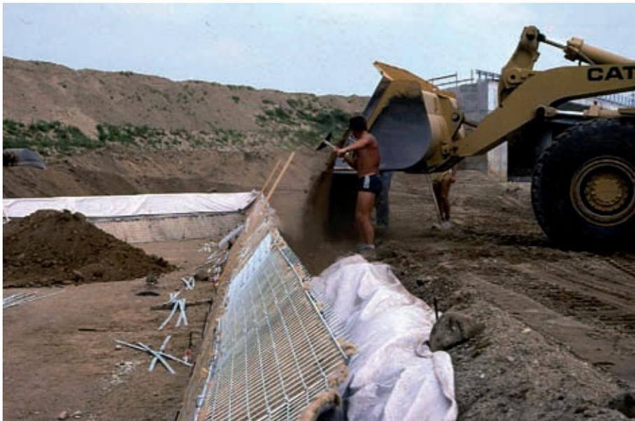
**Terra rinforzata rinverdita (di versante) Gruppo C. Completamento del riempimento con terreno vegetale del secondo ordine di elementi (in opera) (Foto R.Ferrari).**
