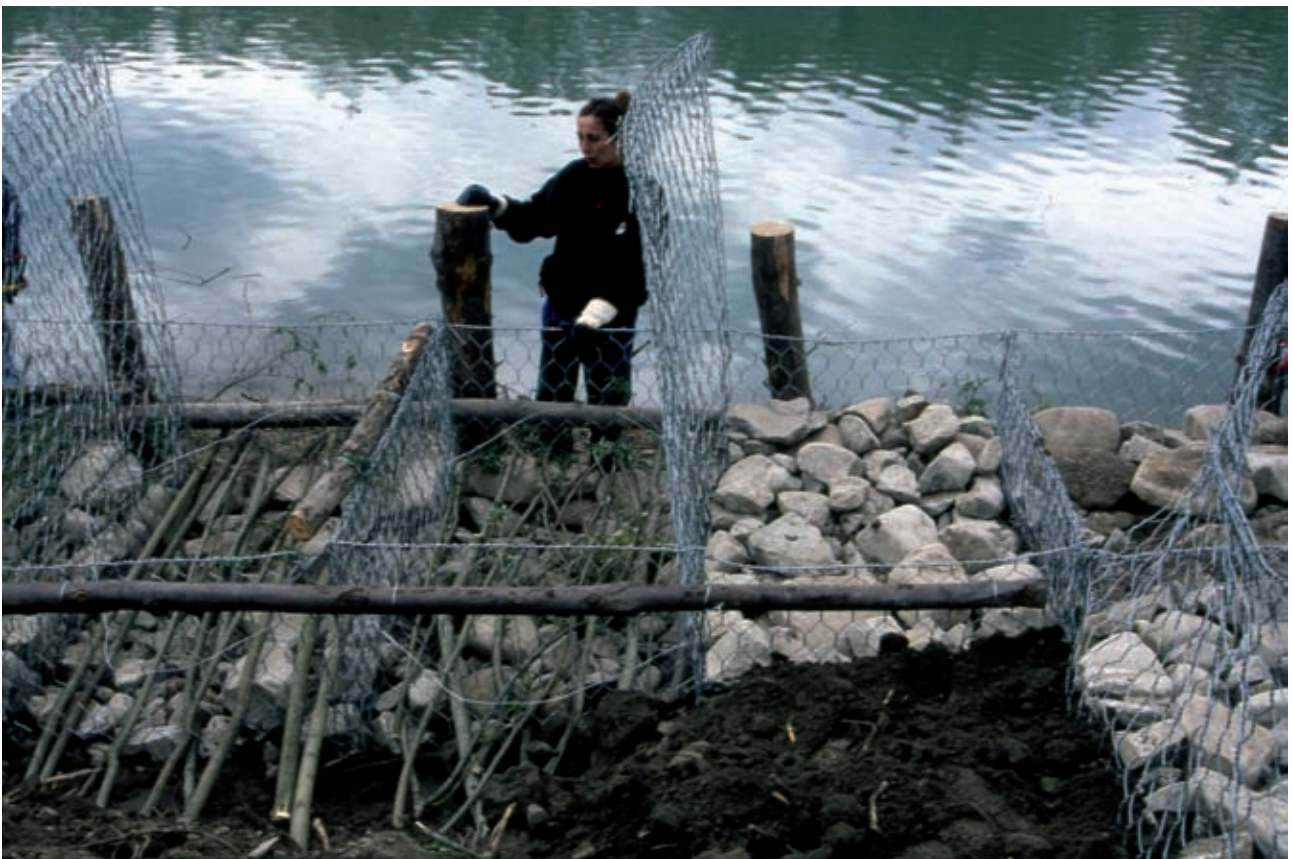
Gabbionata in rete metallica zincata rinverdita (di versante e spondale). Inserimento del materiale vegetale vivo (astoni di SALIX sp.) (ambito fluviale) (in opera) (Foto R.Ferrari).
