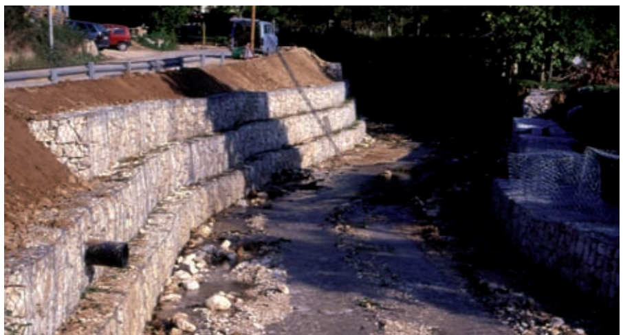
Dis. 17 - Gabionata in rete metallica zincata rinverdita (di versante e spondale). Fase 11 - Ambito terrestre (sezione).
