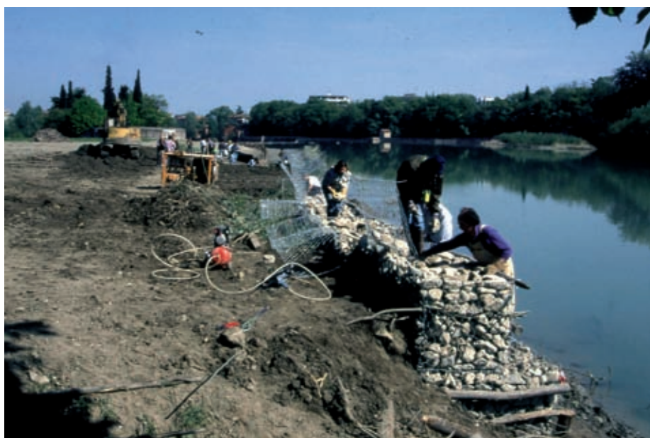
Gabbionata in rete metallica zincata rinverdita (di versante e spondale). Chiusura dei singoli elementi ("gabbioni") (ambito fluviale) (in opera) (Foto R.Ferrari).
