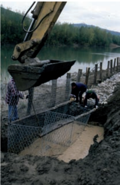
Gabbionata in rete metallica zincata rinverditata (di versante e spondale). Inizio del riempimento del primo ordine di elementi ("gabbioni") (ambito fluviale) (in opera) (Foto R.Ferrari).
