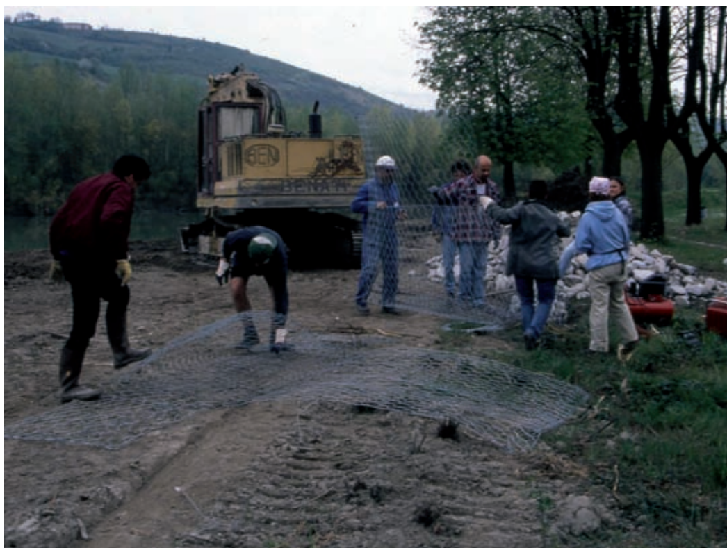
Gabbionata in rete metallica zincata rinverdiata (di versante e spondale). Apertura degli elementi ("gabbioni") (ambito fluviale) (in opera) (Foto R.Ferrari).
