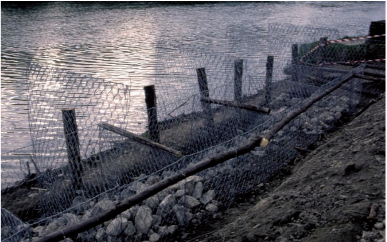
Gabbionata in rete metallica zincata rinverdita (di versante e spondale). Parziale riempimento prima della posa del materiale vegetale vivo (ambito fluviale) (in opera) (Foto R.Ferrari).
