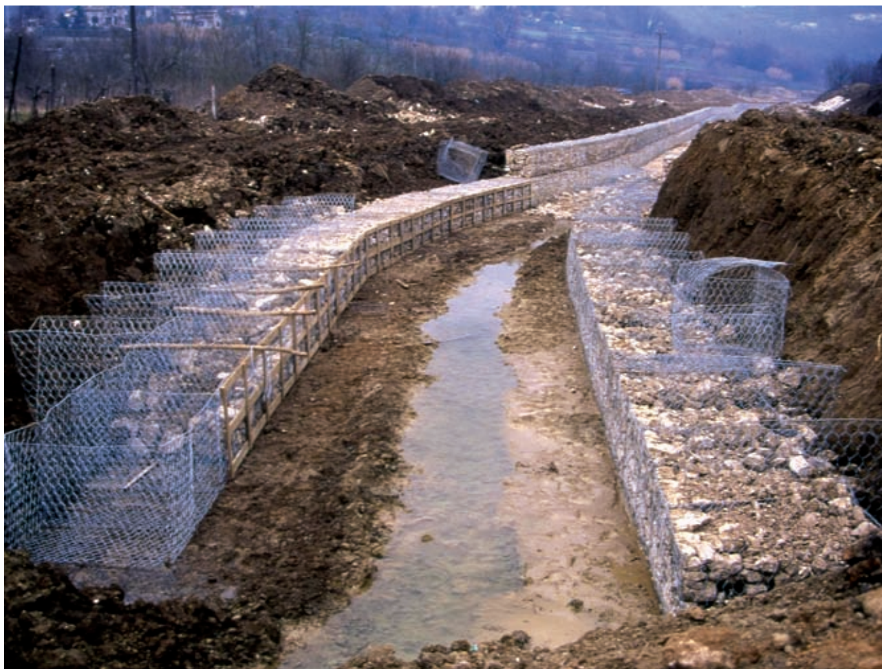
Gabbionata in rete metallica zincata rinverditata (di versante e spondale). Riempimento scalare di un ordine di elementi ("gabbioni") di una stessa fila (ambito fluviale) (in opera) (Foto R.Ferrari).
