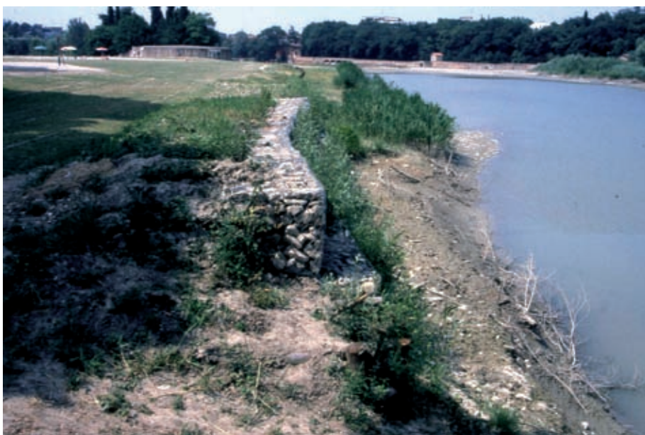
Gabbionata in rete metallica zincata rinverdita (di versante e spondale). Evoluzione all'inizio della prima stagione vegetativa (ambito fluviale) (post operam) (Foto R.Ferrari).
