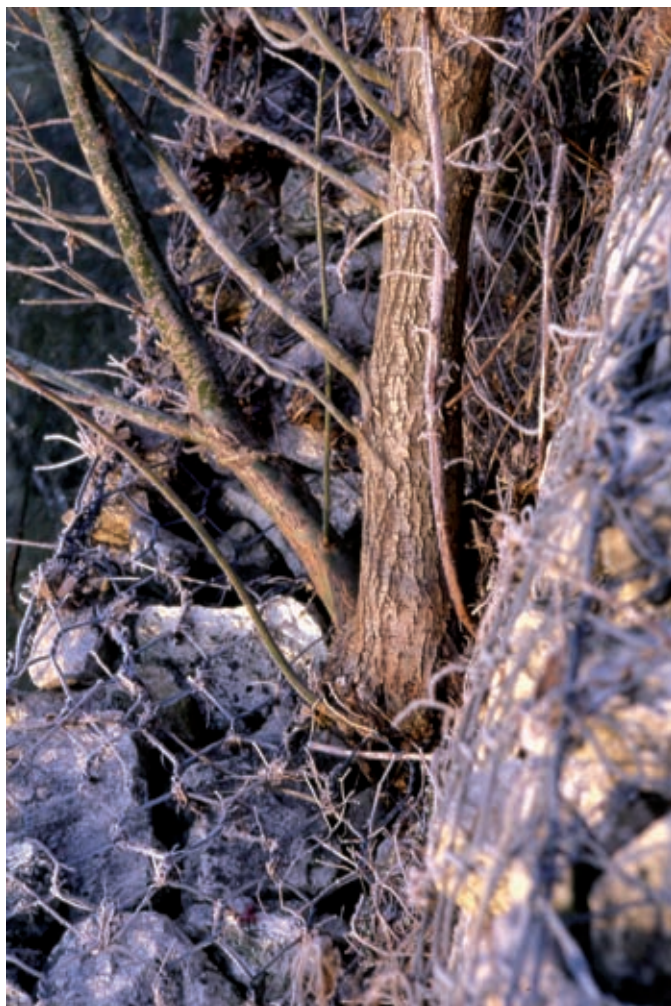
Gabbionata in rete metallica zincata rinverdita (di versante e spondale). Evoluzione dopo alcune stagioni vegetative (ambito fluviale) (post operam) (Foto R.Ferrari).
