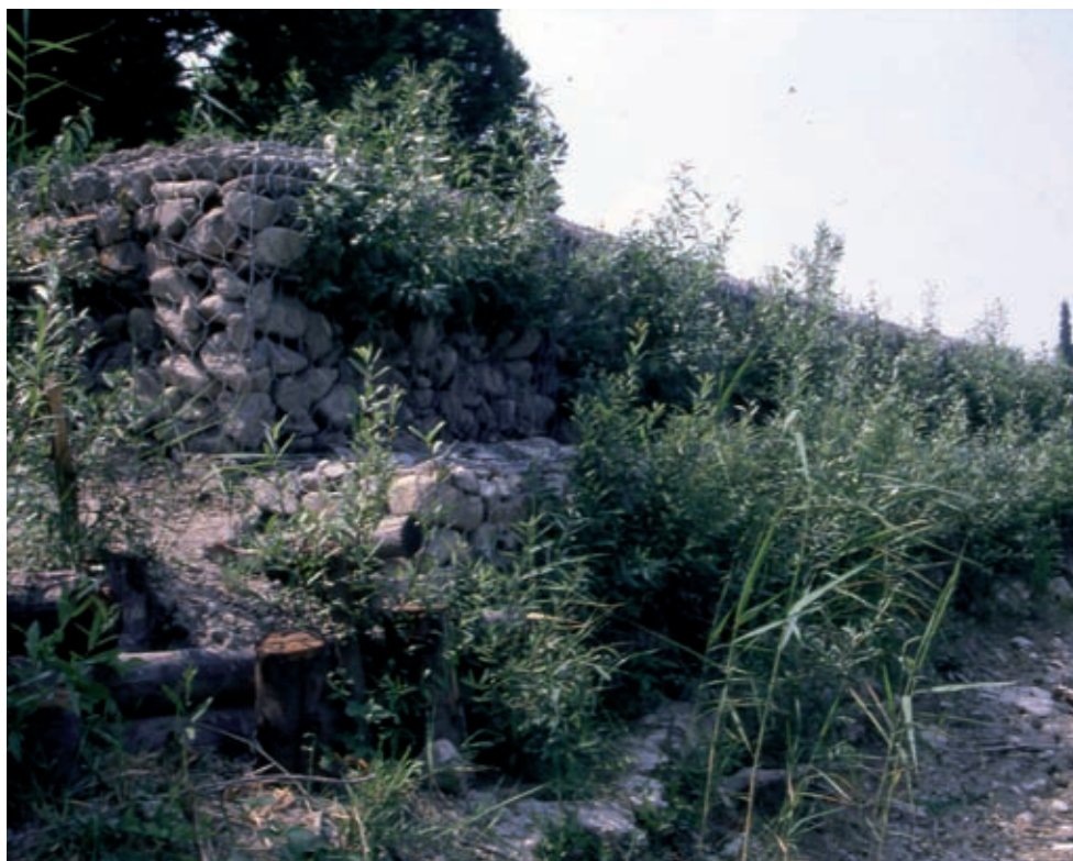
Gabbionata in rete metallica zincata rinverdi- ta (di versante e spon- dale). Come si presenta la tipologia all'inizio della prima stagione vegetativa (ambito flu- viale) (post operam) (Foto R.Ferrari).
