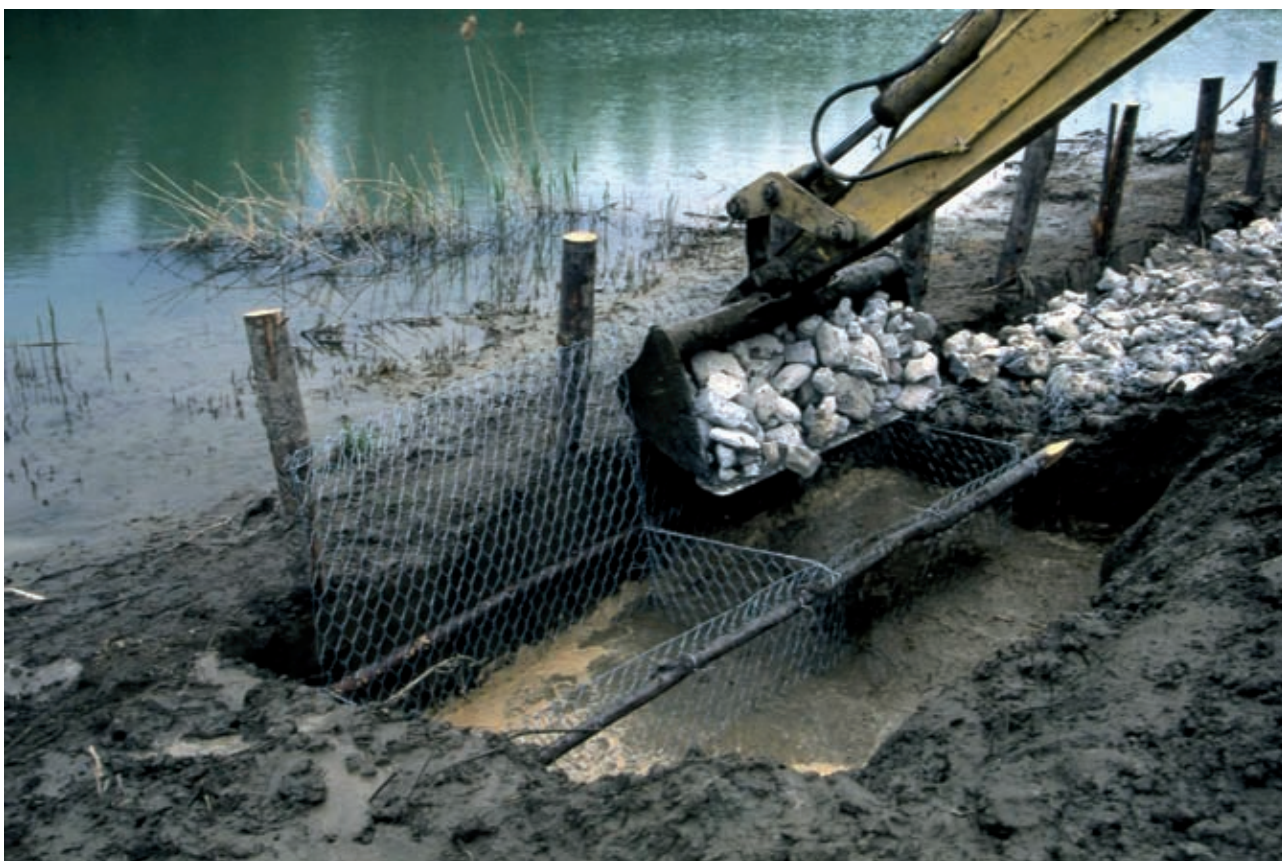
Gabbionata in rete metallica zincata rinverdita (di versante e spondale). Realizzazione di una struttura provvisoria di rinforzo mediante l'utilizzo di tronchi di piccolo diametro (ambito fluviale) (in opera) (Foto R.Ferrari).
