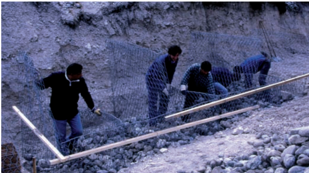
Gabbionata in rete metallica zincata rinverdata (di versante e spondale). Sistemazione manuale dei singoli ciottoli (ambito terrestre) (in opera) (Foto R.Ferrari).
