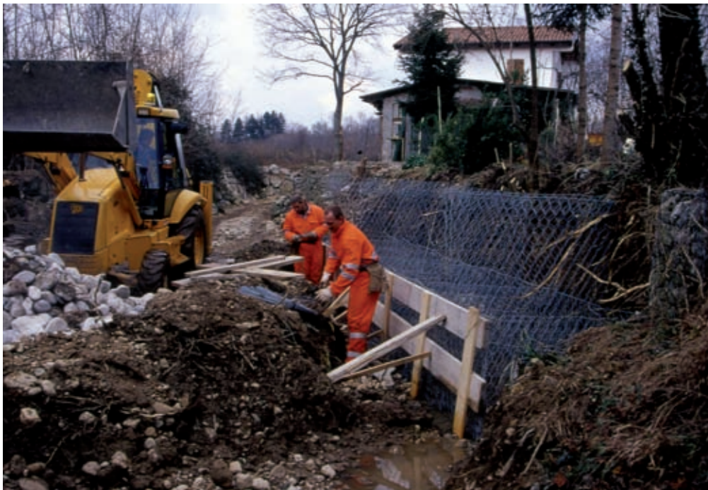
Gabbionata in rete metallica zincata rinverdita (di versante e spondale). Realizzazione di una struttura provvisoria di rinforzo mediante l'utilizzo di assi di legno (ambito fluviale) (in opera) (Foto R.Ferrari).
