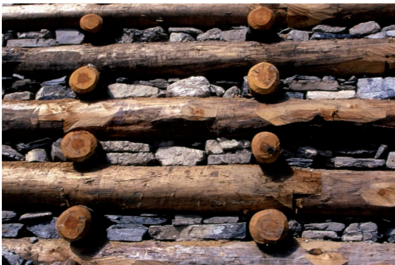
Briglia viva in legname e pietrame. Nella parte centrale della struttura, corrispondente alla zona di gaveta, non va posizionato materiale vegetale vivo (in opera) (Foto R.Ferrari).
