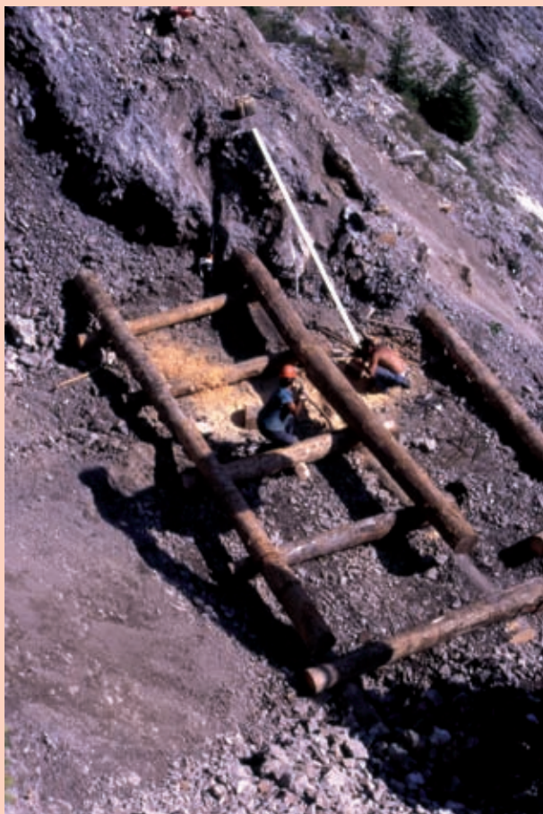
Briglia viva in legname e pietrame. Fissaggio del secondo ordine di tronchi longitudinali (correnti). Erronea realizzazione di tacca di livellamento sul lato superiore del tronco trasversale sottostante (in opera) (Foto R.Ferrari).
