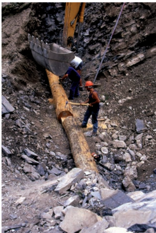
A sinistra: Briglia viva in legname e pietrame. Posa del primo ordine di tronchi longitudinali (correnti) (in opera) (Foto R.Ferrari). A destra: Briglia viva in legname e pietrame. Posa del primo ordine di tronchi longitudinali (correnti): realizzazione della giuntura ad incastro (in opera) (Foto R.Ferrari).
