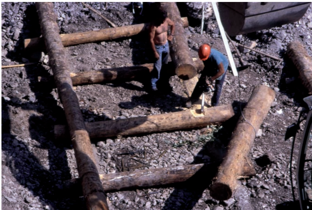
Briglia viva in legname e pietrame. Posa del secondo ordine di tronchi longitudinali (correnti) (in opera) (Foto R.Ferrari).
