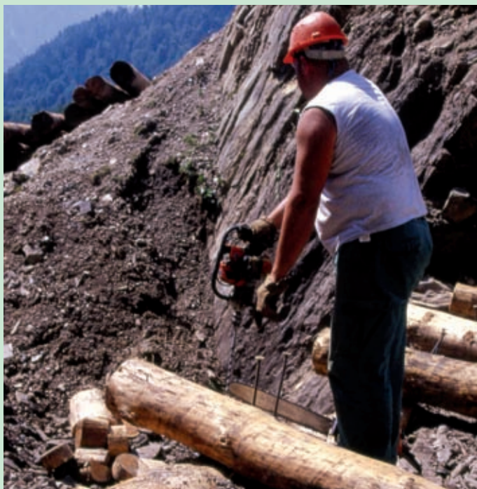
Esecuzione del foro (Foto R.Ferrari).
