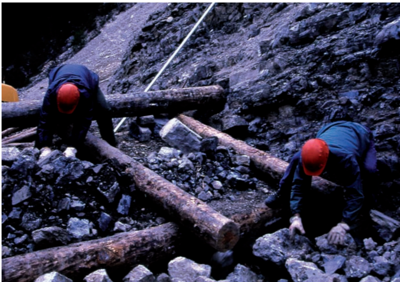
Briglia viva in legname e pietrame. Riempimento con materiale inerte litoide (in opera) (Foto R.Ferrari).
