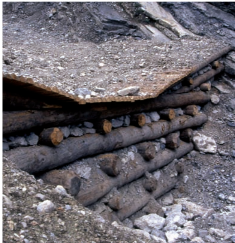
A sinistra: Briglia viva in legname e pietrame. Sagomatura dei tronchi trasversali troppo sporgenti (in opera) (Foto R.Ferrari). A destra: Briglia viva in legname e pietrame. Sistemazione finale dell'area di cantiere (in opera) (Foto R.Ferrari).
