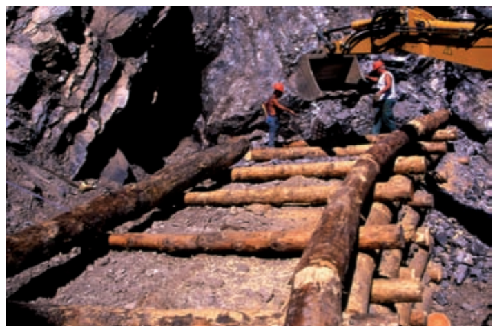
Briglia viva in legname e pietrame. Realizzazione di corsi successivi (in opera) (Foto R.Ferrari).
