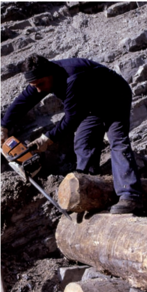
A sinistra: Briglia viva in legname e pietrame. Sagomatura dei tronchi trasversali troppo sporgenti (in opera) (Foto R.Ferrari). A destra: Briglia viva in legname e pietrame. Sistemazione finale dell'area di cantiere (in opera) (Foto R.Ferrari).
