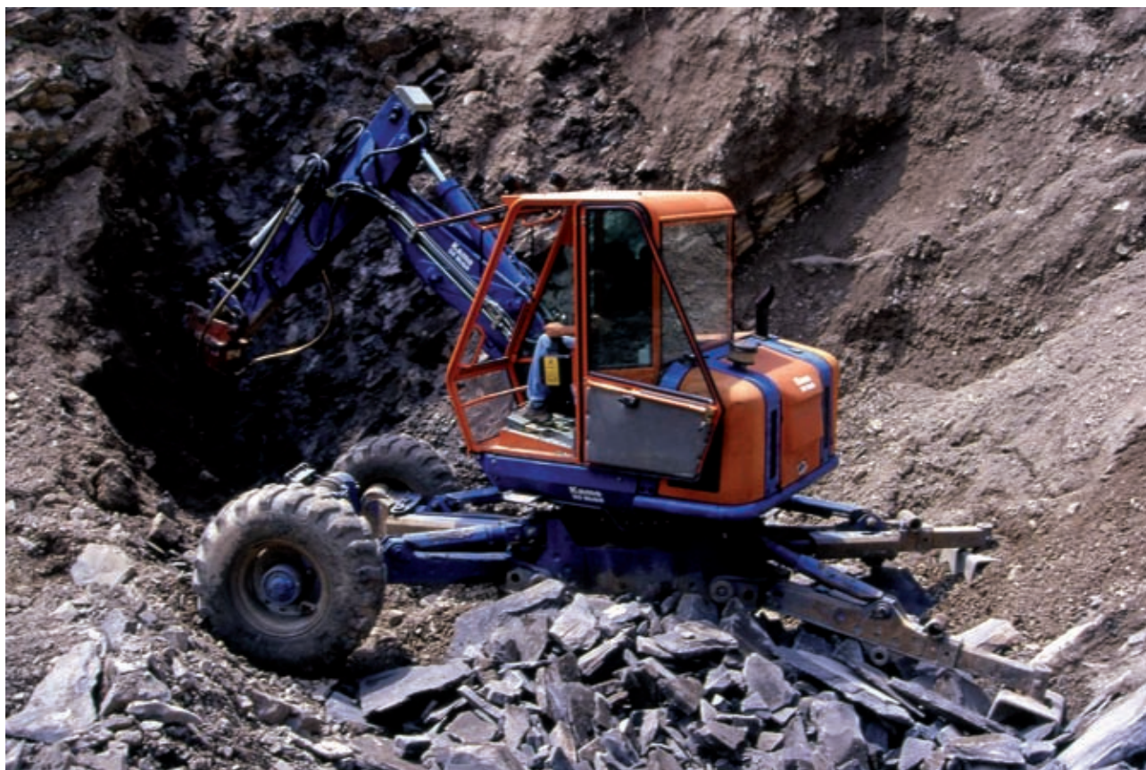
Briglia viva in legname e pietrame. Predisposizione della sede di posa: ammorsamento laterale in substrato roccioso (in opera) (Foto R.Ferrari).
