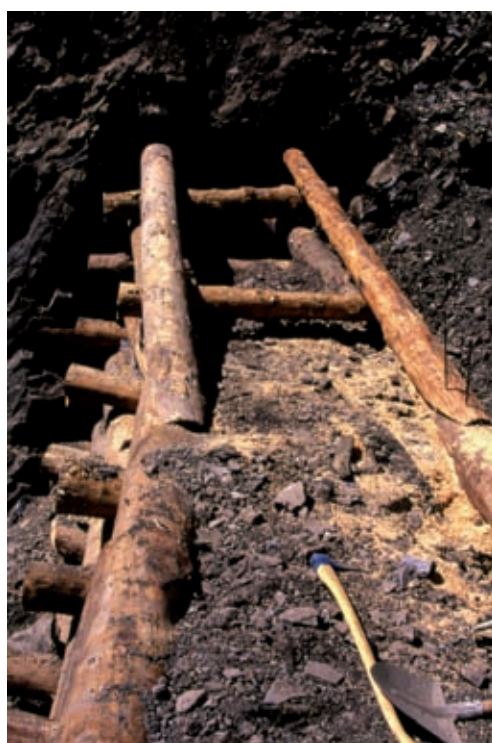
A sinistra: Briglia viva in legname e pietrame. Realizzazione della gaveta (in opera) (Foto R.Ferrari). A destra: Briglia viva in legname e pietrame. Realizzazione della gaveta (in opera) (Foto R.Ferrari).
