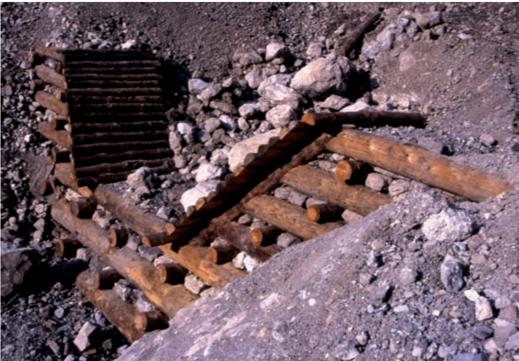
Briglia viva in legname e pietrame. Eventi di trasporto solido eccezionale possono danneggiare parte della struttura (in opera) (Foto R.Ferrari).
