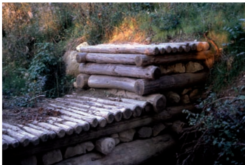
Briglia viva in legname e pietrame. Gaveta a tronchi orizzontali (in opera) (Foto R.Ferrari).
