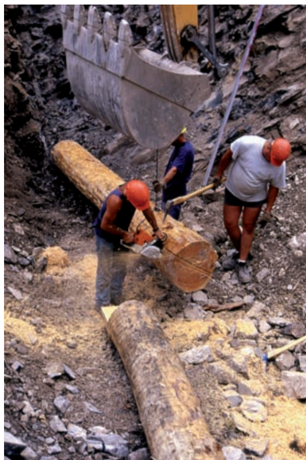
A sinistra: Briglia viva in legname e pietrame. Posa del primo ordine di tronchi longitudinali (correnti) (in opera) (Foto R.Ferrari). A destra: Briglia viva in legname e pietrame. Posa del primo ordine di tronchi longitudinali (correnti): realizzazione della giuntura ad incastro (in opera) (Foto R.Ferrari).
