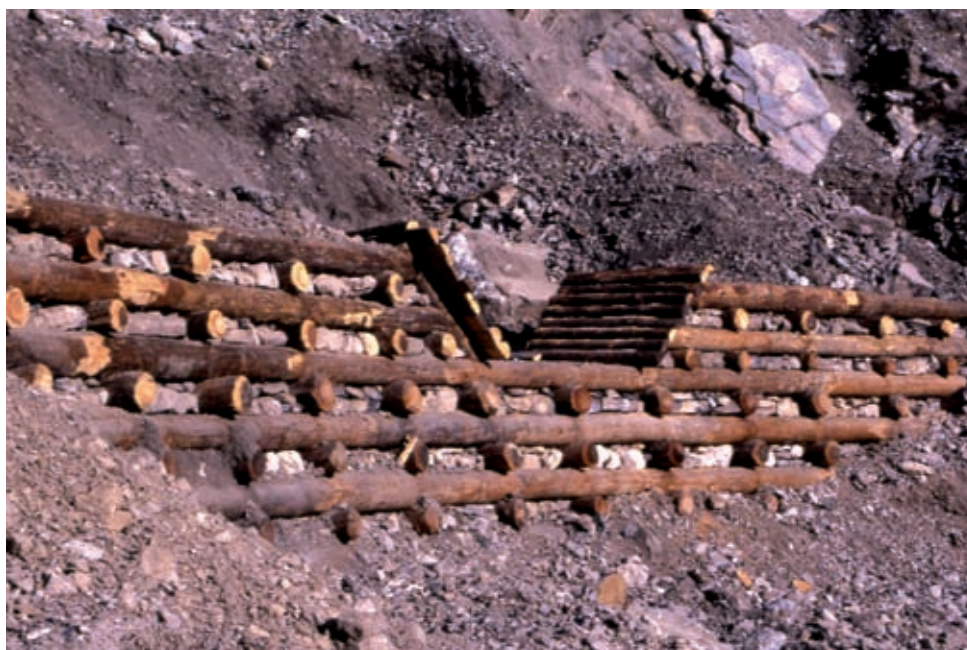
Briglia viva in legname e pietrame. Come si presenta la tipologia appena terminata la fase realizzativa di cantiere (post operam) (Foto R.Ferrari).
