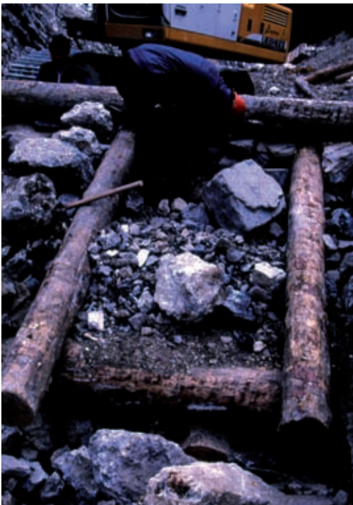
A sinistra: Briglia viva in legname e pietrame. Realizzazione di corsi successivi (in opera) (Foto R.Ferrari). A destra: Briglia viva in legname e pietrame. Realizzazione di corsi successivi (in opera) (Foto R.Ferrari).
