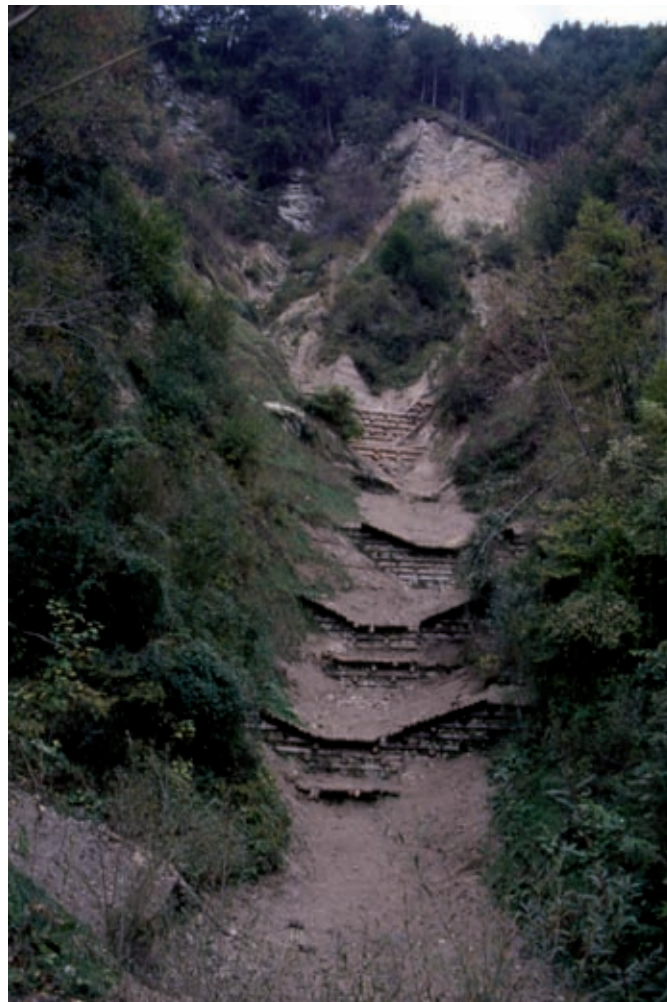
Briglia viva in legname e pietrame. Sistemazione di un asta torrentizia mediante l'utilizzo di questa tipologia (post operam) (Foto R.Ferrari).
