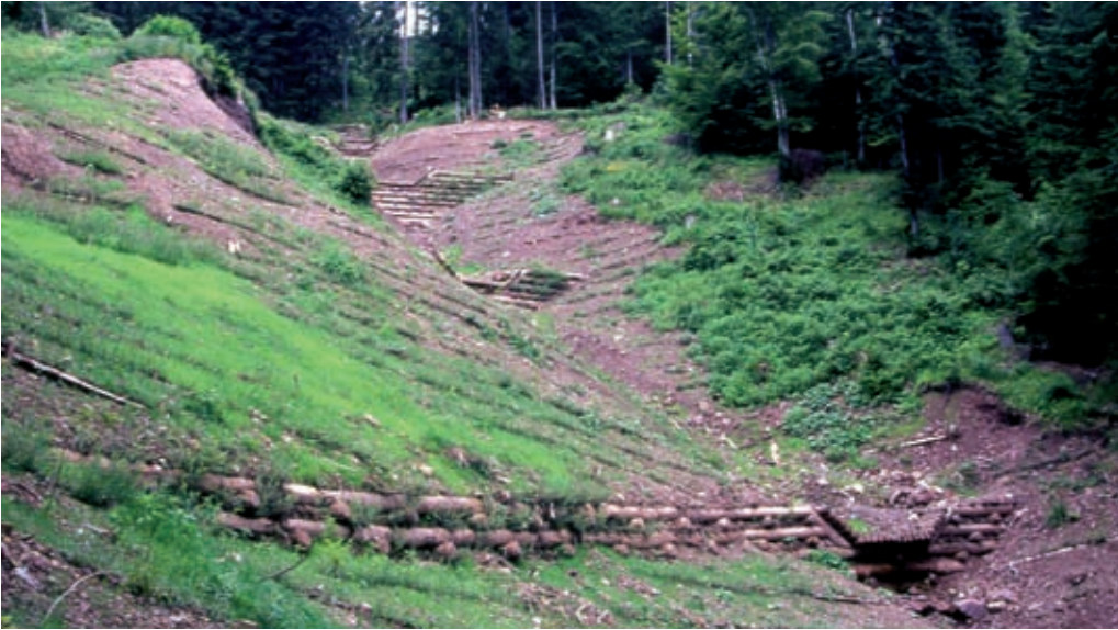
Briglia viva in legname e pietrame. Serie di briglie vive in legname e pietrame in un rio (post operam) (Foto R.Ferrari).
