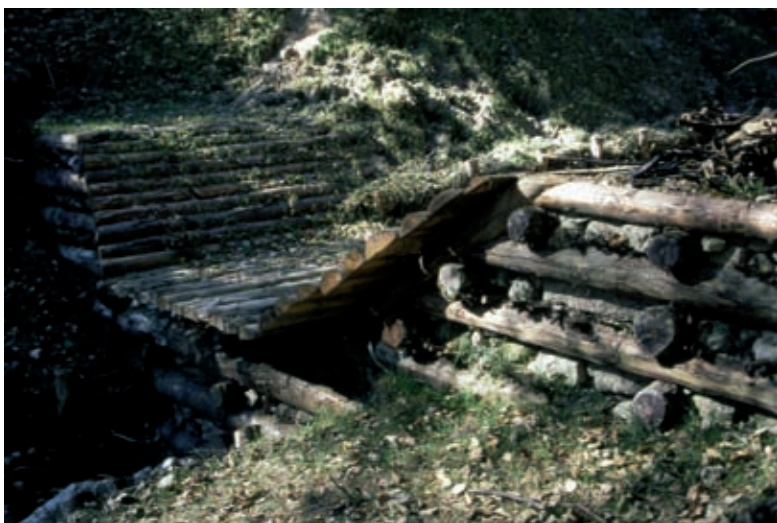
Briglia viva in legname e pietrame. Inserimento della struttura nel contesto naturale (post operam) (Foto R.Ferrari).
