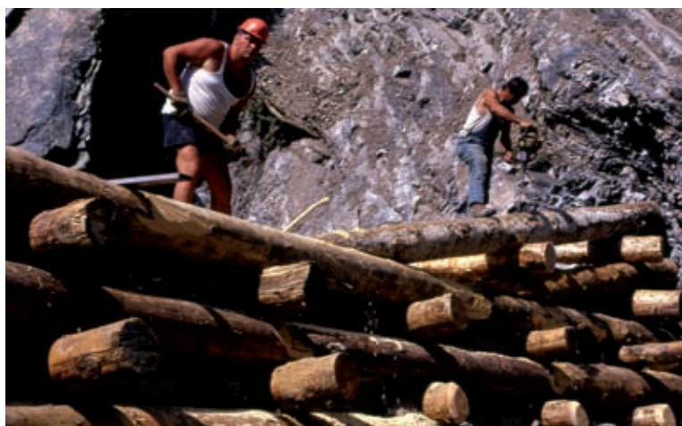
Briglia viva in legname e pietrame. Realizzazione della gaveta (in opera) (Foto R.Ferrari).
