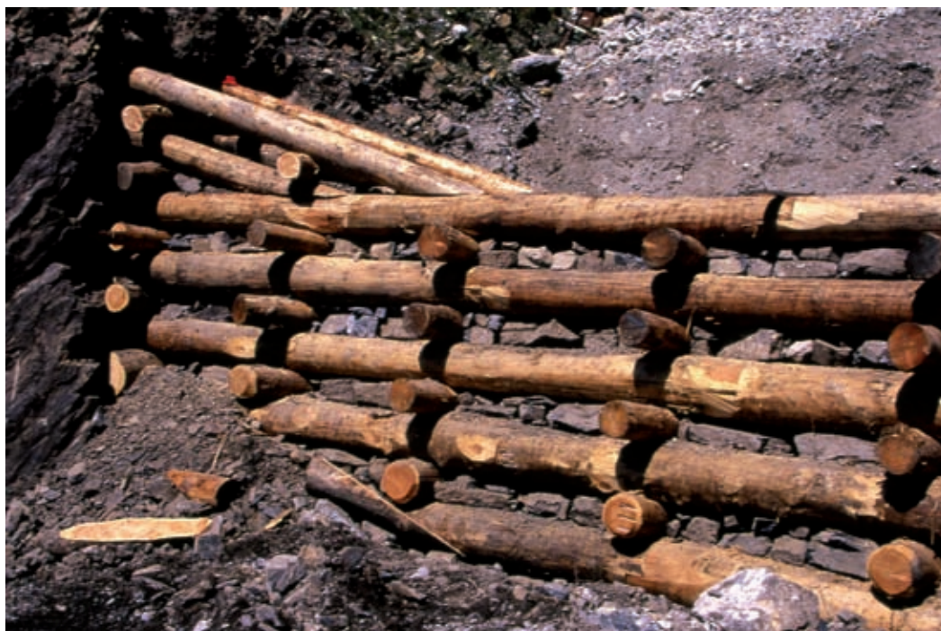
Briglia viva in le- gname e pietra- me. Gaveta a tronchi inclinati (in opera) (Foto R.Ferrari).
