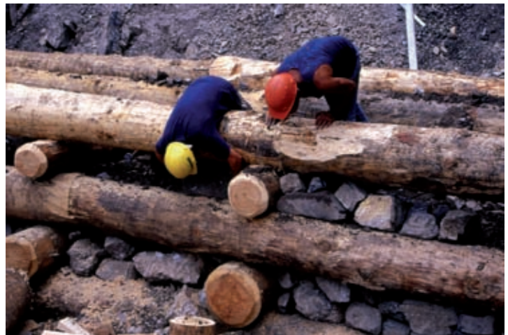
A sinistra: Briglia viva in legname e pietrame. Realizzazione di corsi successivi (in opera) (Foto R.Ferrari). A destra: Briglia viva in legname e pietrame. Realizzazione di corsi successivi (in opera) (Foto R.Ferrari).
