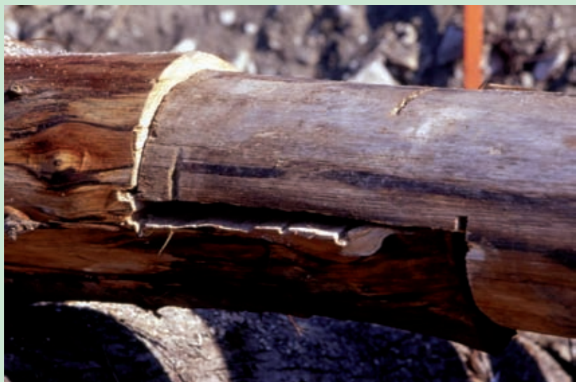
Combaciamento degli elementi (Foto R.Ferrari).
