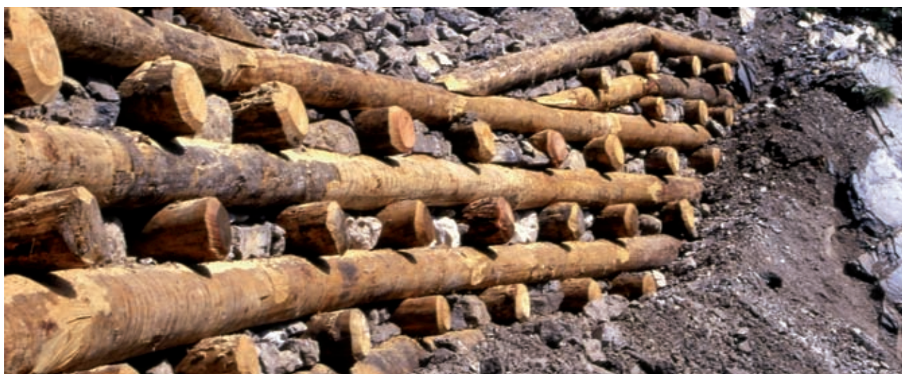
Briglia viva in legname e pietrame. Realizzazione della gaveta (in opera) (Foto R.Ferrari).
