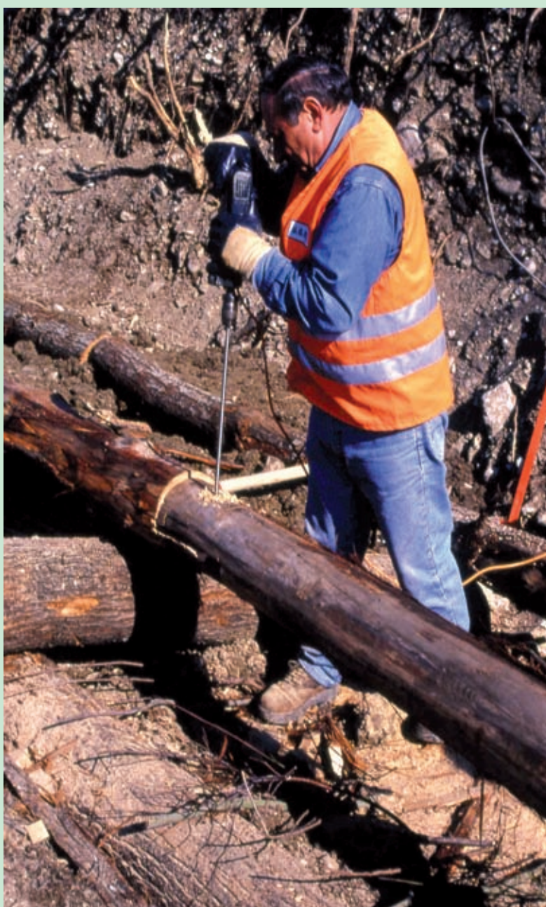
Esecuzione del foro (Foto R.Ferrari).
