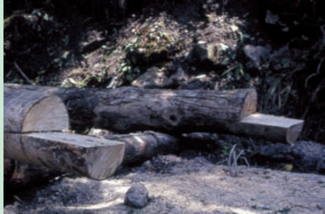
Posizionamento definitivo del primo elemento (Foto R.Ferrari).
