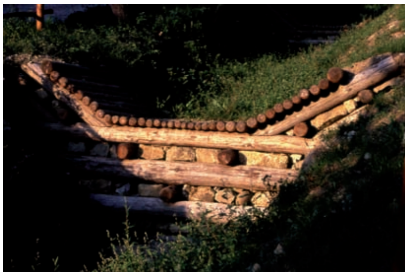
Briglia viva in legname e pietrame. Inserimento della struttura nel contesto naturale (post operam) (Foto R.Ferrari).
