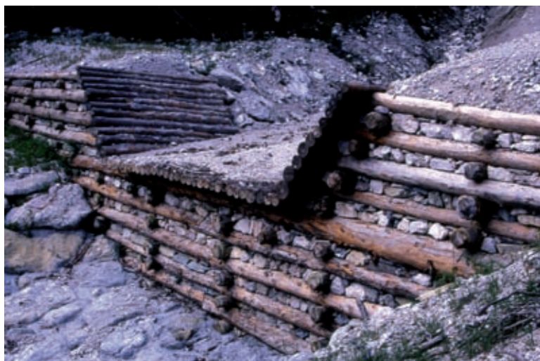
Briglia viva in legname e pietrame. Gaveta a tronchi orizzontali (in opera) (Foto R.Ferrari).
