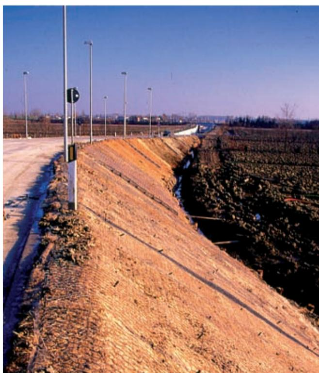
Rivestimento vegetativo in rete metallica zincata e biostuoia s. l. (biofeltro, biostuoia, biorete). Rifinitura e bonifica dell'area di cantiere (in opera) (Foto R.Ferrari).
