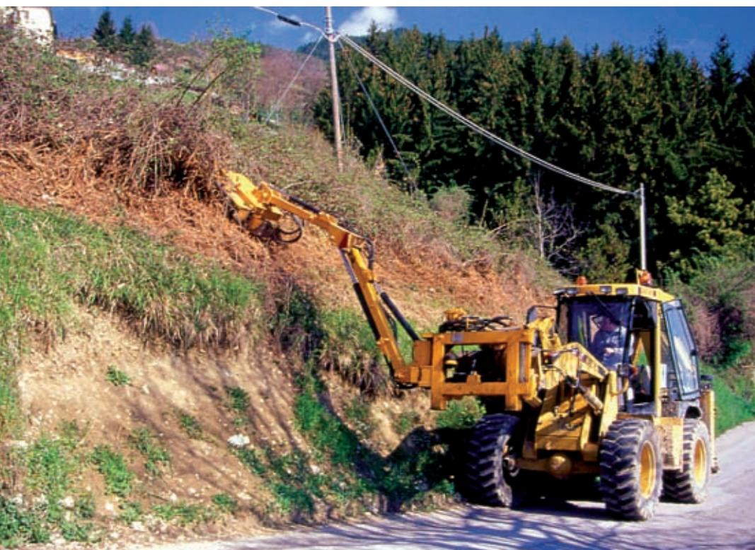
Rivestimento vegetativo in rete metallica zincata e biostuoia s. l. (biofeltro, biostuoia, biorete). Pulizia e disboscio del sito di intervento (in opera) (Foto R.Ferrari).
