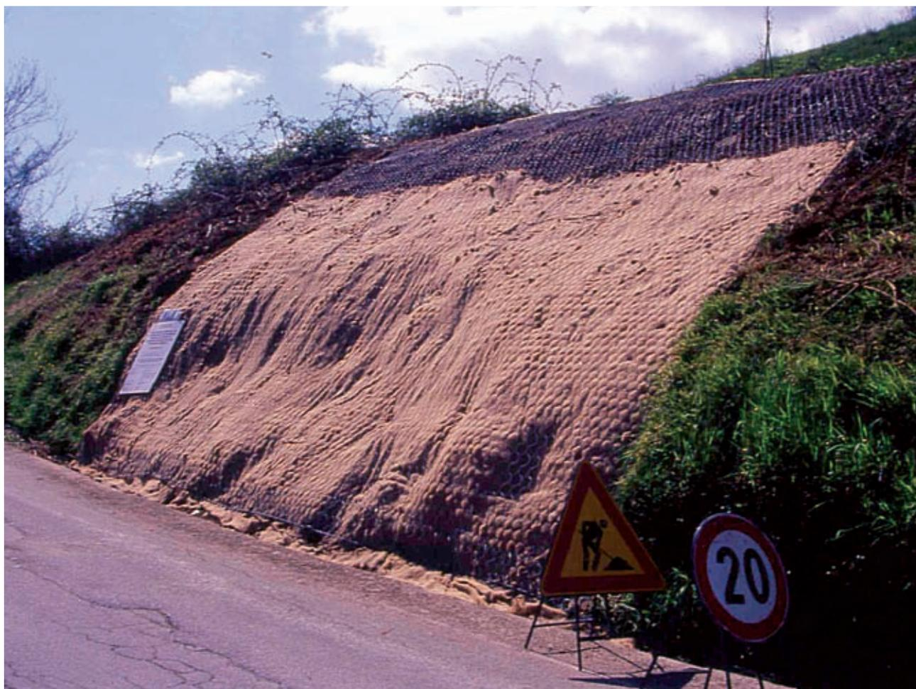
Rivestimento vegetativo in rete metallica zincata e biostuoia s. l. (biofeltro, biostuoia, biarete). Fissaggio di rete metallica zincata sopra biofeltro in cocco con buona aderenza al substrato (in opera) (Foto R.Ferrari).
