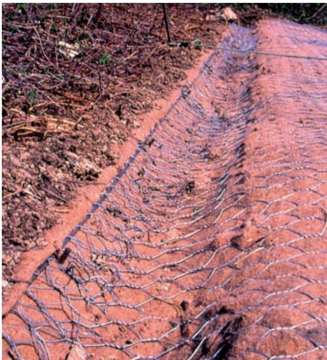
Rivestimento vegetativo in rete metallica zincata e biostuoia s. l. (biofeltro, biostuoia, biorete). Adattamento a canaletta di drenaggio e di deflusso delle acque meteoriche della zona sommitale dell'intervento (in opera) (Foto R.Ferrari).
