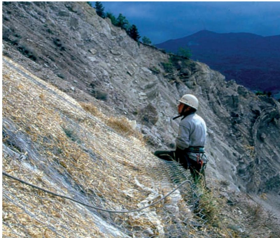
Rivestimento vegetativo in rete metallica zincata e biostuoia s. l. (biofeltro, biostuoia, biorete). Posa di rete metallica zincata sopra biofeltro in paglia (in opera) (Foto R.Ferrari).
