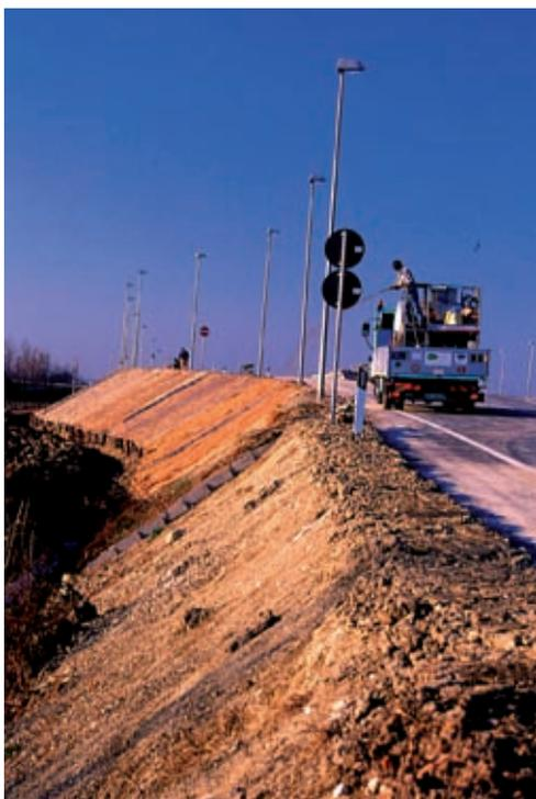
Rivestimento vegetativo in rete metallica zincata e biostuoia s. l. (biofiltro, biostuoia, biorete). Esecuzione di idrosemina sull'intervento (in opera) (Foto R.Ferrari).
