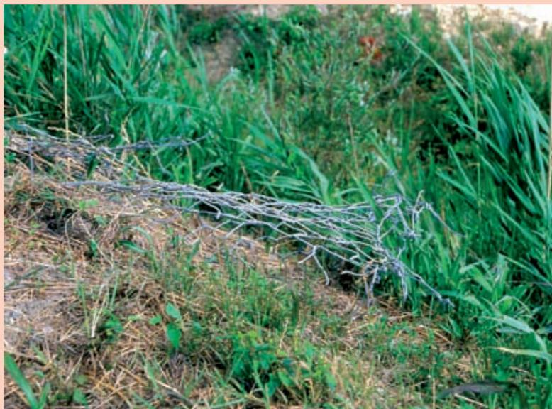
**Rivestimento vegetativo in rete metallica zincata e biostuoia s. l. (biofeltro, biostuoia, biorete). Inadeguato intervento manutentorio di sfalcatura effettuato con mezzi meccanici non idonei che rischia di compromettere l'efficacia strutturale dell'intervento (post opera) (Foto R.Ferrari).**
