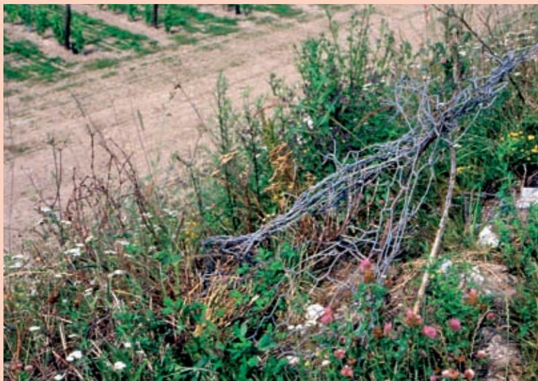
Rivestimento vegetativo in rete metallica zincata e biostuoia s. l. (biofiltro, biostuoia, biarete). Inadeguato intervento manutentorio di sfalciatura effettuato con mezzi meccanici non idonei che rischia di compromettere l'efficacia strutturale dell'intervento (post opera) (Foto R.Ferrari).
