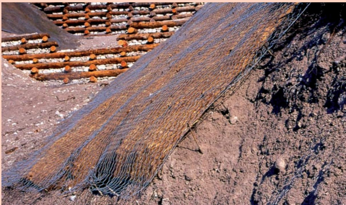
Rivestimento vegetativo in rete metallica zincata e biostuoia s. l. (biofeltro, biostuoia, biorete). Inadeguato fissaggio di rete metallica zincata sopra biofeltro in paglia con conseguente disarticolamento strutturale e vanificazione della funzionalità antierosiva superficiale; inoltre totale assenza di materiale vegetale vivo: non può essere considerata un'opera di Ingegneria Naturalistica (post opera) (Foto R.Ferrari).
