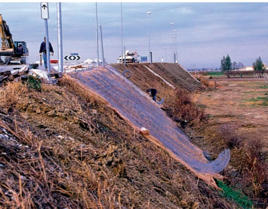
**Rivestimento vegetativo in rete metallica zincata e biostuoia s. l. (biofeltro, biostuoia, biorete). Legatura di singoli elementi (rotoli) di rete metallica zincata contigui (in opera) (Foto R.Ferrari).**
