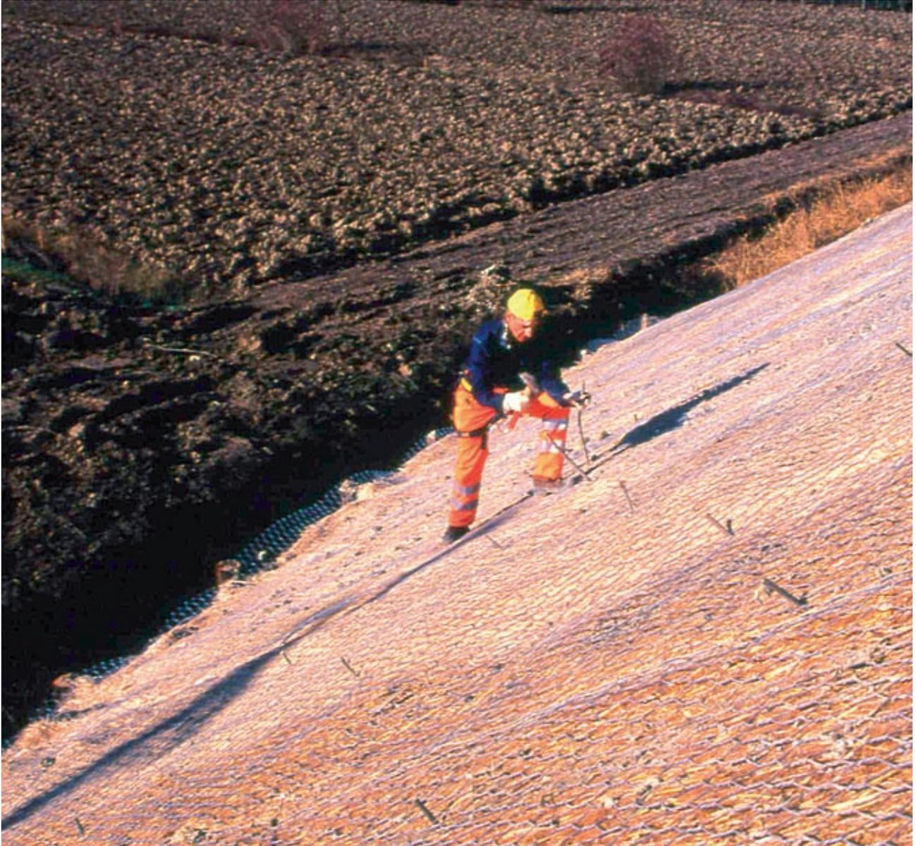
**Rivestimento vegetativo in rete metallica zincata e biostuoia s. I. (biofeltro, biostuoia, biorete). Inserimento di talee (*SALIX PURPUREA*) mediante infissione (in opera) (Foto R.Ferrari).**
