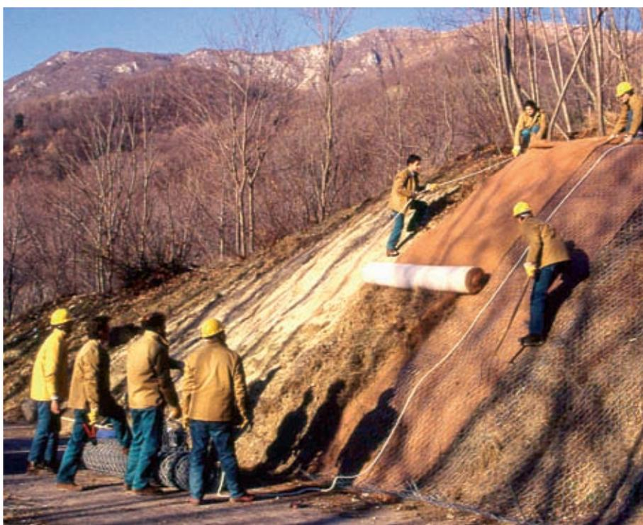
Rivestimento vegetativo in rete metallica zincata e biostuoia s. l. (biofeltro, biostuoia, biorete). Posa di biofeltro in cocco (in opera) (Foto R.Ferrari).
