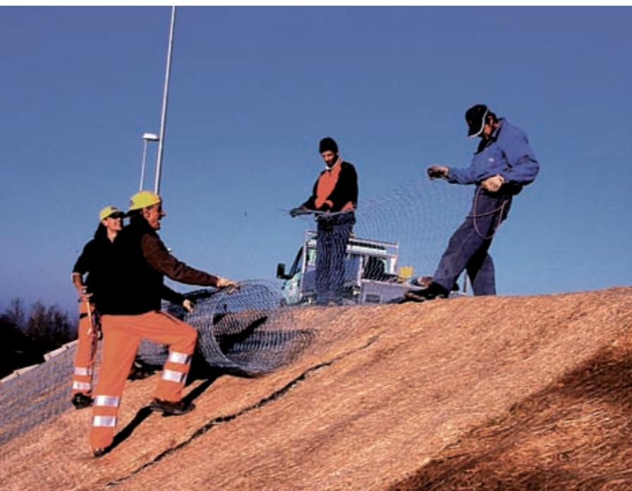
Rivestimento vegetativo in rete metallica zincata e biostuoia s. l. (biofeltro, biostuoia, biorete). Posa di rete metallica zincata sopra biofeltro in paglia (in opera) (Foto R.Ferrari).
