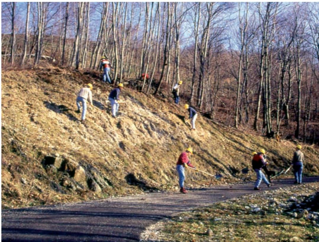
**Fase 2** - Predisposizione della sede di posa mediante scavo di un solco con sezione a U della profondità di circa 20÷30 cm., in prossimità della sommità della scarpata. Tale operazione viene effettuata o mediante l'utilizzo del mezzo meccanico ed eventualmente completata manualmente, o direttamente a mano: la scelta deriva dall'entità (quantità in ml) da realizzare (Dis. 2).
