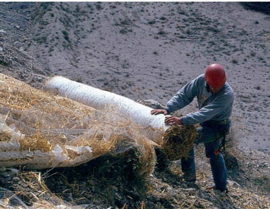
Rivestimento vegetativo in rete metallica zincata e biostuoia s. l. (biofeltro, biostuoia, biorete). Posa di biofeltro in paglia (in opera) (Foto R.Ferrari).
